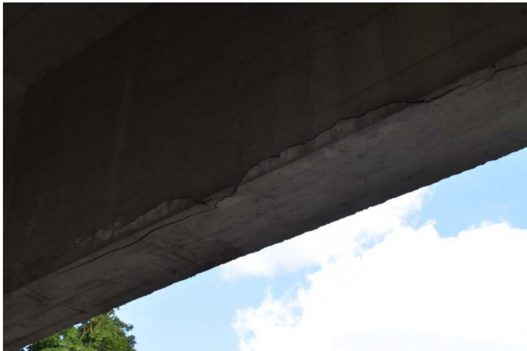
12 pav. Išilginiai sijos plyšiai.
