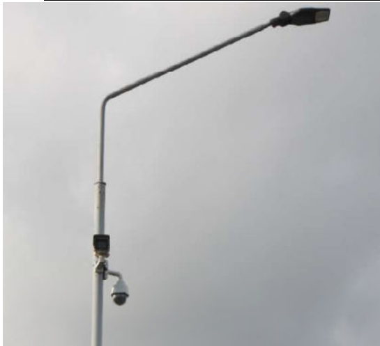
3 pav. Ant statinio apšvietimo stulpo įrengta kamera
