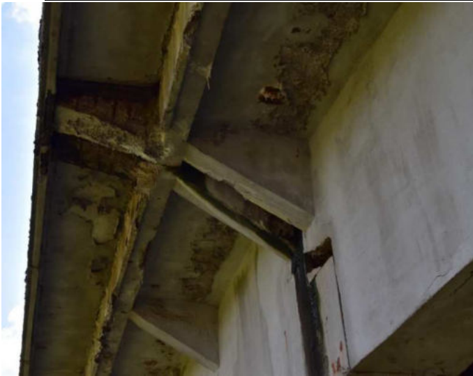
10 pav. Nesandarūs deformaciniai pjūviai, praleidžia vandenį ant perdangos sijų, plokščių galų ir atramų, matomos ant betoninių paviršių susidariusių žalių plotų.
