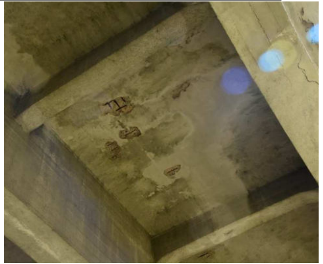
11 pav. Vietomis betonas plokštėje yra ištrupėjęs, matoma koroduojanti armatūra.
