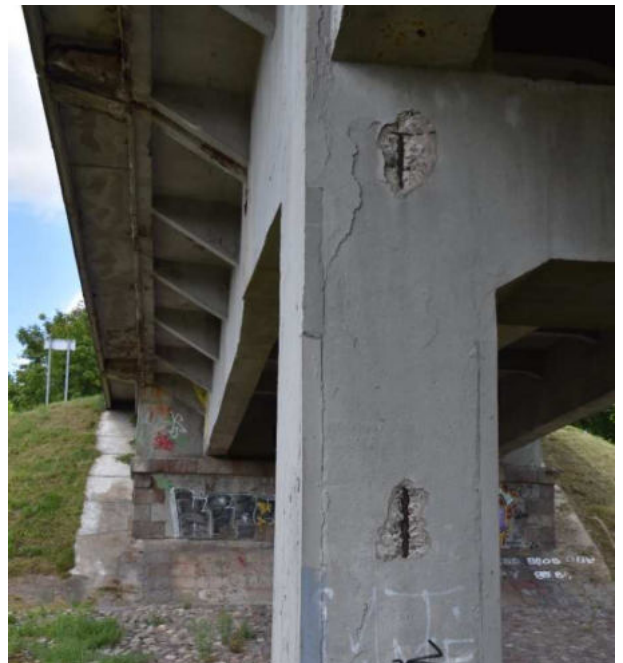
16 pav. Vietomis taurų apsauginiai betono sluoksniai aptrupėję ir matoma koroduojanti armatūra.
