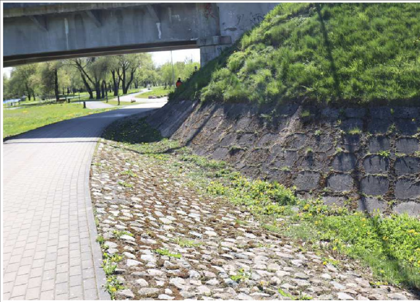
Nuo statinio surinktas vanduo išleidžiamas į esamą akmenų mėtinio išgristą griovėlį
