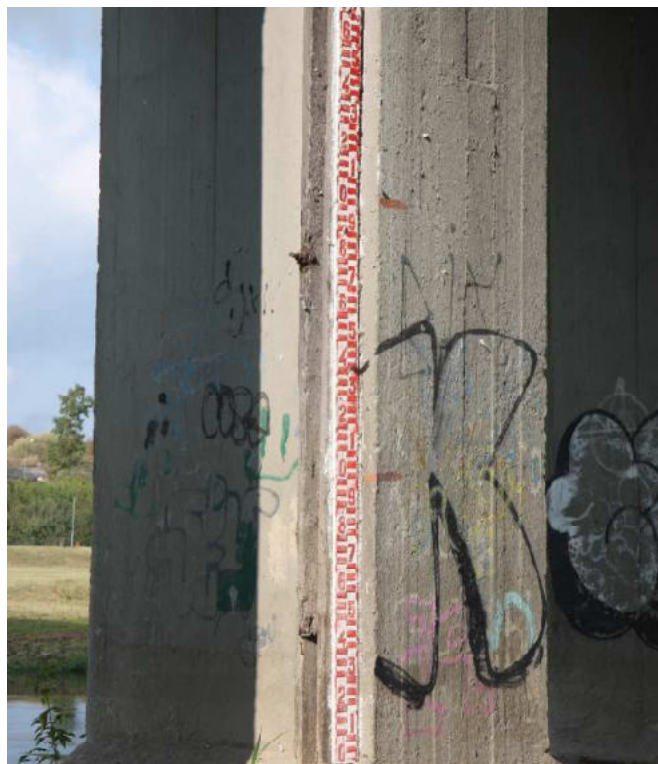
5 pav. Vandens aukščio matuoklė ant statinio, su pažymėtais aukščiais
