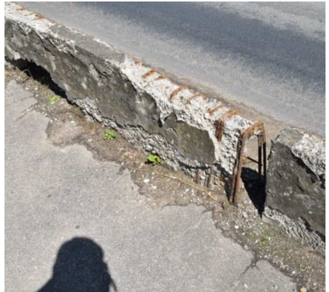
7 pav. Aptrupėjęs apsauginis bortų paviršius
