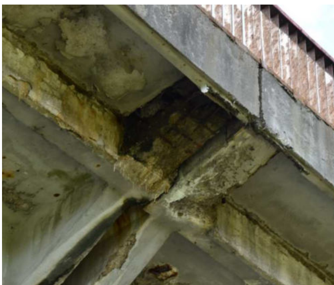
8 pav. Šalitelčio plokštės laikančių konsolių apsauginiai betono sluoksniai aptrupėję, matoma korduojanti armatūra. Šalitelčio plokštės ir jas laikančios konstrukcijos drėkinamos, plaunami iš betono karbonatai.
