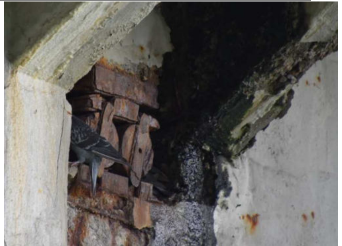
14 pav. Ant betono matoma žalių plotų. Plieniniai guoliai pažeisti korozijos.
