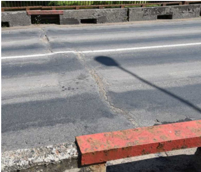
6 pav. Asfalto dangoje ir ties deformaciniais pjūviais susidariusios provėžos ir plyšiai
