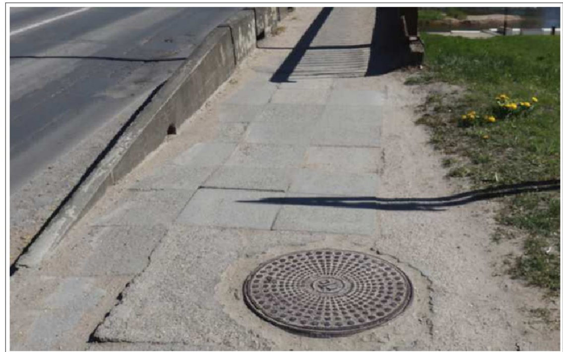
Senamiesčio pusėje, iki brėžiniuose nurodytos ribos esamos plytelės išardomos ir įrengiama nauja plytelių (500x500x80 mm) danga
