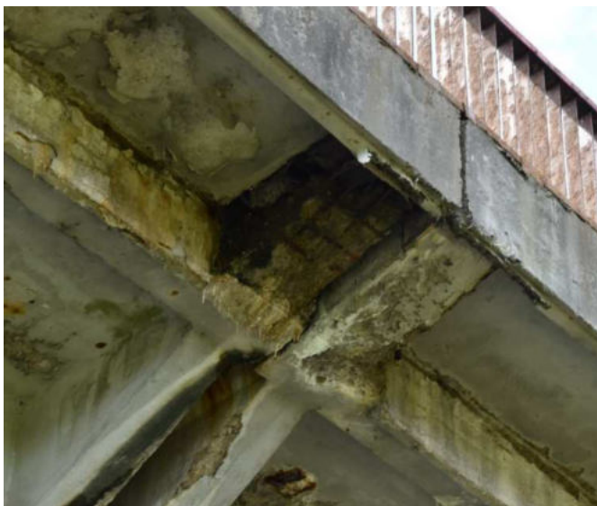
8 pav. Šaltilčio plokštės laikančių konsolių apsauginiai betono sluoksniai aptrupėję, matoma koroduojanti armatūra. Šaltilčio plokštės ir jas laikančios konstrukcijos drėkinamos, plaunami iš betono karbonatai.
