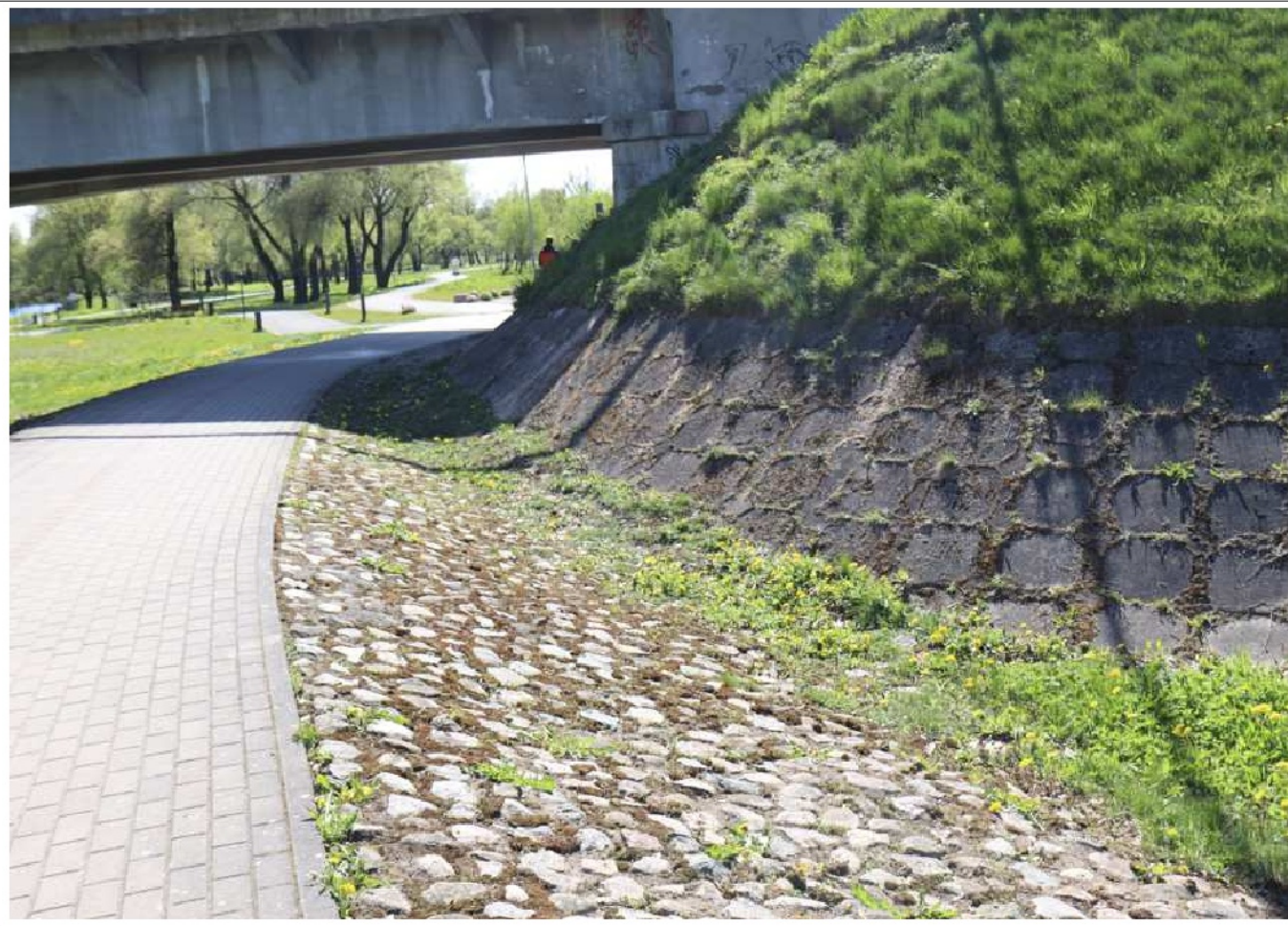
Nuo statinio surinktas vanduo išleidžiamas į esamą akmenų mėtinio išgrįstą griovėlį
