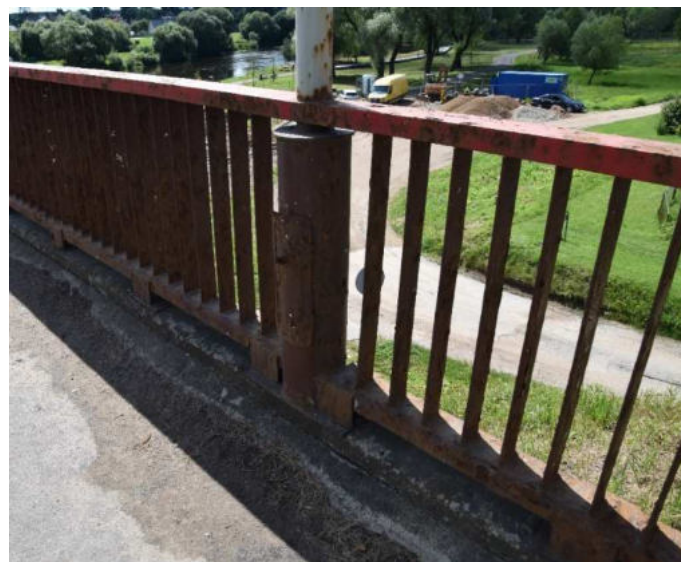
9 pav. Tiltų turėklų apsauginis dažų sluoksnis nusidevėjęs, matoma paviršinė korozija.
