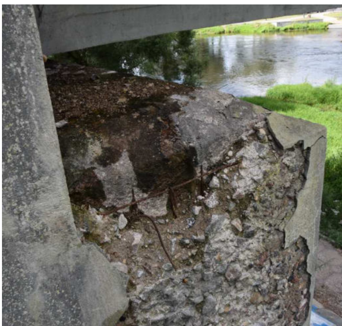
15 pav. Nuo ramtų aptrupėjęs betonas, matoma koroduojanti armatūra. Ant ramtų laikosi vanduo.
