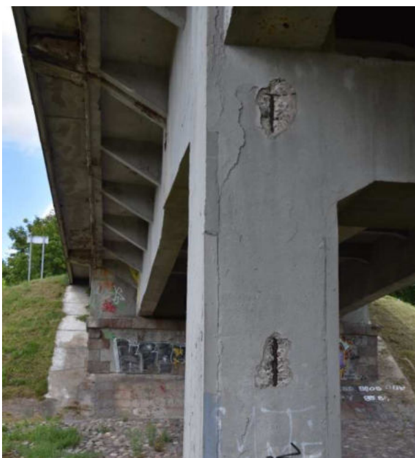
16 pav. Vietomis taurų apsauginiai betono sluoksniai aptrupėję ir matoma koroduojanti armatūra.
