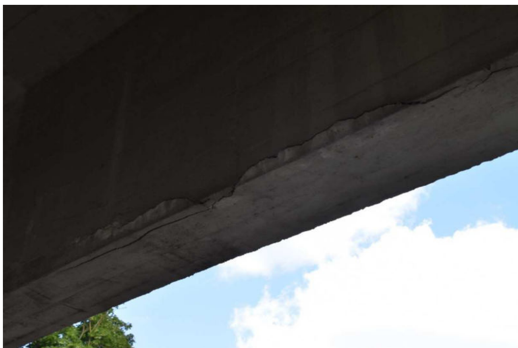
12 pav. Išilginiai sijos plyšiai.
