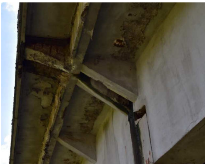
10 pav. Nesandarūs deformaciniai pjūviai, praleidžia vandenį ant perdangos sijų, plokščių galų ir atramų, matomos ant betoninių paviršių susidariusių žalių plotų.
