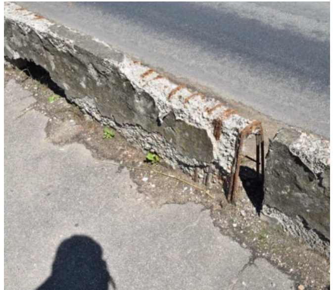
7 pav. Aptrupėjęs apsauginis bortų paviršius
