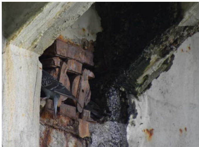
14 pav. Ant betono matoma žalių plotų. Plieniniai guoliai pažeisti korozijos.
