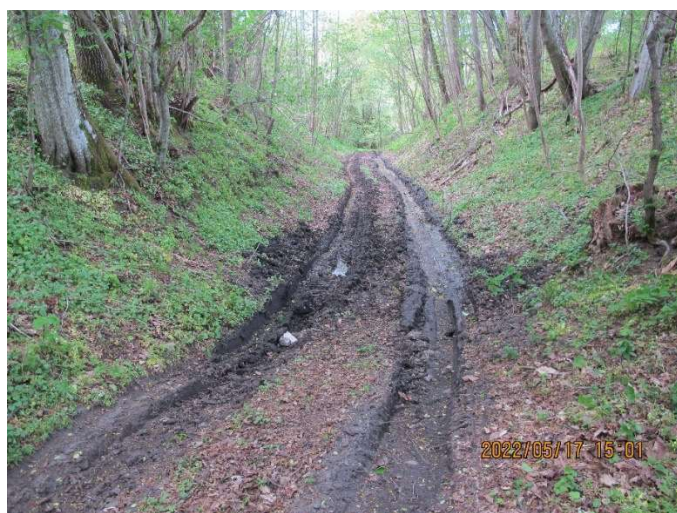
Esami išvažinėjimai teritorijos ŠR dalyje. Projektuojamas paviršinės erozijos židinių panaikinimas
