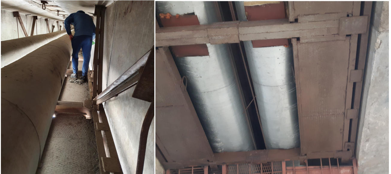
Pav. 13 Šiluminę trasą laikanti konstrukcija
