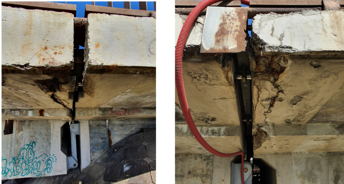
Pav. 9 Viaduko paklotas: deformacinės siūlės
