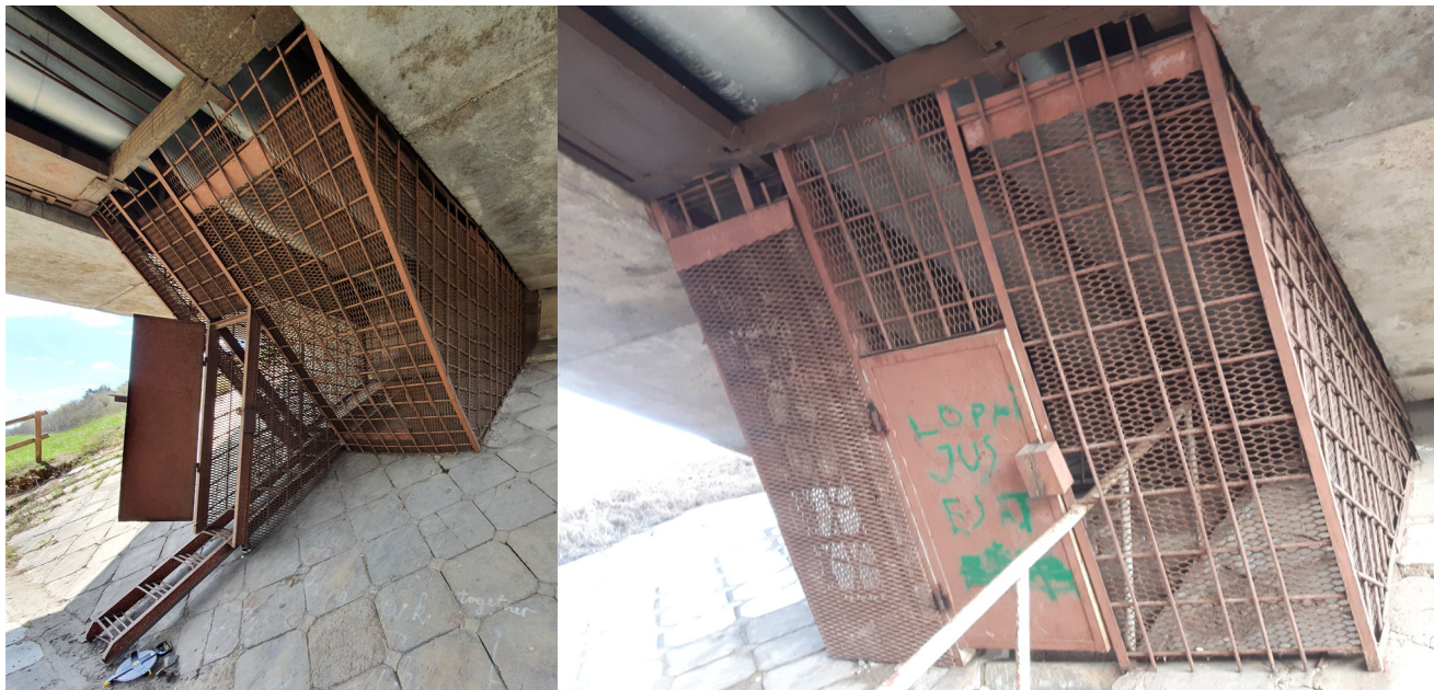
Pav. 11 Patekimo į perdangos vidų konstrukciją tilto galuose
