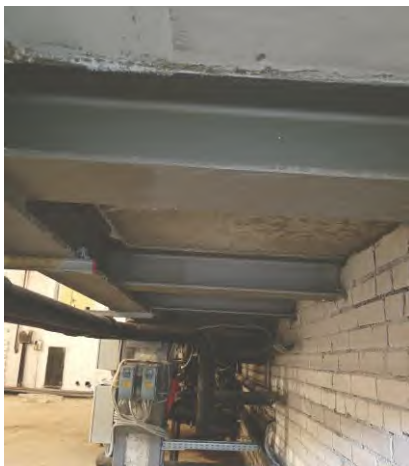
11 pav. Duomenų centre maždaug 2,0 m aukštyje nuo R-9 patalpos grindų įrengta gelžbetonio perdanga, kuri atremta ant metalinių sijų tinklo.
