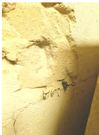
18 pav. Ant blokų įrengta horizontali hidroizoliacija prieš silikatinių plytų mūrą.
