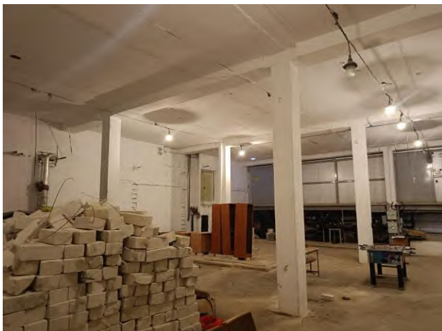
9 pav. Patalpos R-9 (plane pažymėta žalia spalva) bendras konstrukcijų vaizdas.
