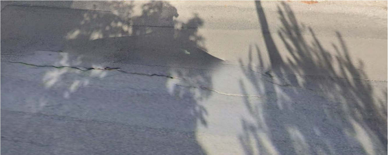
3 paveikslas. M. Valančiaus gatvės asfalto danga. Fotofiksacija 2024 m. liepa.
