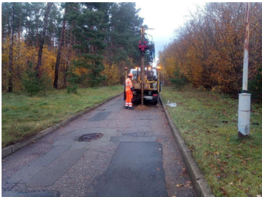
1 pav. Lauko darbai
