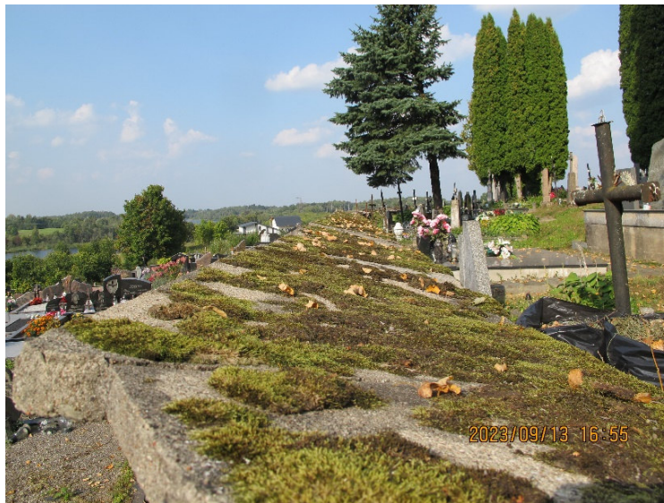
Apaugęs samanomis tvoros viršaus betono stogelis ŠV dalyje
