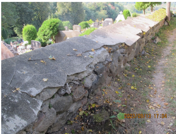
Suiręs tvoros viršaus betono stogelis P sklypo dalyje
