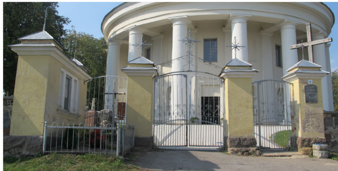
Sudervės Švč. Trejybės bažnyčios statinių komplekso tvoros su vartais ir koplyčia fragmentas. Vaizdas iš rytų pusės
