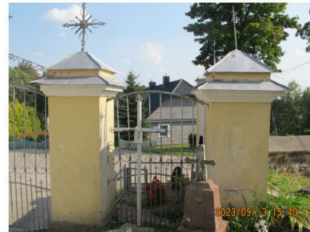
Koplytėlės sienų tinkas sutrūkinėjęs, apatinėje dalyje pažaliavęs
