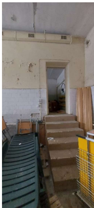
4 pav. Dažų atsilupinėjimai iš vidaus ant sienų
