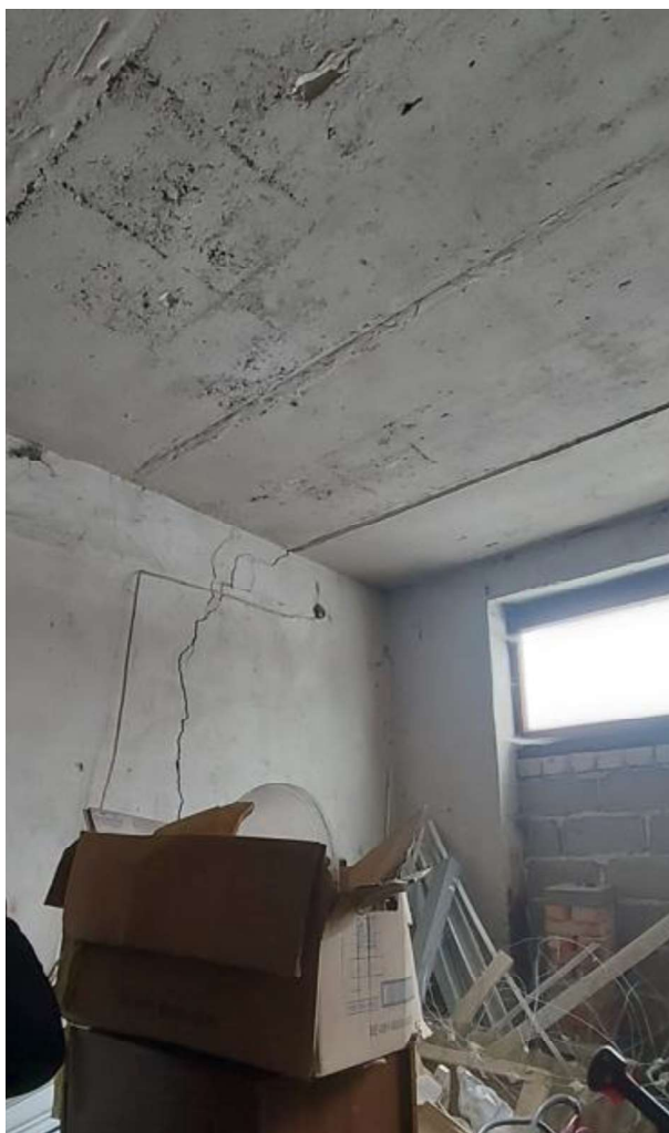
1 pav. Įtrūkimai laikančiojoje sienoje
