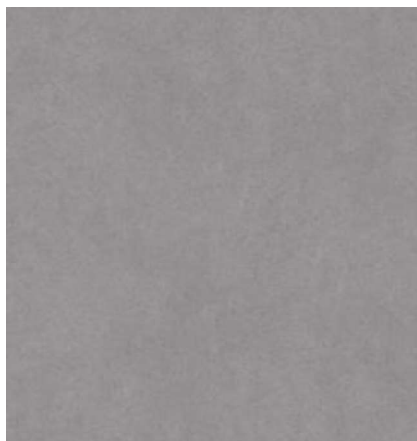
5 pav. Grindų dangos plytelės
