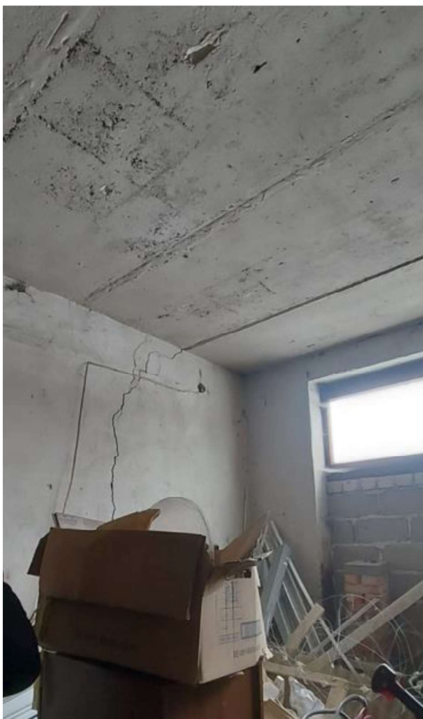
1 pav. Įtrūkimai laikančiojoje sienoje
