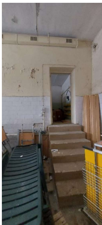
4 pav. Dažų atsilupinėjimai iš vidaus ant sienų
