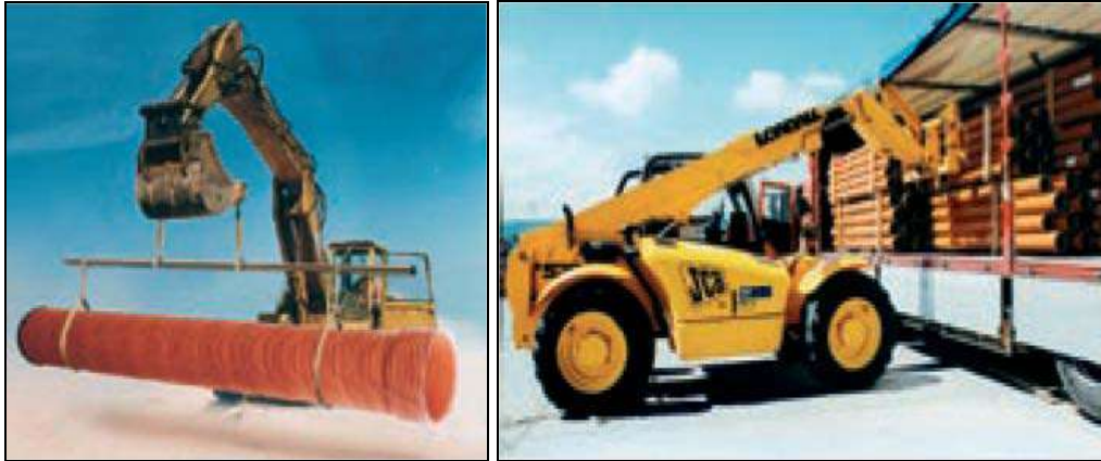
4 paveikslas. Mechanizuotas vamzdžių krovimas
