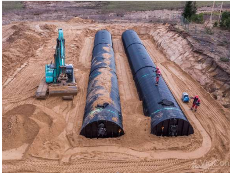
5 pav. Abiejų pusių simetriškas užpylimas ir tankinimas
