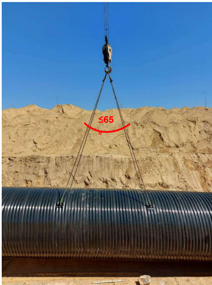
2 pav. Rezervuaro stropavimas
