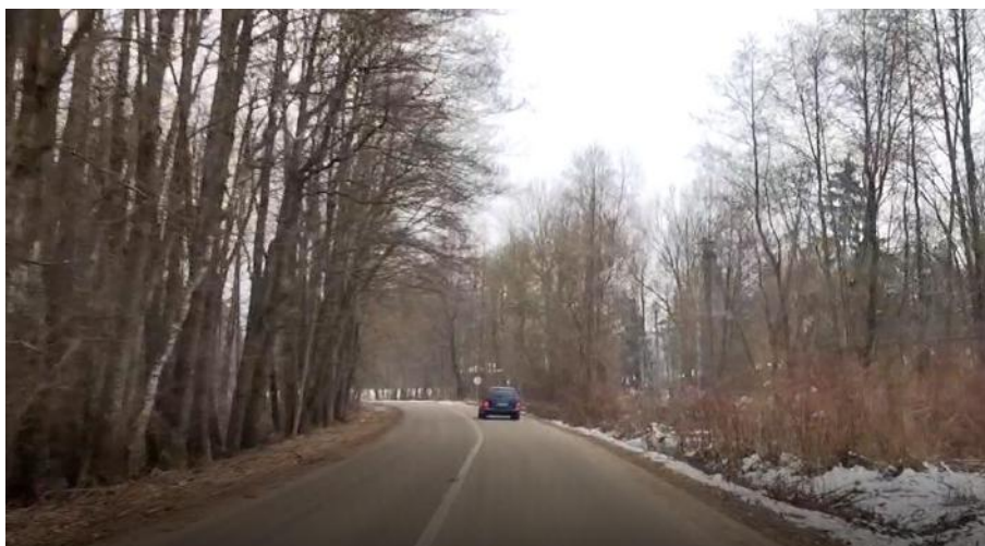
Pav.2 Kelio esama būklė
