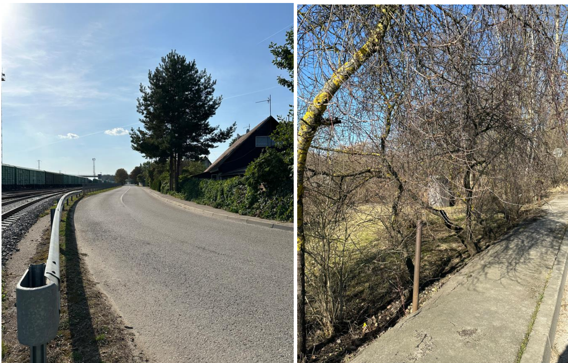
1 pav. Esama statinių būklė
