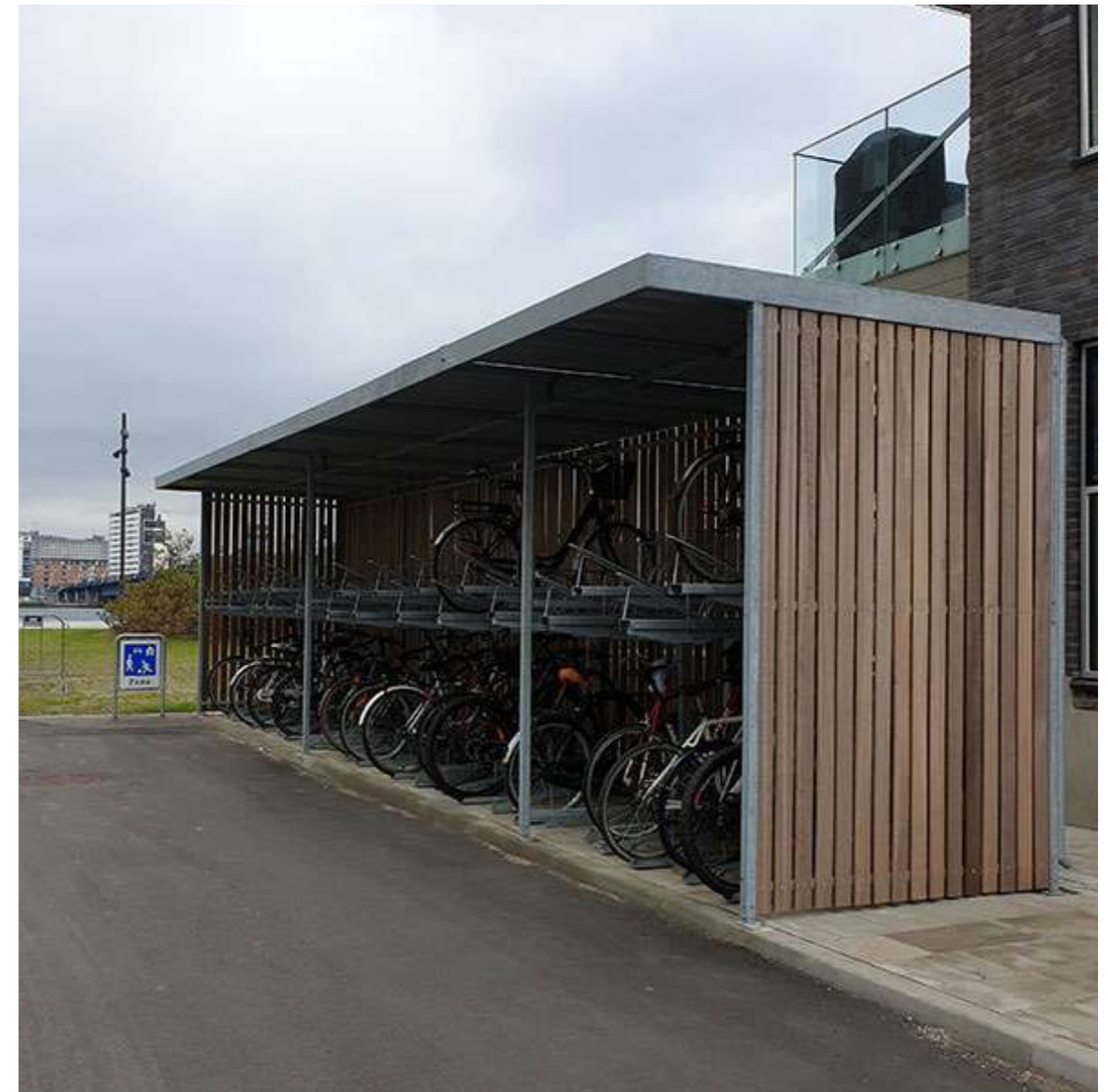
151 pav. Olandų gamintojo Falco pavyzdys FalcoZan-180 – 180 cm gylio dviaukštė dviračių saugykla
