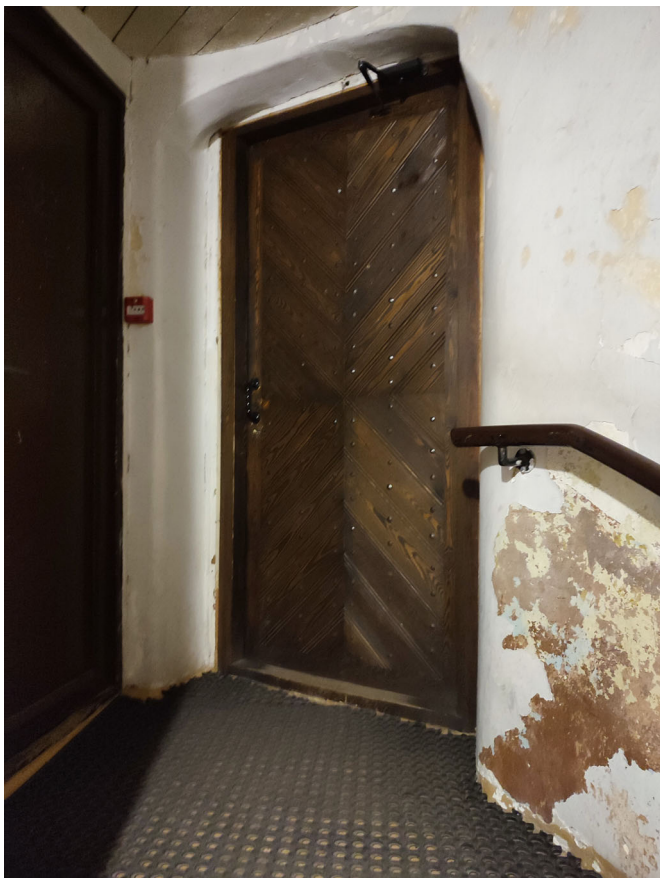
Iėjimo tambūras. Sienų apdaila pažeista- nutrupėjęs tinkas, atsilupę dažų sluoksniai
