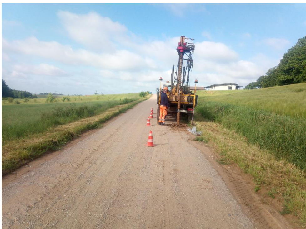
1 pav. Lauko darbai
