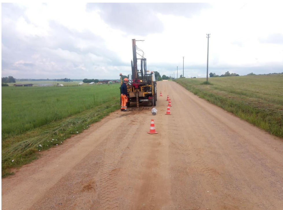
1 pav. Lauko darbai
