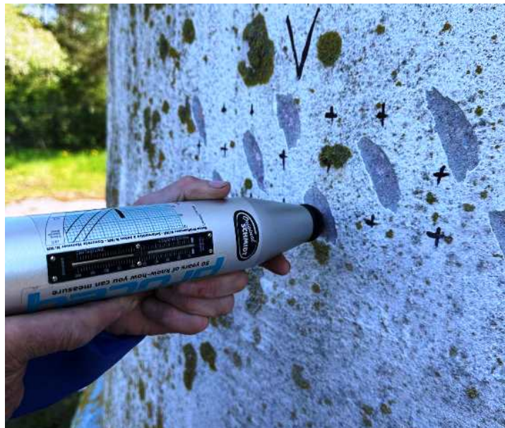
Pav. 6.2 betono stiprio testas Šmidto plaktuku
