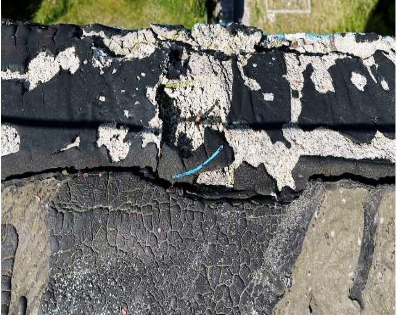
R4 – denginio dangoje prie parapeto įtrūkis iki 30 mm pločio;
