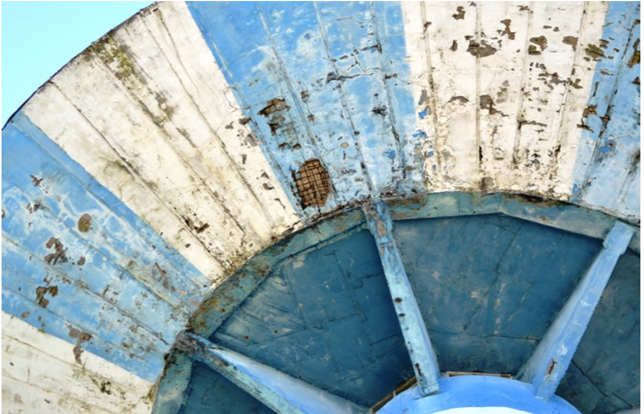
R 2 – atviros armatūros intensyvi korozija
