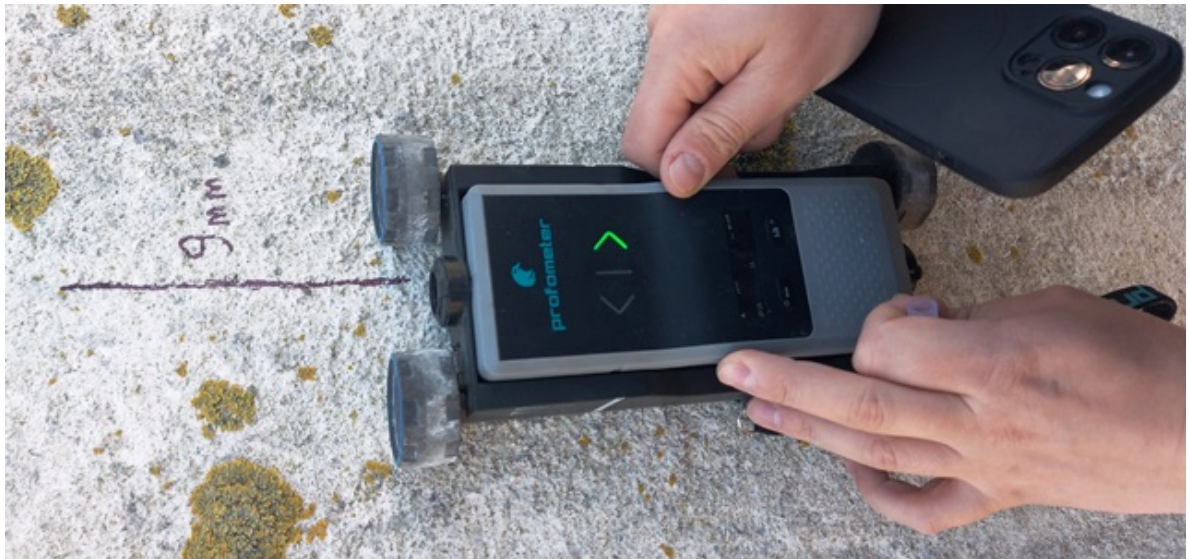
Pav. 6.3 armatūros ieškojimas
