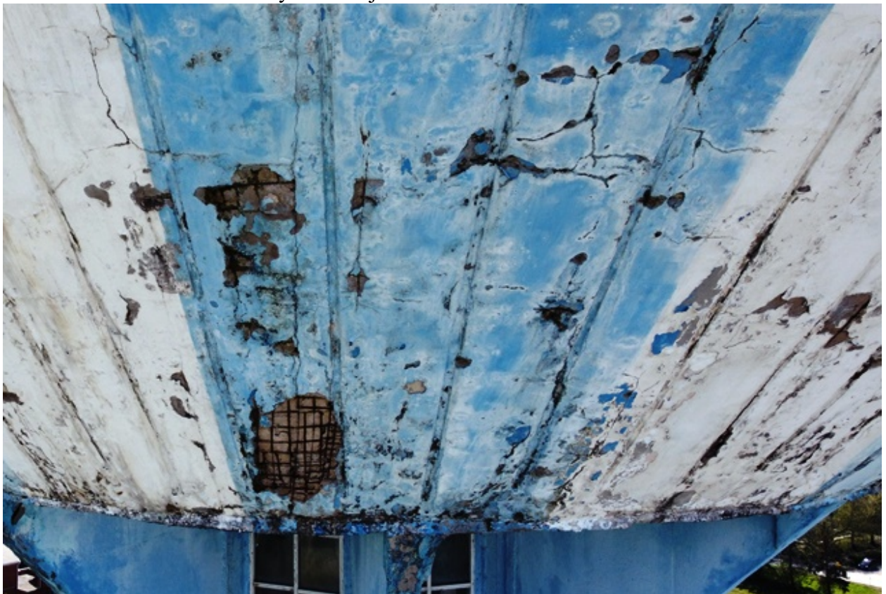
R 2 – atviros armatūros intensyvi korozija
