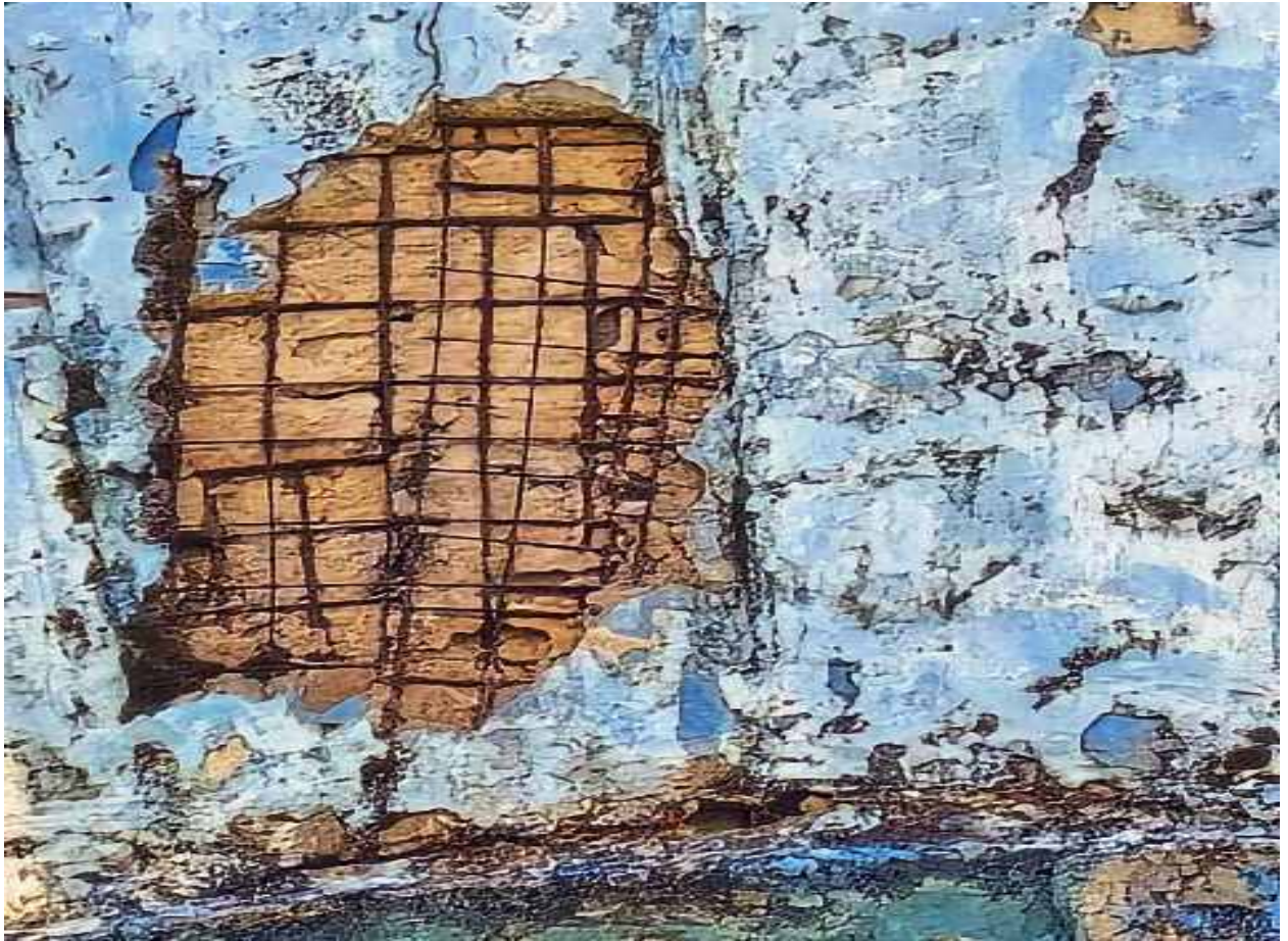
R 3 – rezervuaro denginio danga susidėvėjusi su defektais
