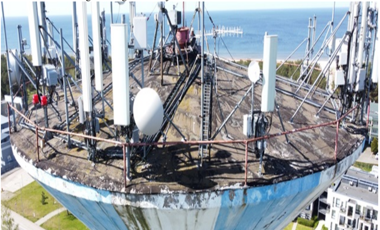
R 3 – rezervuaro denginio danga susidėvėjusi su defektais
