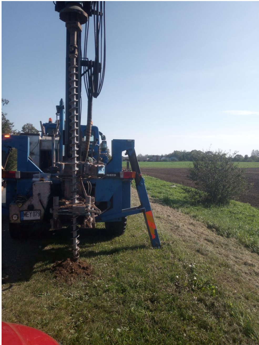
1 pav. Lauko darbai
