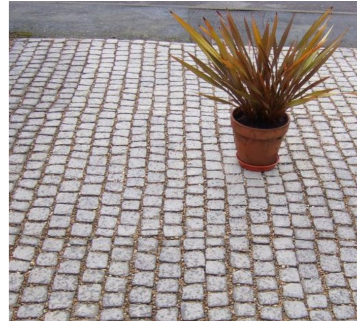
Įrengto „Progressus Group“ vandeniui laidaus grindinio „Akmens takas“ pavyzdys (nuotr. www.progressusgroup.lt )
