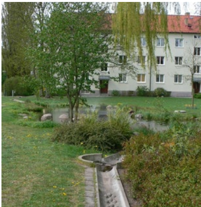
Augustenburgo rajone suprojektuoti latakai padeda vandeniui judėti tarp tvenkinių, o cirkuliaciniai siurbliai, nedideli vandens kriokliai ir fontanai padeda išvengti per didelio dumblių augimo, nuotr. Va SYD (n.d.).
