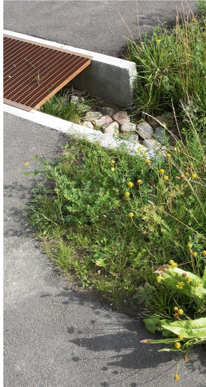
Paviršinių nuotekų nukreipimo į žaliuosius plotus detalė gyvenamajame komplekse Værløse miestelyje Danijoje (arch. ir nuotr. Juul Frost)
