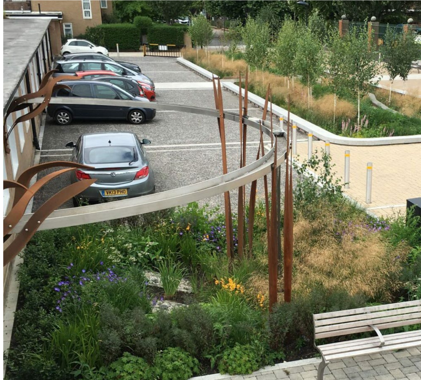
Lietaus sodai pertvarkytoje mokyklos stovėjimo aikštelėje Bridžet Džois aikštėje, Londone, JK. Nuo mokyklos stogo surenkamas lietaus vanduo yra nukreipiamas į nuotraukos pirmajame plane esantį lietaus sodą skulptūriškais metaliniais latakais, taip išryškinant vandens judėjimą. Ant stovėjimo aikštelės susidarančios paviršinės nuotekos švelniu paviršiaus nuolydžiu yra nukreipiamos link nuotraukos antrajame plane matomo lietaus sodo, kurio betoniniame perimetre yra suformuotos specialios pailgos pratekėjimo angos (k. arch. Robert Bray Associates, nuotr. 46Photography)
