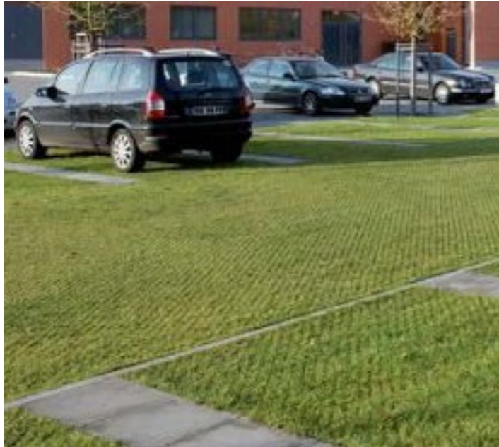
Plastikiniu koriu sutvirtinta veja, naudojama kaip papildoma stovėjimo aikštelė (nuotr. www.bouwinfo.be)
