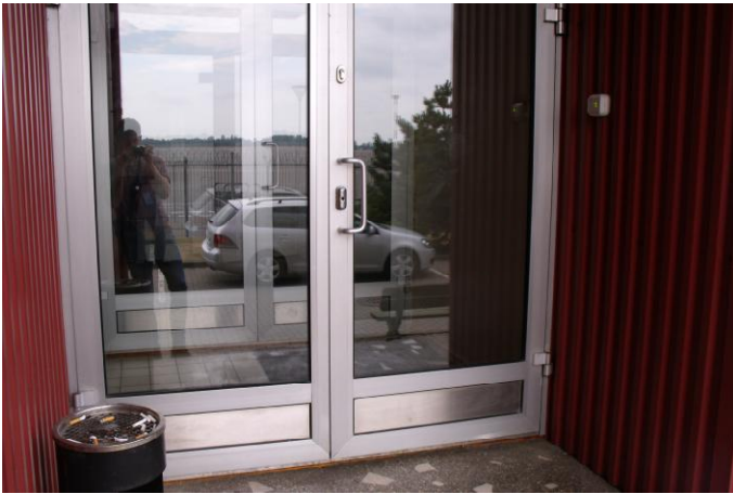
22 pav. Prastai šilumą izoliuojančios aliuminio rėmo durys.
