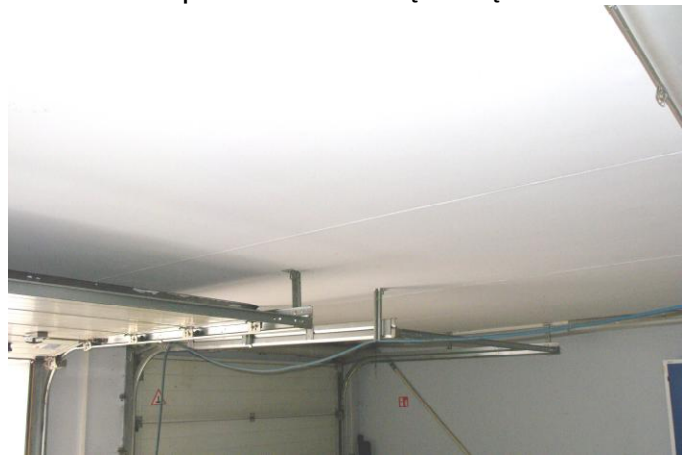
54. Matomos perdangos plokštės perdengiančios garažo patalpą.
