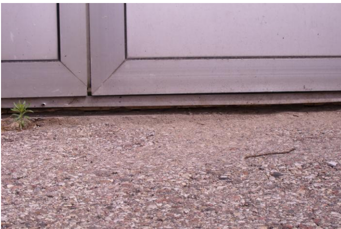
29. Atsiradęs tarpas ties durų apačia per kurį vyksta šilumos mainai.
