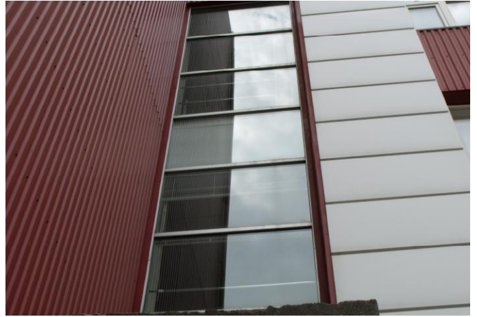
27 pav. Laiptinių langai iš aliuminio profilio, kurie prastai izoliuoja šilumą ir sudaro šalčio tiltelius.
