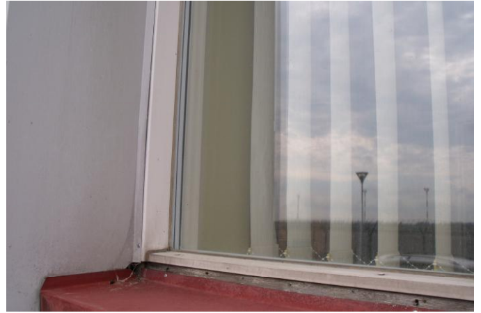
8. Langų angokraščiai mediniai, nesandarūs, blogai izoliuojantys šilumą.
