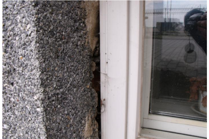
14. Ties rūsio langu atsiradęs plyšys.
