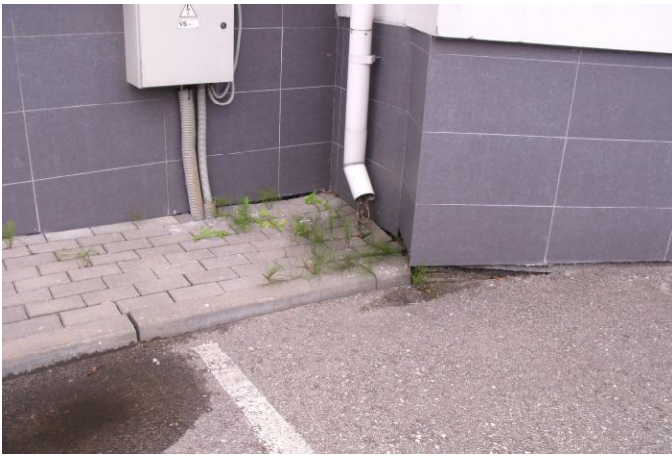
31 pav. Vanduo nuo stogo nuvedamas ties pamatais ir šalia elektros įvado.
