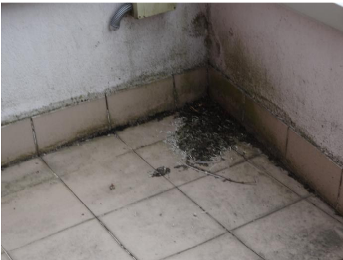
69 pav. Terasos kampe užsistovi vanduo.
