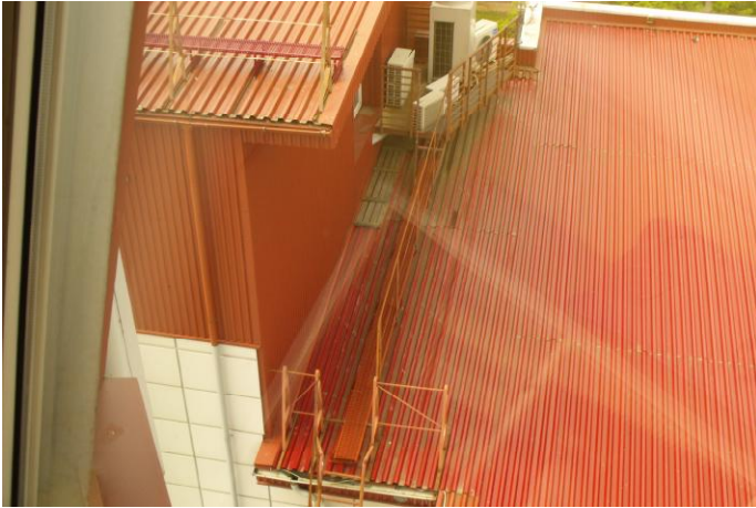
7. Tiriamo objekto stogo vaizdas. Nėra įrengta lipynė patekimui ant stogo.
