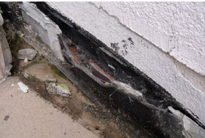
53. Balkono grindjuostė iš plytelių nukritusi.
