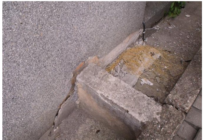
4 pav. Šviesduobėse blogai įrengta drenažinė sistema, vanduo laikosi ir ardo cokolį. Matomas atšokęs cokolio tinkas.
