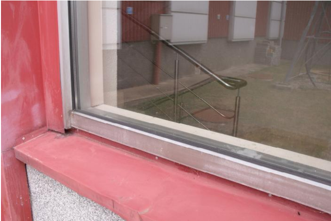
25. Laiptinių langai iš aliuminio profilio, kurie prastai izoliuoja šilumą ir sudaro šalčio tiltelius.
