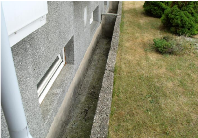
3 pav. Įrengtos šviesduobės rytinėje pastato dalyje.
