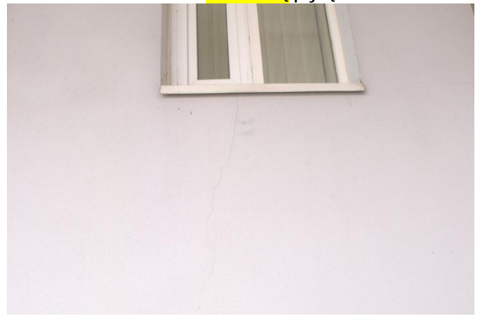
20 pav. Vakarinėje pastato dalyje užfiksuoti mikro įtrūkimai sienoje ties langų angomis.
