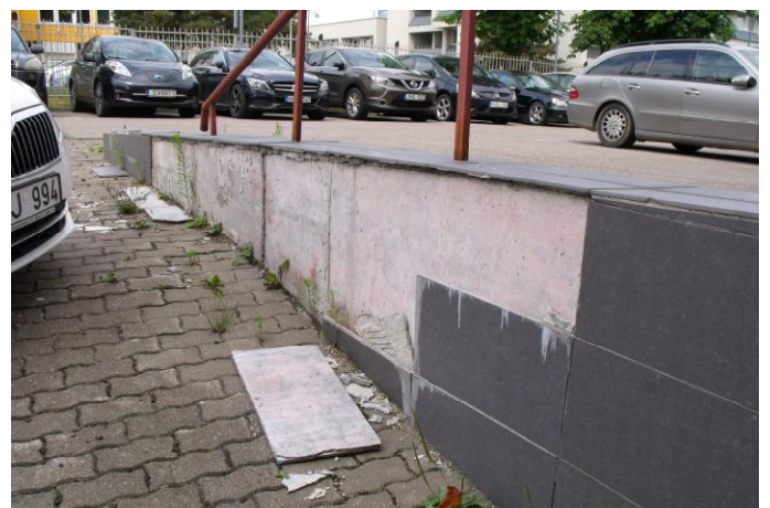
12 pav. Nukritusios nuovažos atraminės sienutės apdailinės plytelės.
