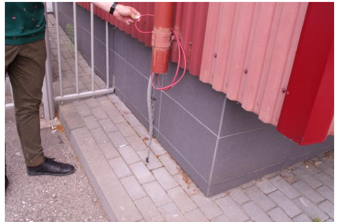
32 pav. Trūksta dalies lietvamzdžio. Surinktas nuo stogo vanduo nuvedamas ties pamatais.
