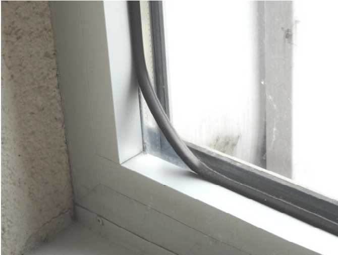
73. Langų sandarumą užtikrinanti guma susidėvėjusi, susitraukusi, praradusi elastingumą
