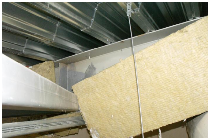
59. Matoma denginį laikanti konstrukcija – portalinis rėmas.
