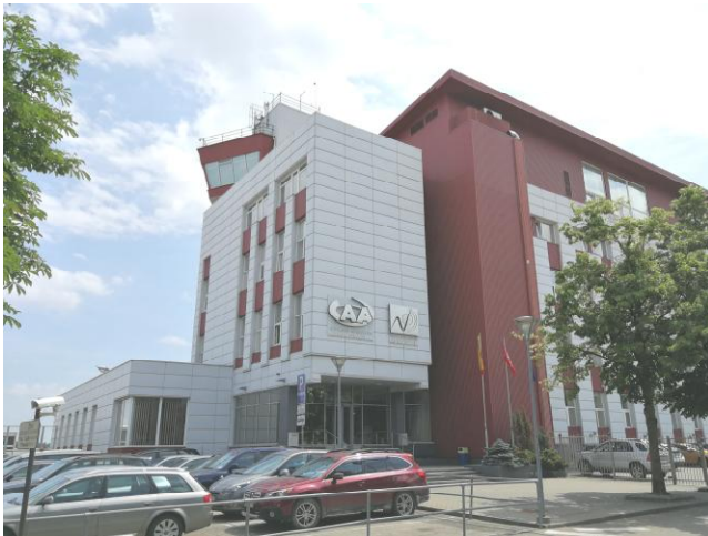
1 pav. Pagrindinis pastato fasadas iš šiaurės-vakarų pusės.
