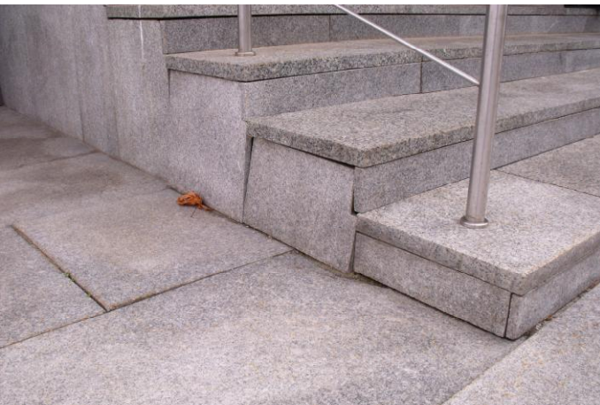
47. Paradinių laiptų apdailinės plokštės atšokusios, praradusios savo pradinę poziciją.
