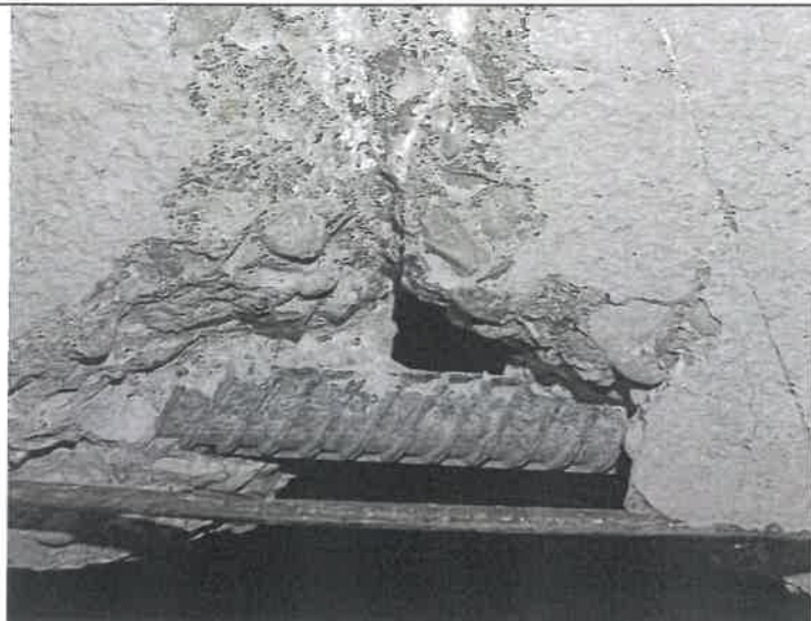
Atidengta plokštės darbinė armatūra
