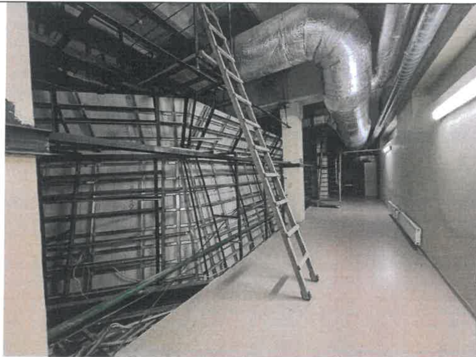
Lubų konstrukcijos bendras vaizdas
