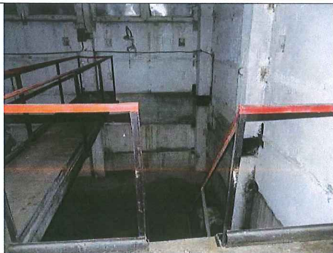
Vertinamo pastato - boilerinės vidaus patalpų fragmentas
