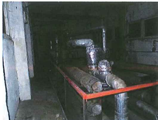
Vertinamo pastato - boilerinės vidaus patalpų fragmentas
