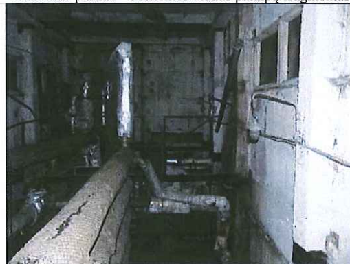
Vertinamo pastato - boilerinės vidaus patalpų fragmentas
