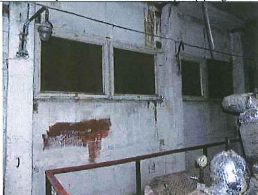
Vertinamo pastato - boilerinės vidaus patalpų fragmentas
