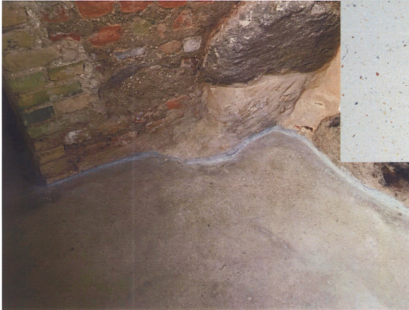
Pvz. 1 Grindų su mūro siena vietos išpildymas, betono grindų paviršiaus pavyzdys
