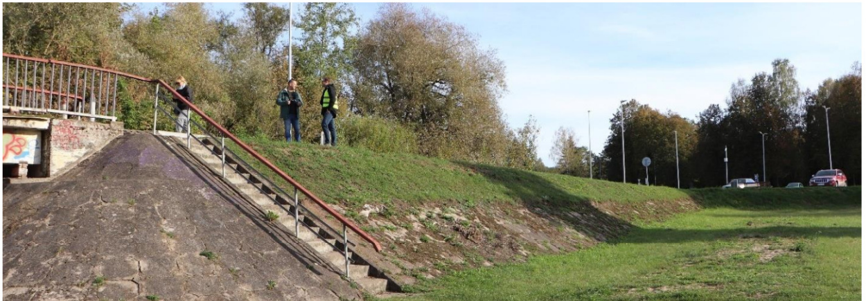
6 pav. Pylimas pratęsiantis pėsčiųjų ir dviratininkų taką nuo tilto link Gruodžio 17-osios g
