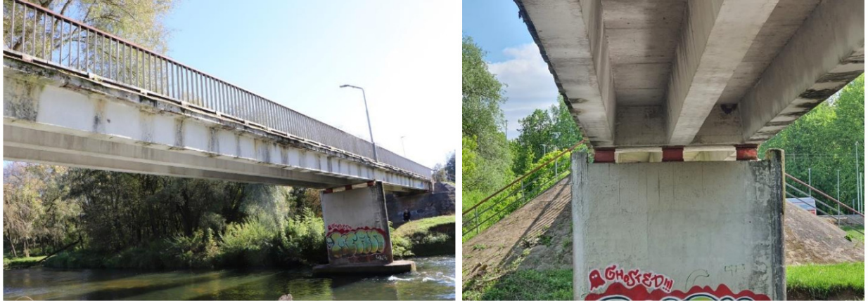
4 pav. Perdangos sijų bendri vaizdai
