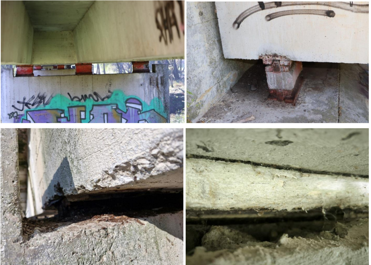
8 pav. Paslankių ir nepaslankių atraminių guolių išdėstymo schema (viršuje), paslankių atraminių guolių bendri vaizdai (viduryje), nepaslankių atraminių guolių bendri vaizdai (apačioje)
