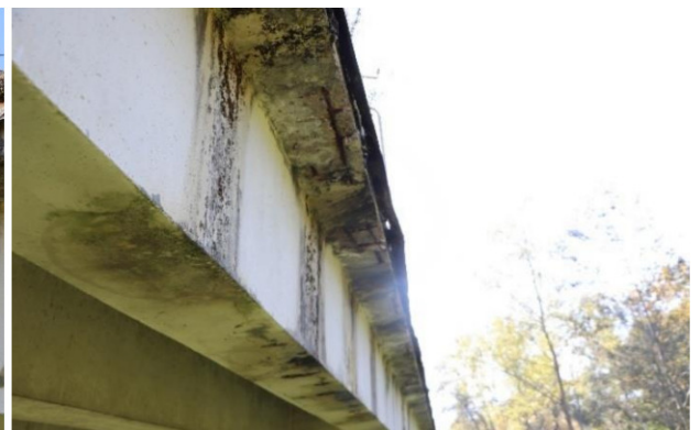
24 pav. Gelžbetoninių paklotą laikančių plokščių gembinių dalių defektai
