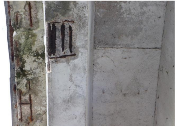
22 pav. Eksploatacijos metu labiausiai nusidėvėjusios tarpatramio 5 sijos S5-3 defektai
