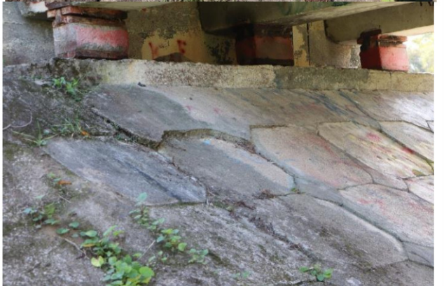
29 pav. Kūgių defektai: apaugę kūgių šlaitai, dėl nuolatinio drėkinimo apsamoję ir pajudavę kūgių šlaitus stiprinantys gelžbetoniniai elementai, kai kurie elementai deformuoti dėl išplauto pagrindo
