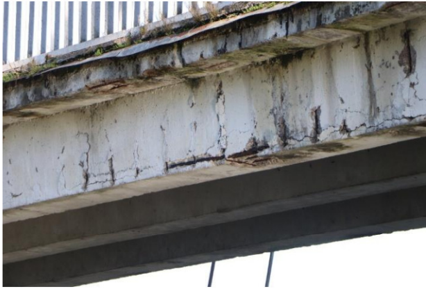
22 pav. Eksploatacijos metu labiausiai nusidėvėjusios tarpatramio 5 sijos S5-3 defektai
