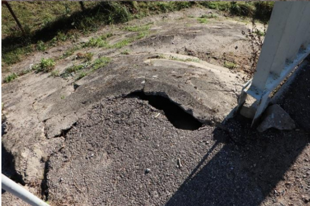
29 pav. Kūgių defektai: apaugę kūgių šlaitai, dėl nuolatinio drėkinimo apsamoję ir pajudavę kūgių šlaitus stiprinantys gelžbetoniniai elementai, kai kurie elementai deformuoti dėl išplauto pagrindo
