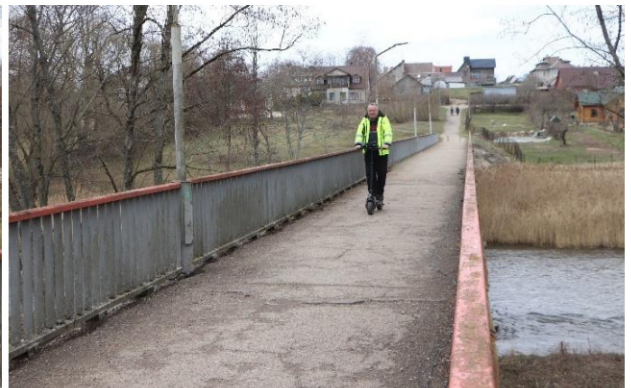
13 pav. Tilto perdangos žadinimas skirtingo pobūdžio ir intensyvumo išoriniais poveikiais
