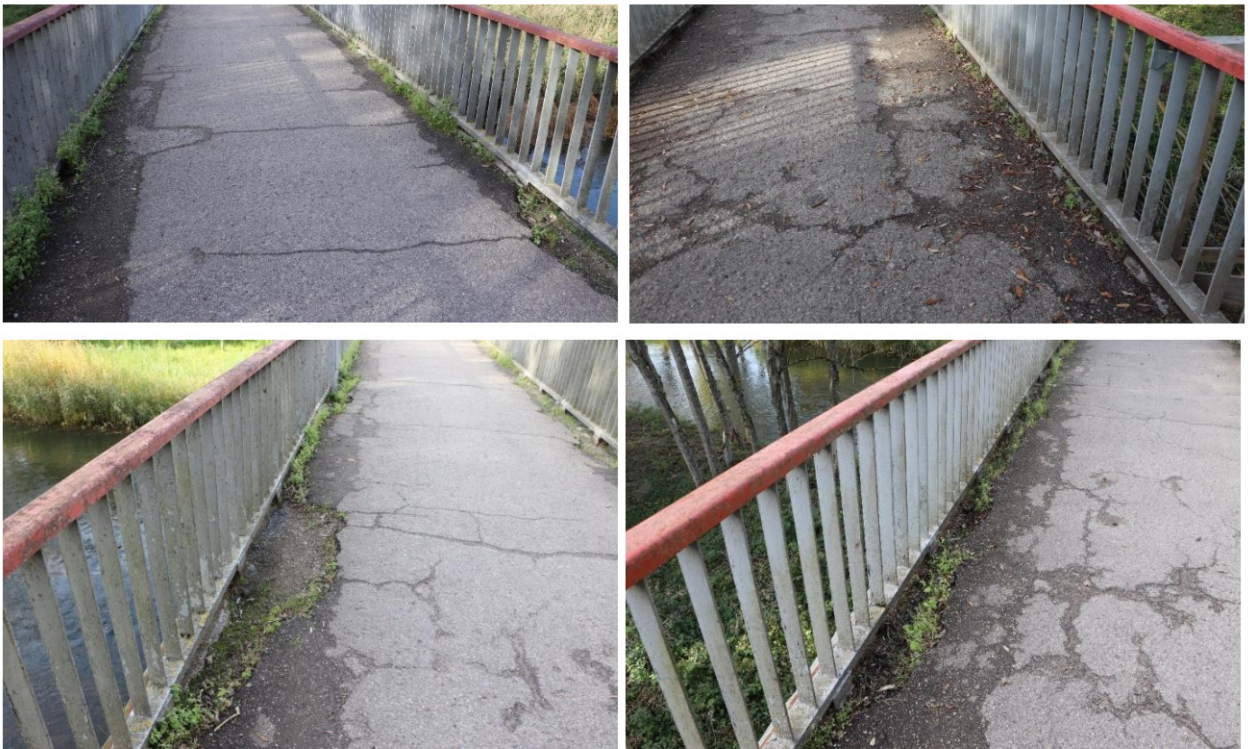
16 pav. Nelygi, duobėta, supleišėjusi ir žolėmis apaugsi tilto pakloto danga
