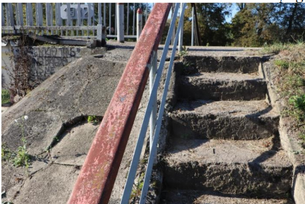
30 pav. Šlaitinių laiptų ir turėklų defektai: sudūlėję, apsamoję ir apaugę betoniniai paviršiai, apsamoję plieniniai turėklai, prasidėjusi jų korozija lokaliuose zonose
