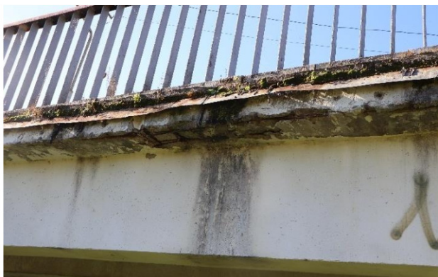
24 pav. Gelžbetoninių paklotą laikančių plokščių gembinių dalių defektai
