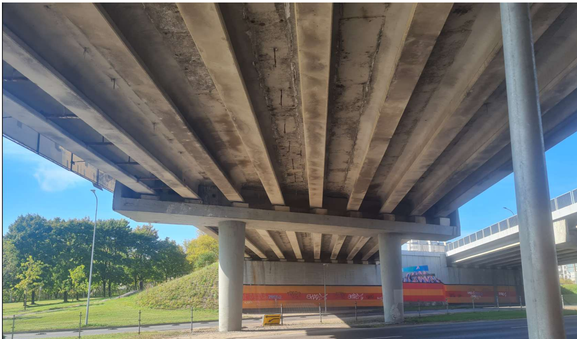
2.3 pav. Ozo g. viaduko pietinės pusės perdangos ir atramų būklė
