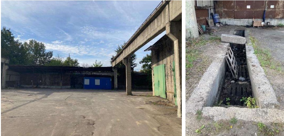
4 pav. Stoginė, automobilių remonto duobė ir tiltinio kranų estakada
