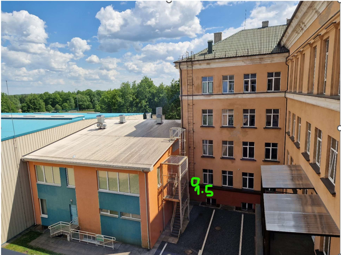
3 pav. Remontuojamo pastato fasado vaizdas.
