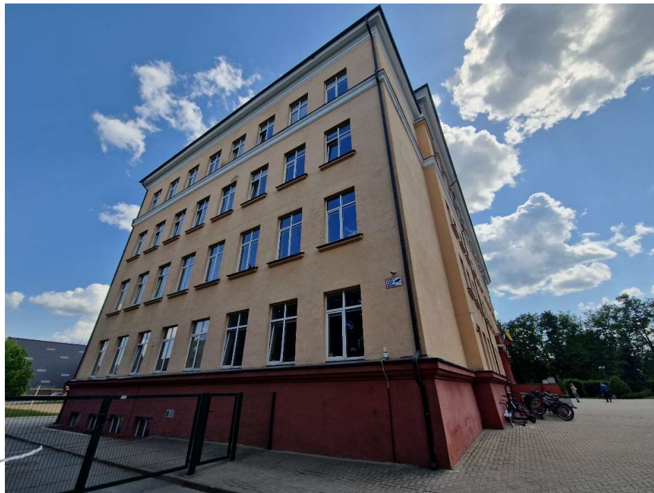
2 pav. Remontuojamo pastato fasado vaizdas.
