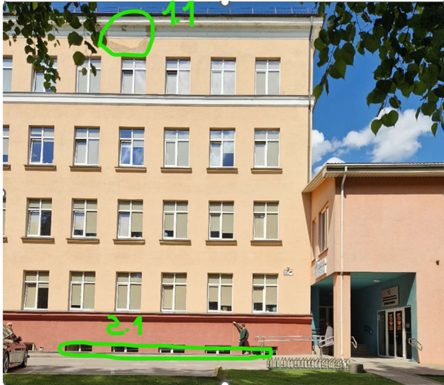
1 pav. Remontuojamo pastato fasado vaizdas.
