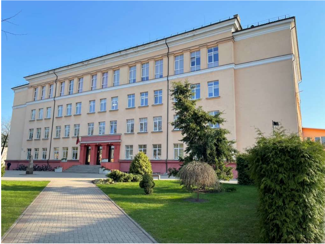
5 pav. Remontuojamo pastato fasado vaizdas.
