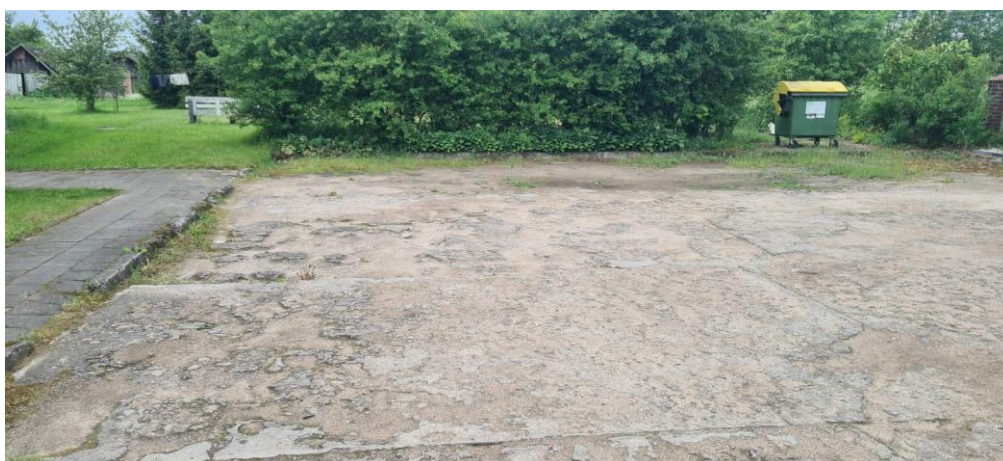
2 pav. Remontuojama teritorija
