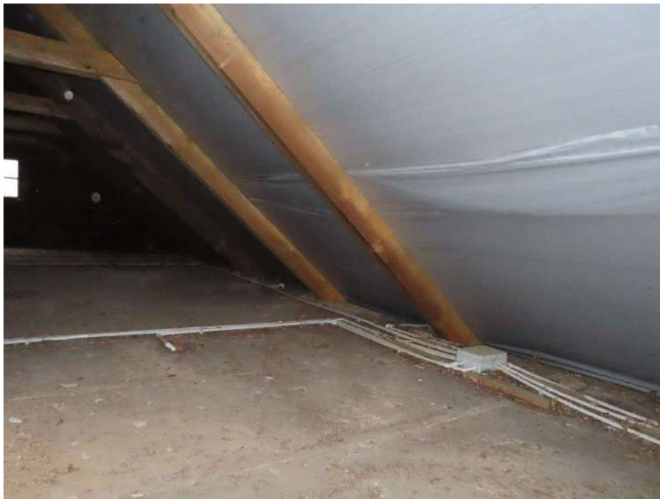
22. Ant perdangos įrengtas t=35 mm storio molio užpiltas tarp medinių 80(h)x45 mm sijų.
