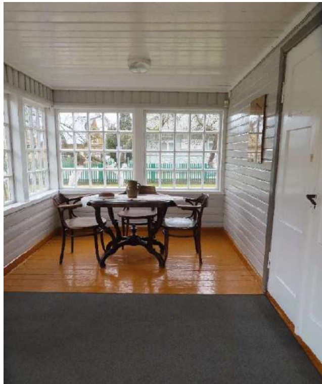
8. Verandos patalpoje grindys išklotos t=32\text{mm} storio medinėmis lentomis, sienos ir lubos iškaltos medinėmis dailylentėmis
