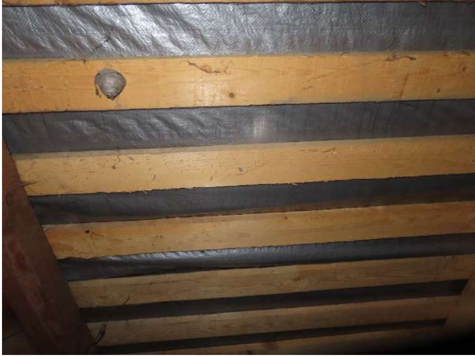
13. Stogo remonto metu įrengta armuota antikondensatinė plėvelė ir mediniai paklotai. Skiedrų danga visiškai susidėvėjusi, pažeista puvinio, nesandari ir laidi krituliams.
