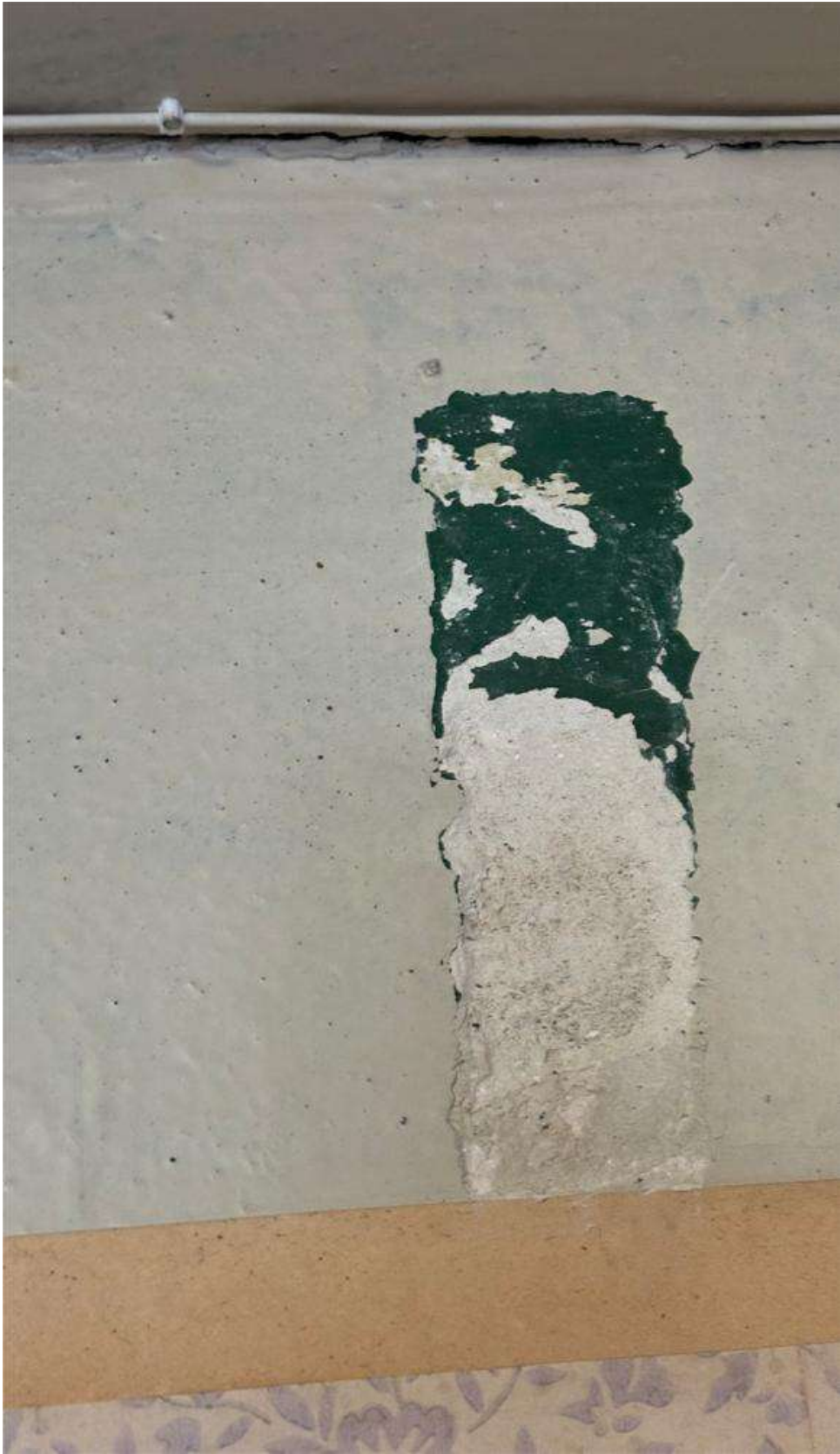
7 fot. Patalpa Nr. 1. Atodanga sienos viršutinėje dalyje prie lubų
