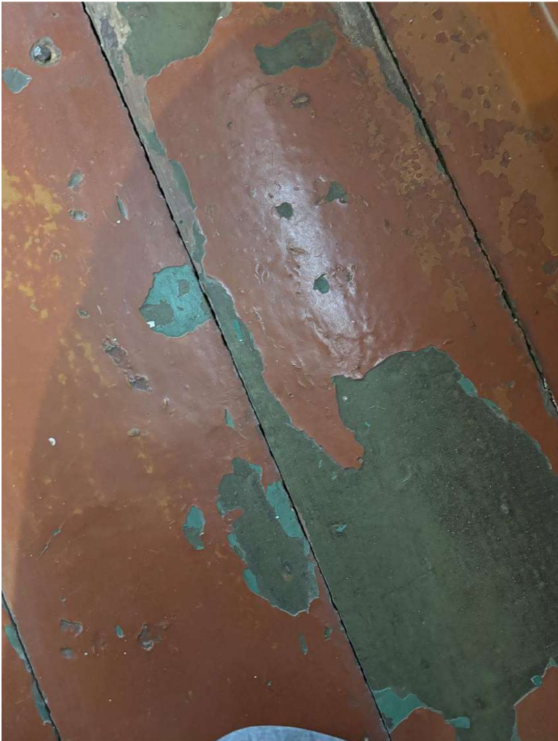
17 fot. Patalpa Nr. 4. Atodangos ant grindų (Ankstyviausio sluoksnio grindų spalvos pavyzdys apačioje)
