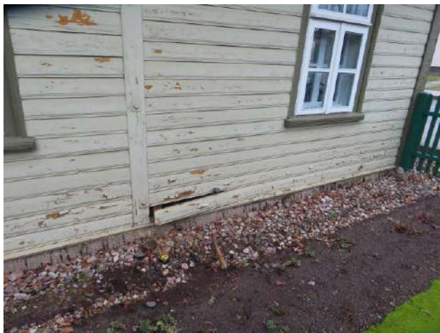
Mikalojaus konstantino čiurlionio sodybos namo sienų pakalimo ir nuogrindos vaizdas
