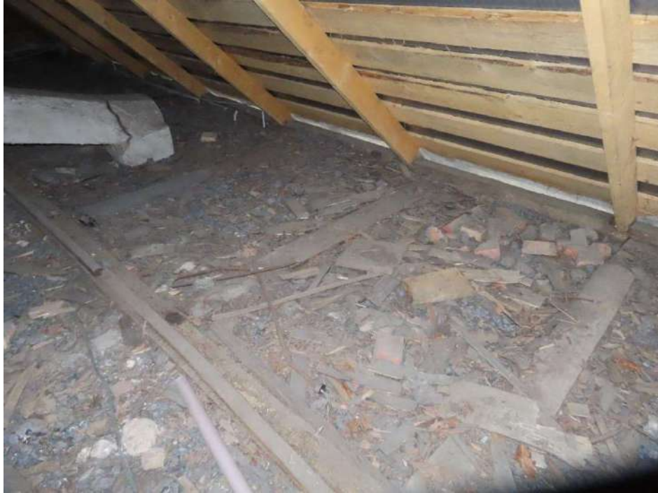
9. Aukšto perdanga medinių perdangos sijų 170x170 mm išdėstyty ~1,10 m žingsniu. Tarp sijų įrengtas šlako užpildas.
