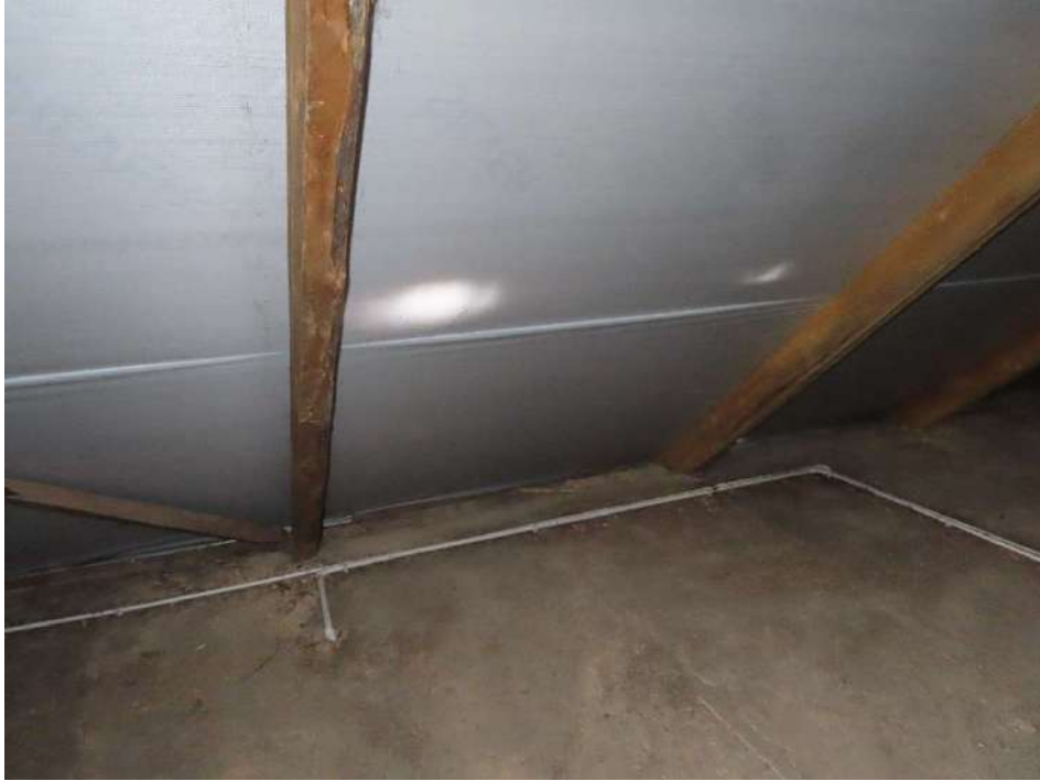
23. Stogo remonto metu įrengta armuota antikondensatinė plėvelė. Skiedrų danga visiškai susidėvėjusi, pažeista puvinio, nesandari ir laidi krituliams.
