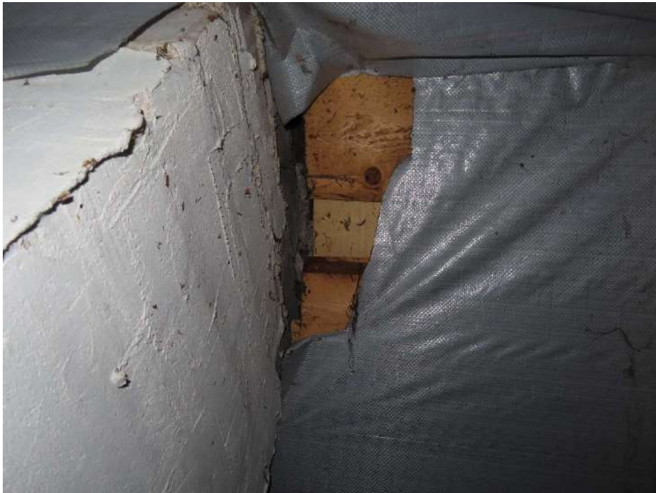
24. Stogo remonto metu įrengta armuota antikondensatinė plėvelė ir mediniai paklotai.
