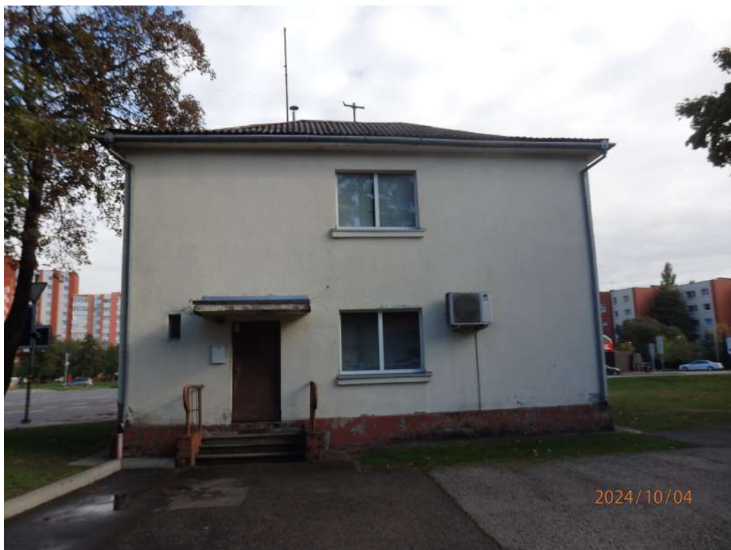
8 pav. Pastato vakarinis fasadas
