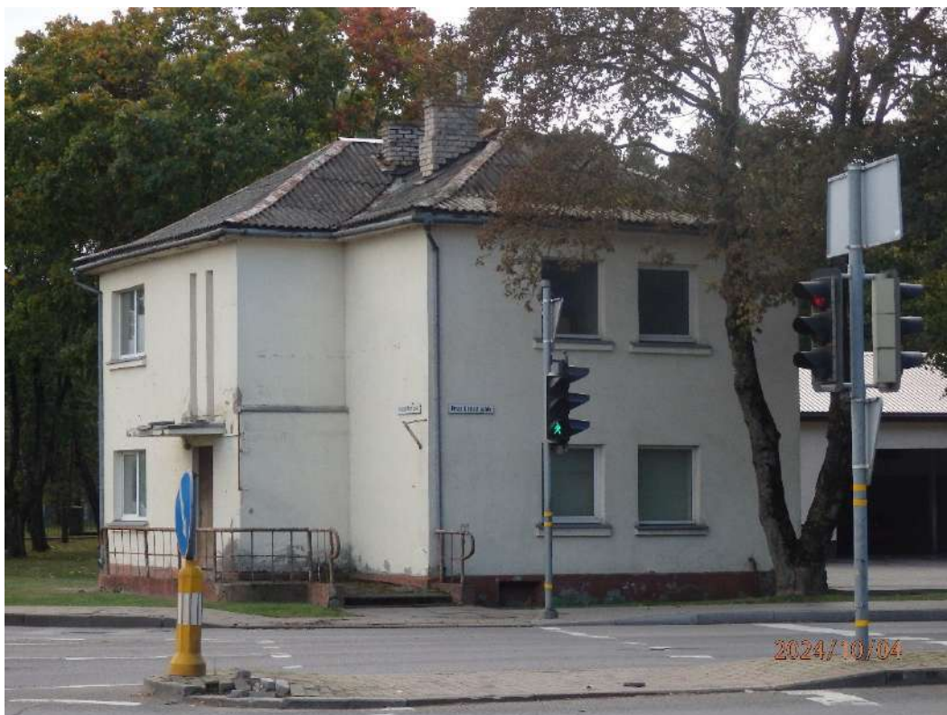
1 pav. Pastato šiaurinis ir rytinis fasadai
