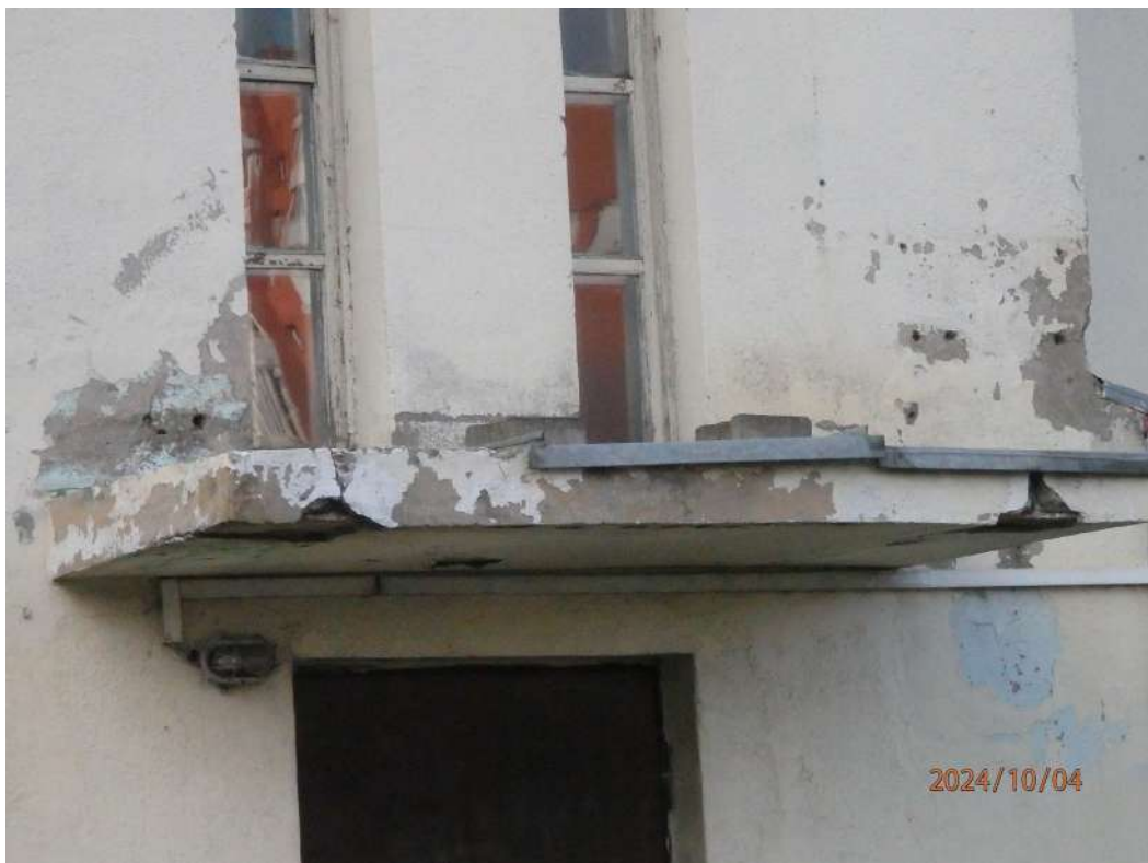
7 pav. Pastato rytiniame fasade esantis stogelis
