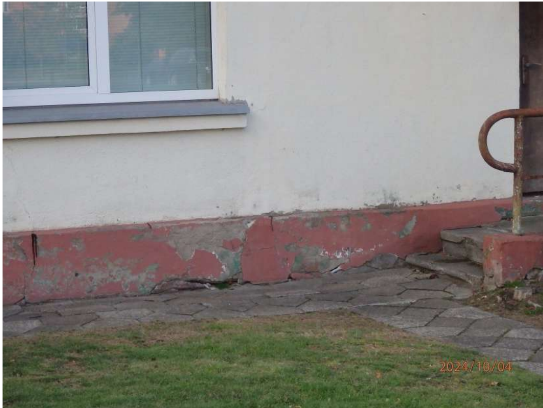
6 pav. Pastato rytinės pusės nuogrindos, cokolio ir laiptų fragmentai
