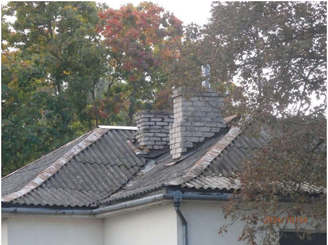
2 pav. Pastato stogo šiaurinio ir rytinio šlaitų fragmentai
