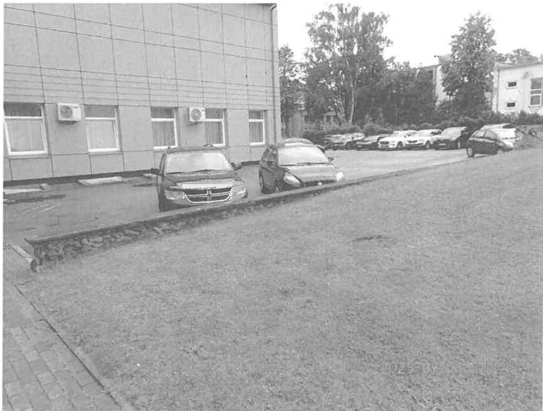
Nuotrauka Nr. 10. Sklypo paviršiaus nuolydis link pastato (ties laiptine B)
