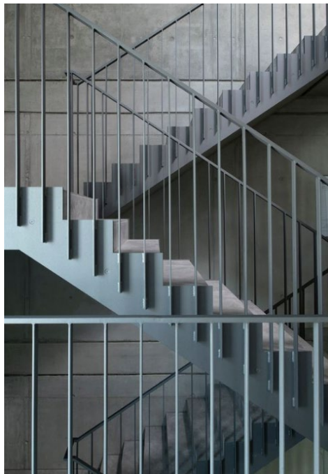
49 pav. Turėklų tvirtinimo iš laiptų šono pavyzdys
