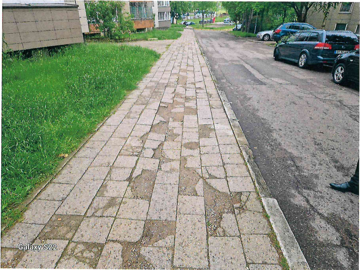
2 pav. Esama šaligatvių būklė
