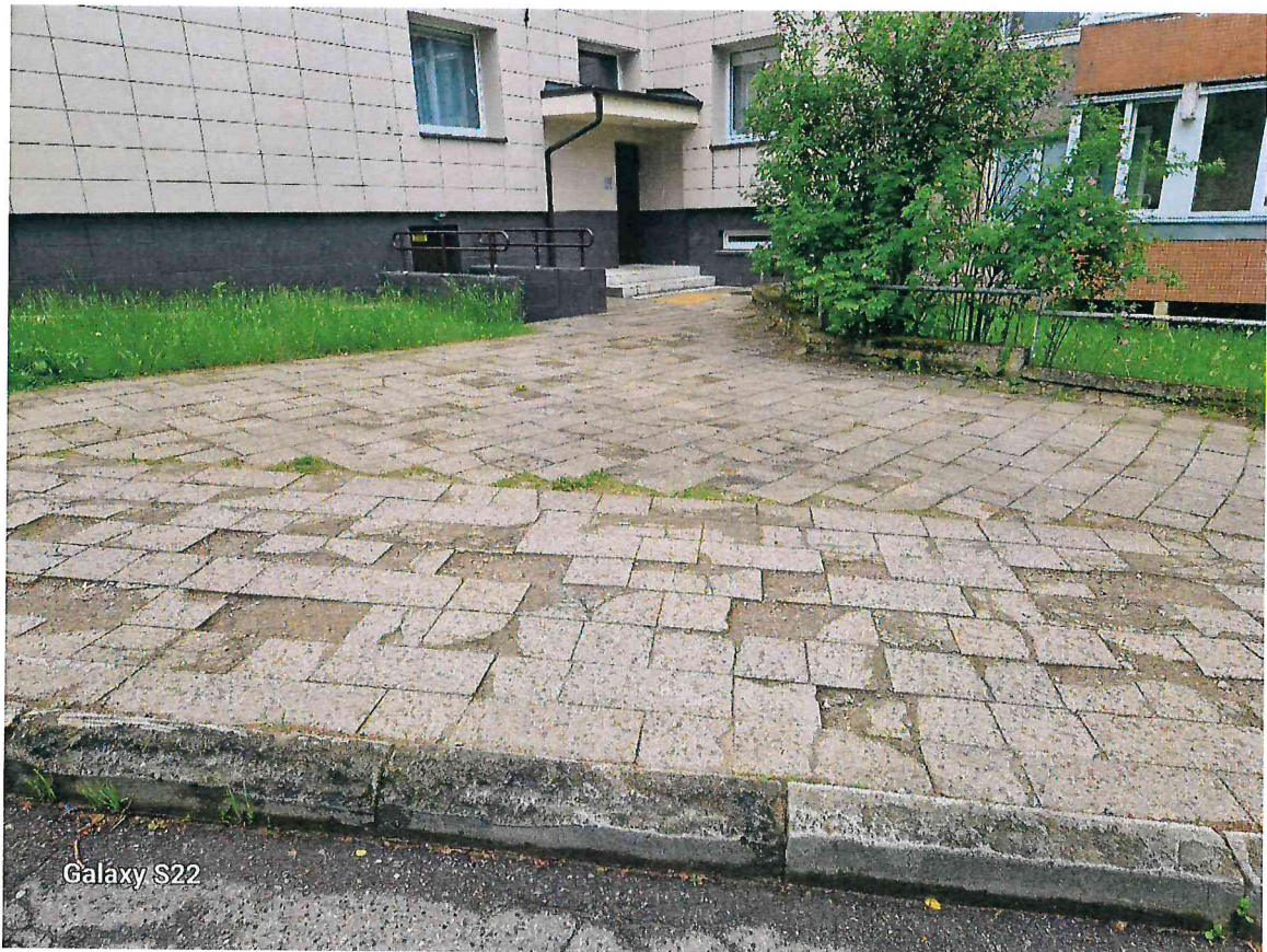
3 pav. Esama šaligatvių būklė
