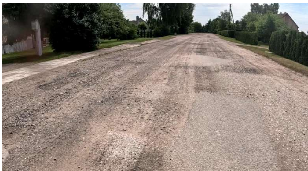
2.1 pav. Tiriamos Tvenkinio g. atkarpos nuo ruožo pradžios iki ~PK 3+80 surištos dangos būklė
