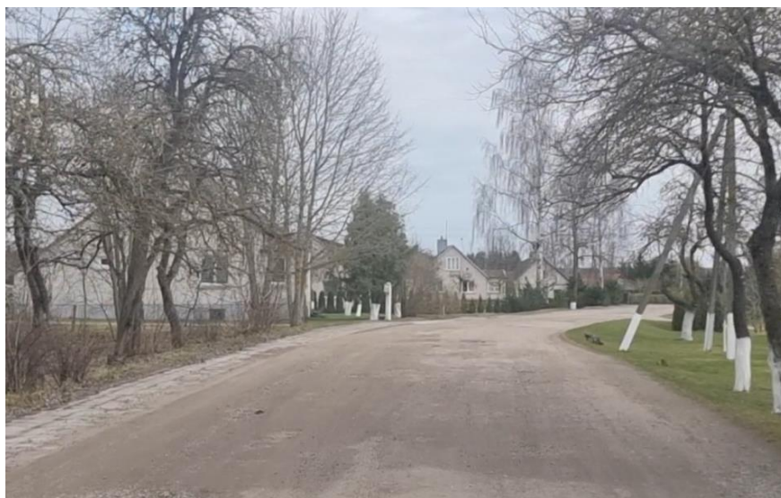
Pav. 3. Tvenkinio gatvės techninė būklė
