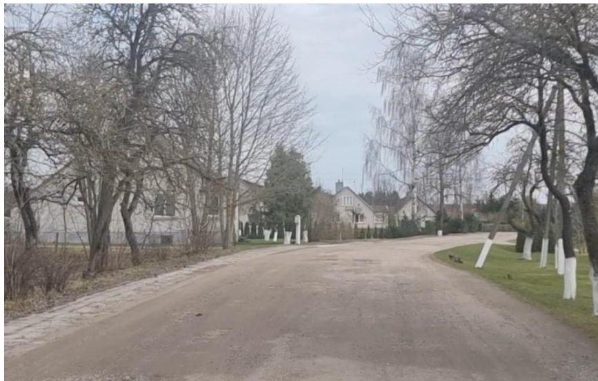
Pav. 3. Tvenkinio gatvės techninė būklė
