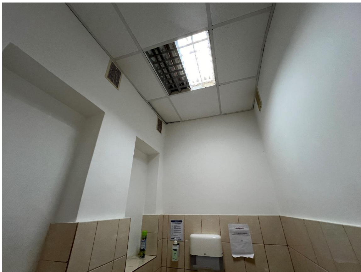
19 pav. Ventiliacinių angų fotografacija (tualetai)
