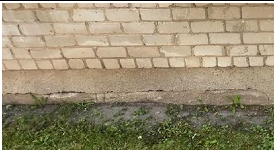
11 pav. Įtrūkimas ties pamatinių blokų sujungimu
