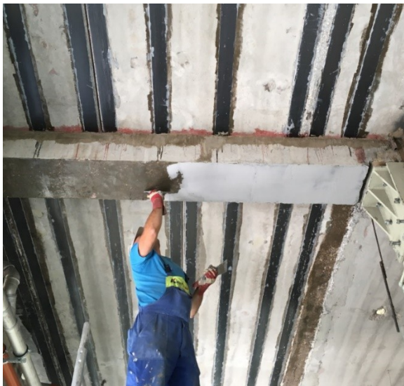
Pav. 3 ADESILEX PG1/PG2 klijų tepimas ant gruntuoto betono pagrindo
