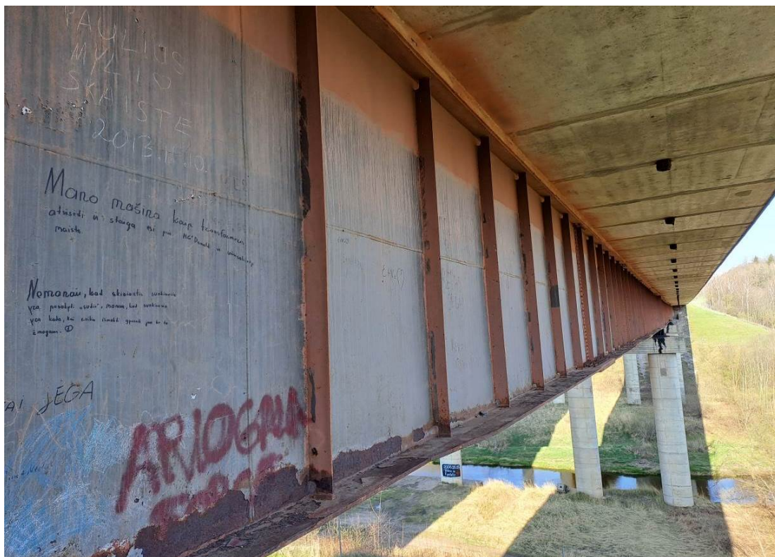
2.10 pav. Pirmas tarpatramis, dešinė pusė, koroduoja sijų apatinės lentynos
