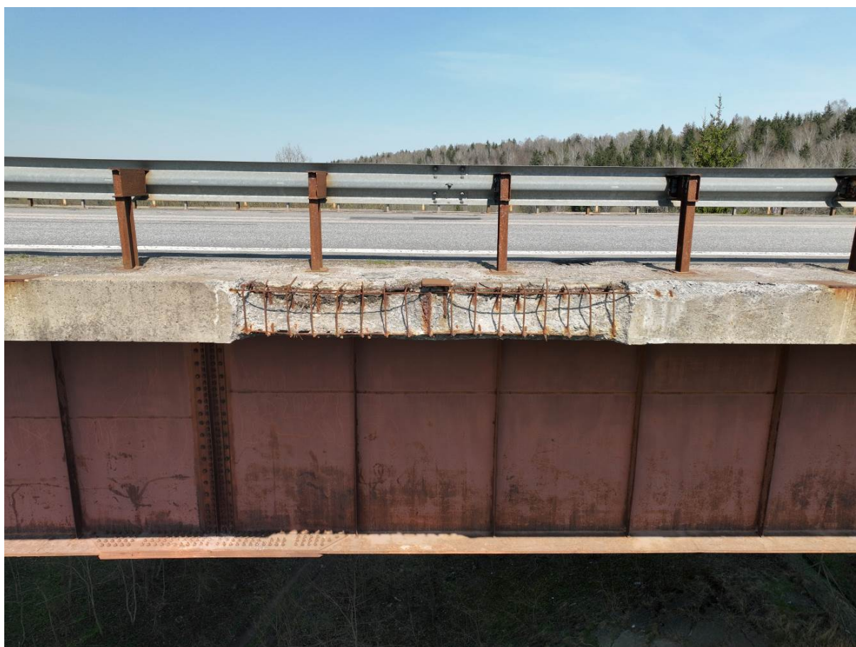
2.4 pav. Kairėje pusėje, pirmame tarpatramyje visiškai ištrupėjęs turėklinis blokas, likęs tik armatūros karkasas
