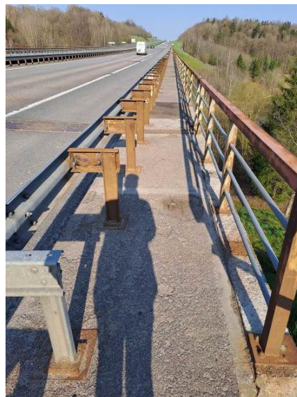
2.3 pav. Koroduoja turėklai
