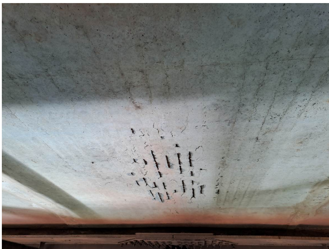
2.11 pav. Antras tarpatramis, per plonas apsauginis betono sluoksnis, armatūros strypai paviršiuje
