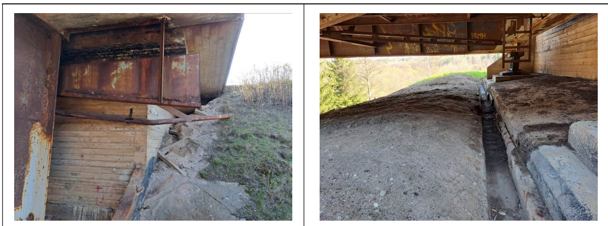
2.15 pav. Pirmą atramą, nežymus betono ištrupėjimai
