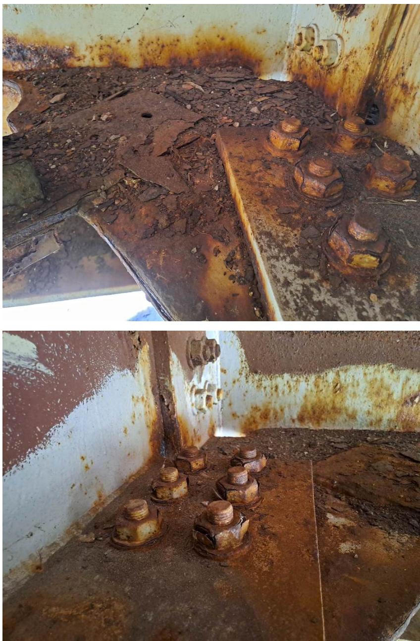
2.14 pav. Ketvirta atrama, labai korozijos pažeistos varžtų veržlės
