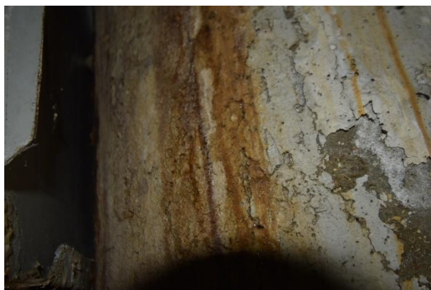
2.9 pav. Korpusas A. Apibėgusios ir betono korozijos pažeistos kolonos
