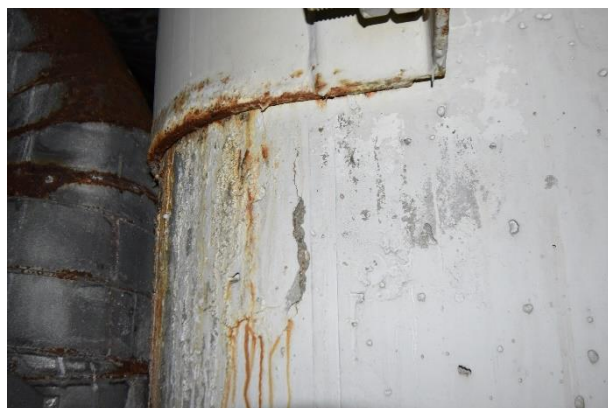
2.8 pav. Korpusas A. Plyšiai ties apibetonavimo juosta
