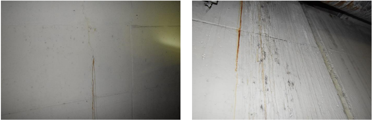
2.23 pav. Korpusas B. Pratekėjimai ir plyšiai sienose
