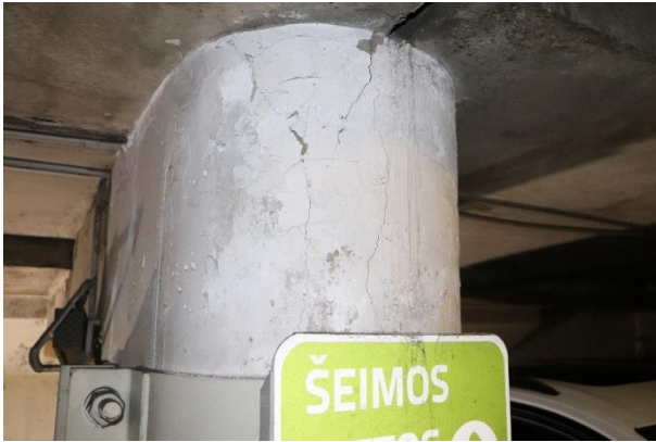
2.28 pav. Korpusas B. Supleišėjęs kolonų viršus
