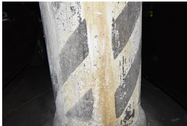
2.11 pav. Korpusas A. Išilginiai plušiai kolonose
