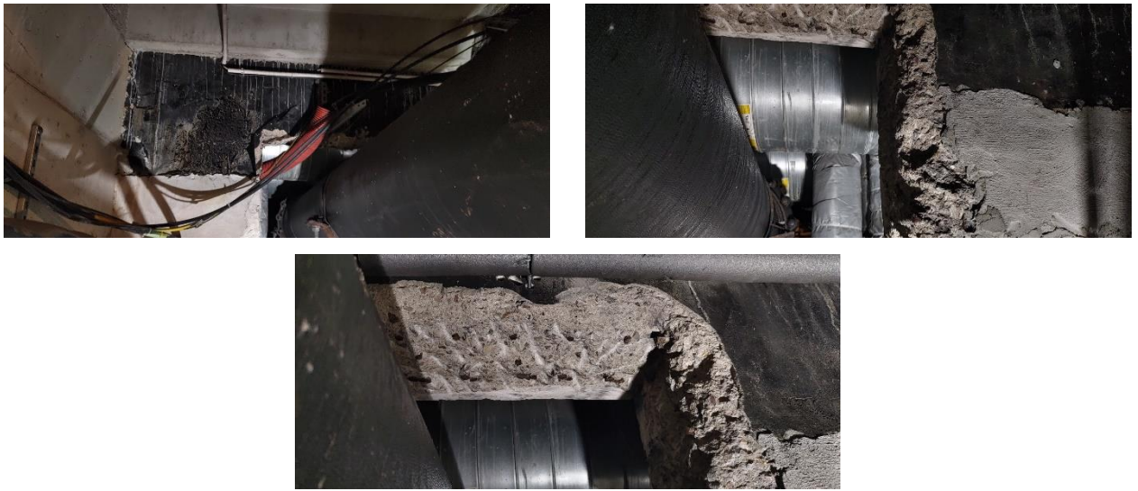
2.52 pav. Išpjautos sijos
