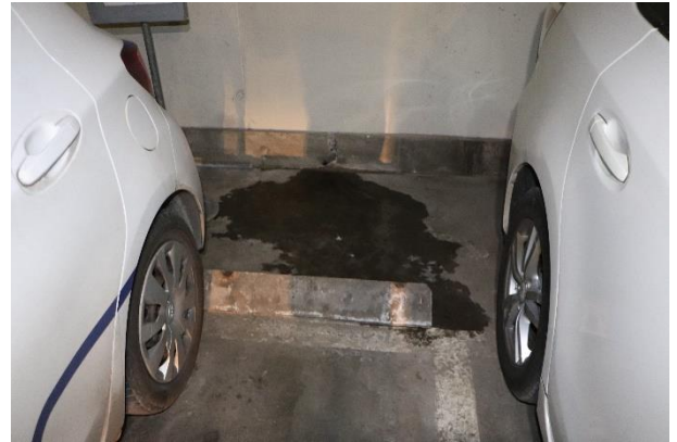
2.4 pav. Korpusas A. Technologinis plyšys, porėtas betono paviršius
