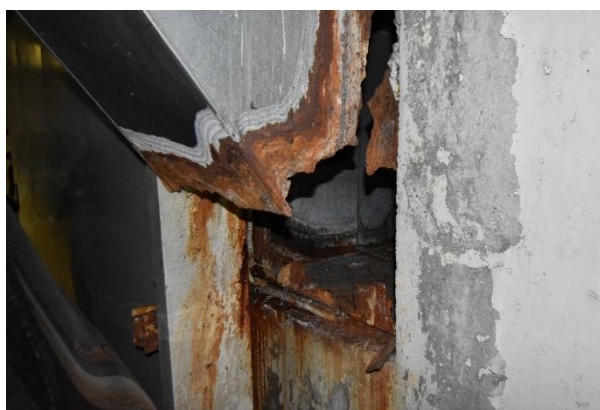
2.26 pav. Korpusas B. Netvarkinga ventiliacija
