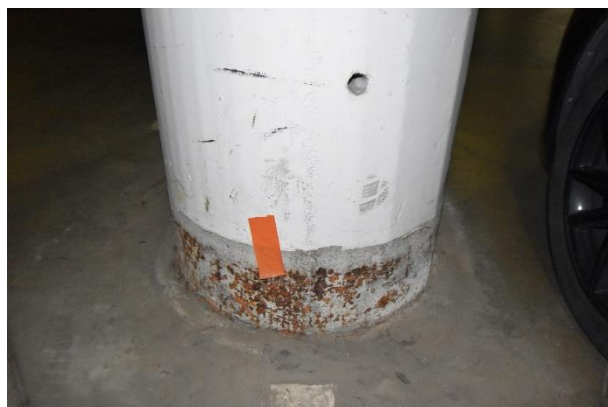
2.7 pav. Korpusas A. Apsauginių juostų betonas koroduoja ir yra supleišėjęs, atskirose kolonose betoninės juostos yra nukritusios
