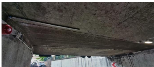
2.43 pav. Peršalimo pasekmė – pelėsis ant perdangos paviršiaus
