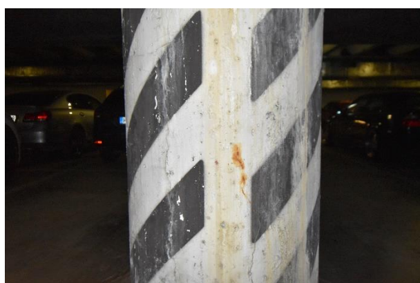
2.10 pav. Korpusas A. Koroduoja atraminės plieninės plokštelės, pasireiškusi armatūros korozija
