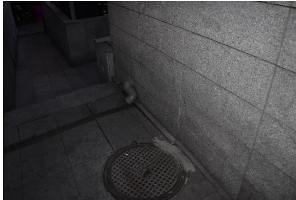
2.46 pav. Ž. Liauksmino gatvės laiptinė
