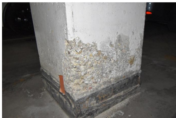
2.9 pav. Korpusas A. Apibėgusios ir betono korozijos pažeistos kolonos
