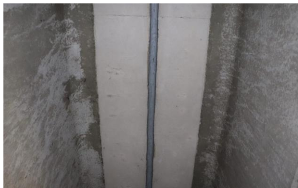
2.32 pav. Korpusas B. Vandens pratekėjimai ir trūkusi deformacinė siūlė tarp ašių C-D/20-21
