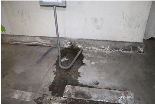
2.4 pav. Korpusas A. Technologinis plyšys, porėtas betono paviršius
