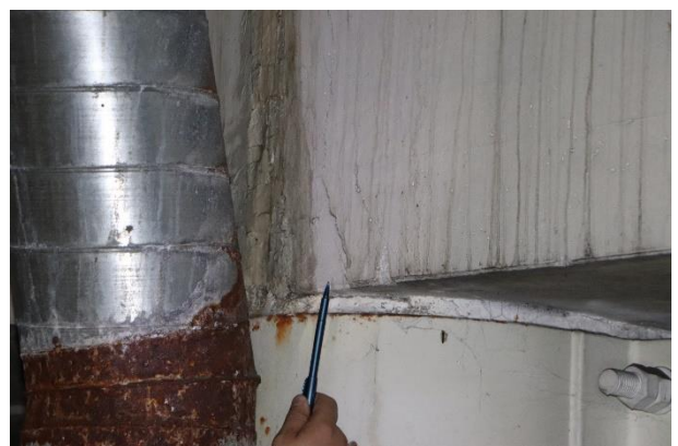
2.20 pav. Korpusas A. Plyšiai rygelių atramose
