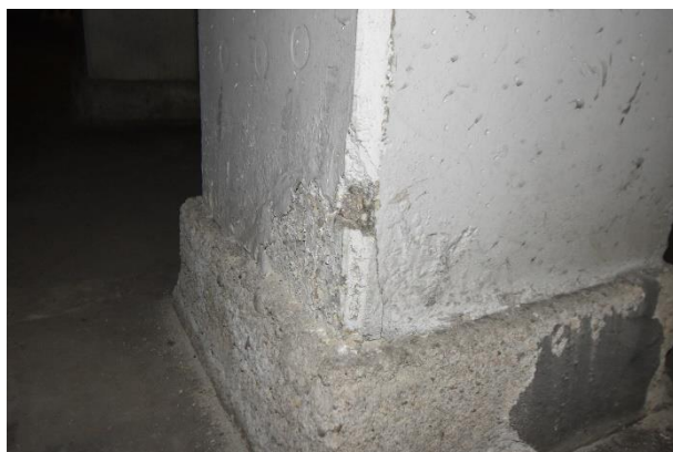
2.8 pav. Korpusas A. Plyšiai ties apibetonavimo juosta
