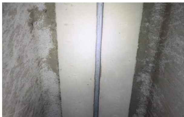
2.32 pav. Korpusas B. Vandens pratekėjimai ir trūkusi deformacinė siūlė tarp ašių C-D/20-21
