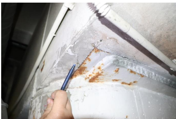
2.20 pav. Korpusas A. Plyšiai rygelių atramose
