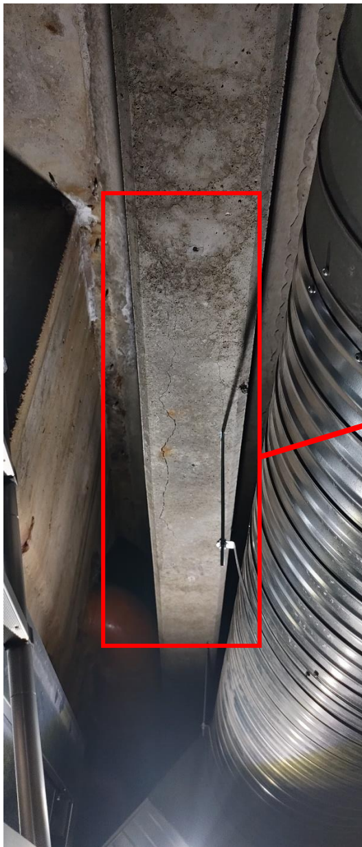
2.35 pav. Korpusas B. Technologinis plyšys tarp ašių C-D/22-23 (a) ir išilginus plyšys sijoje 12/D-E (b)
