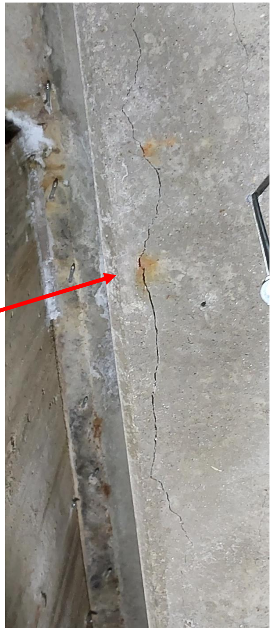
2.35 pav. Korpusas B. Technologinis plyšys tarp ašių C-D/22-23 (a) ir išilginus plyšys sijoje 12/D-E (b)
