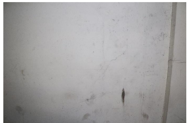
2.5 pav. Korpusas A. Sausos pratekėjimų žymės, technologinis plyšys
