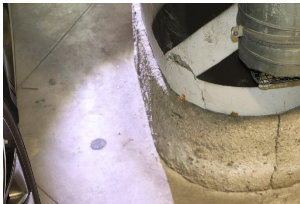
2.27 pav. Korpusas B. Koroduoja ir aižėja apsauginių juostų betonas
