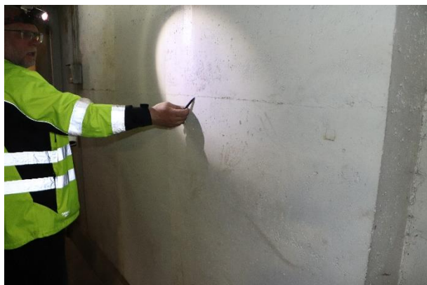
2.1 pav. Korpusas A. Pratekėjimai, technologinis plyšys, atšokusi betoninė grindų apsauga
