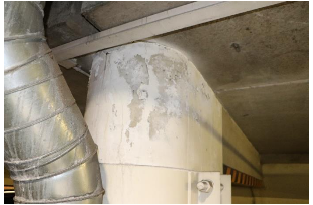
2.28 pav. Korpusas B. Supleišėjęs kolonų viršus
