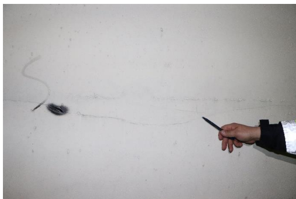
2.3 pav. Korpusas A. Technologinis plyšys, porėtas betono paviršius
