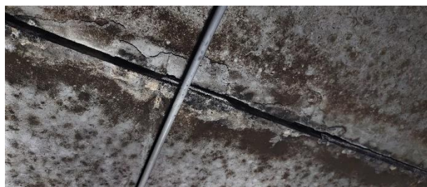
2.43 pav. Peršalimo pasekmė – pelėsis ant perdangos paviršiaus
