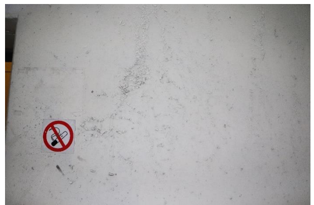
2.3 pav. Korpusas A. Technologinis plyšys, porėtas betono paviršius
