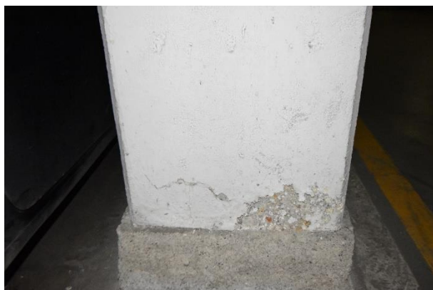
2.7 pav. Korpusas A. Apsauginių juostų betonas koroduoja ir yra supleišėjęs, atskirose kolonose betoninės juostos yra nukritusios
