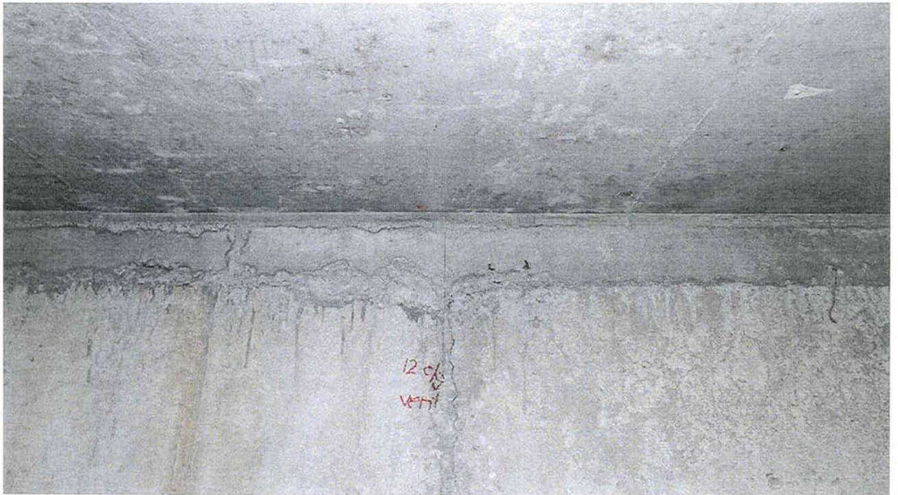
3P.28 pav. Plyšiai sienose C korpusas
