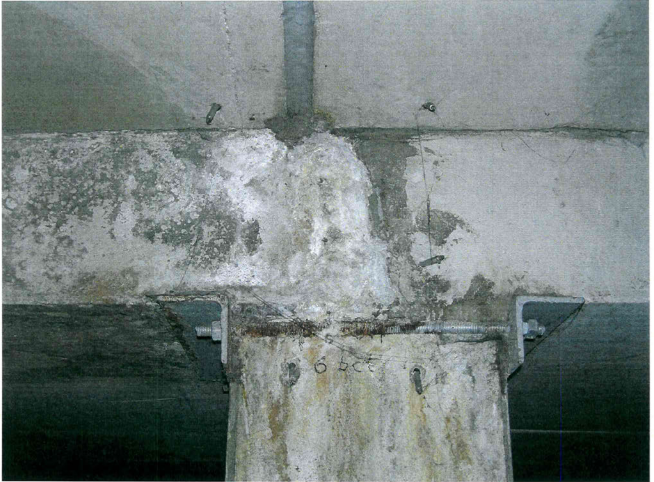
1P.20 pav. A korpuso tarpinė kvadratinio skerspjūvio kolona tarp ašių B ir C 6 ašyje (6BC), sustiprinta plienine apkaba. Deformacinis tarpas užsandarintas cementiniu skiediniu
