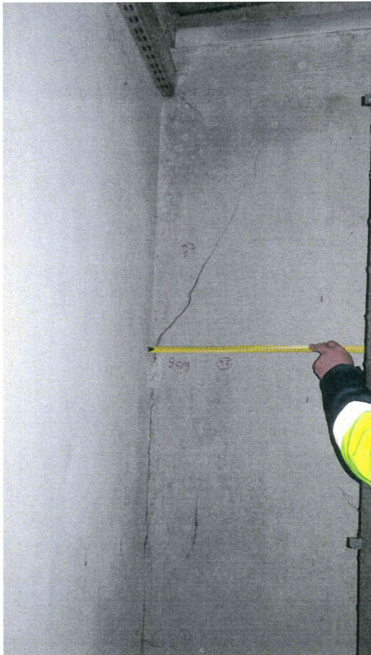
3P.26 pav. Netinkama mūro perrīša
