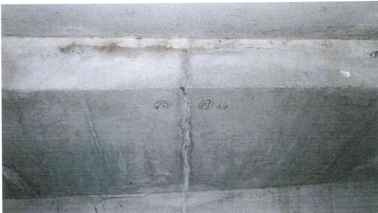
3P.16 pav. Plyšiai sienose B korpusas
