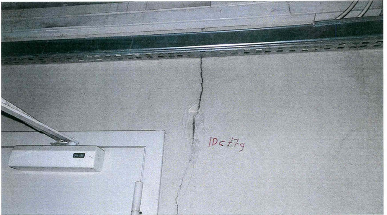
3P.27 pav. Netinkamas sąramos įrengimas
