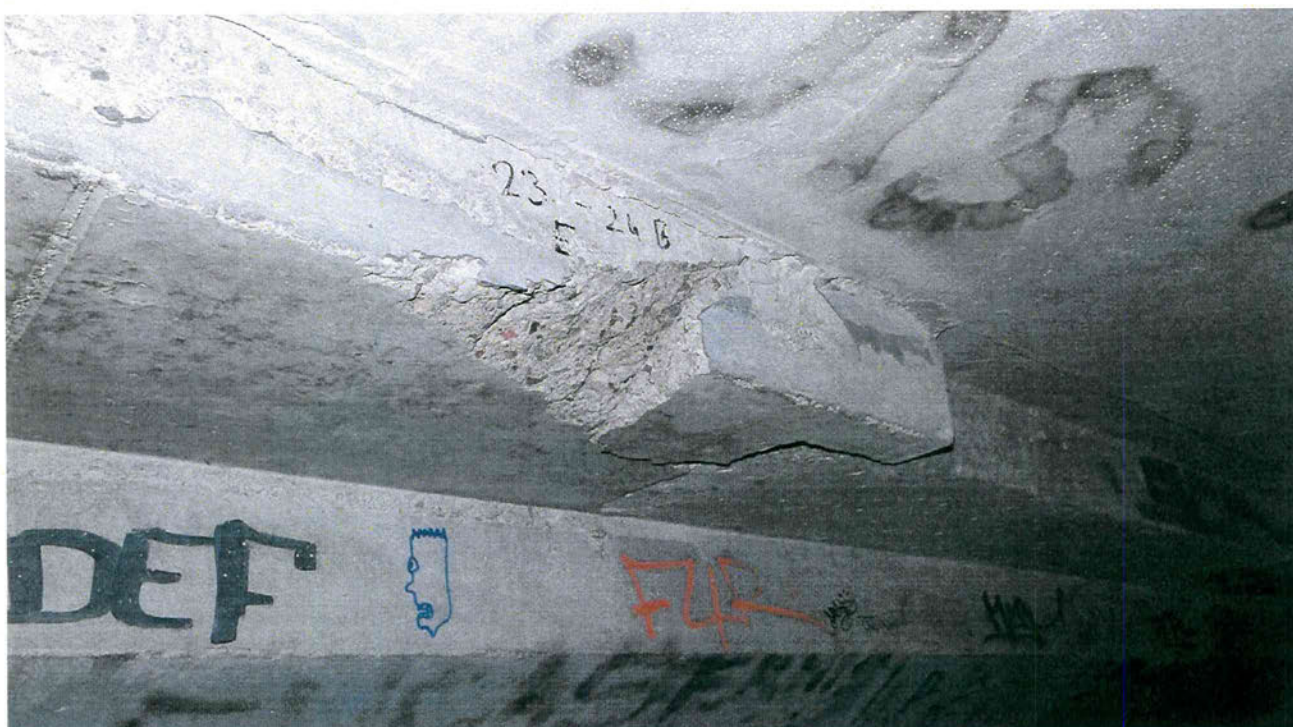
3P.16 pav. Plyšiai sienose B korpusas
