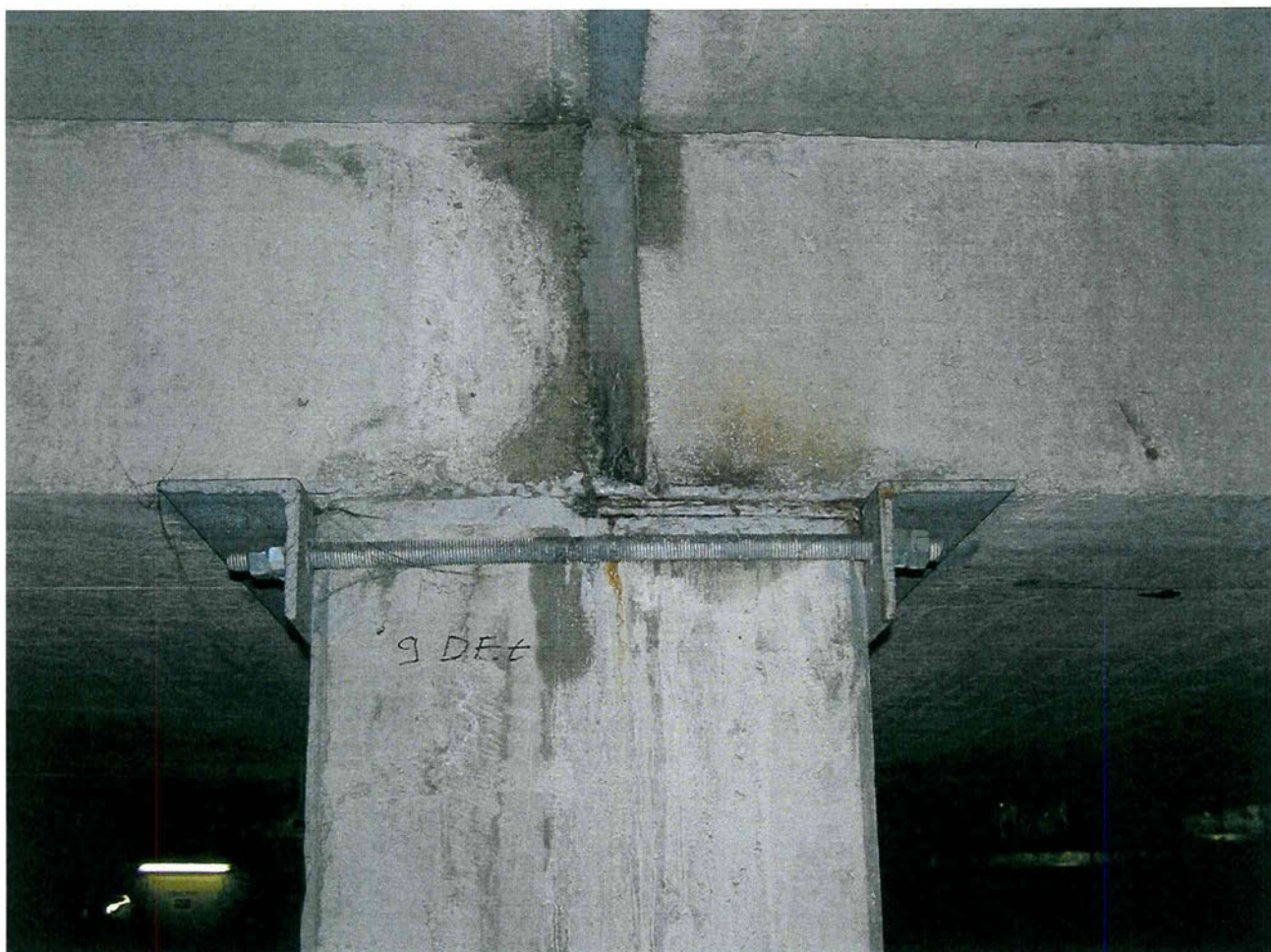
1P.22 pav. A korpuso tarpinė kvadratinio skerspjūvio kolona tarp ašių D ir E 9 ašyje (9DE), sustiprinta plienine apkaba.
