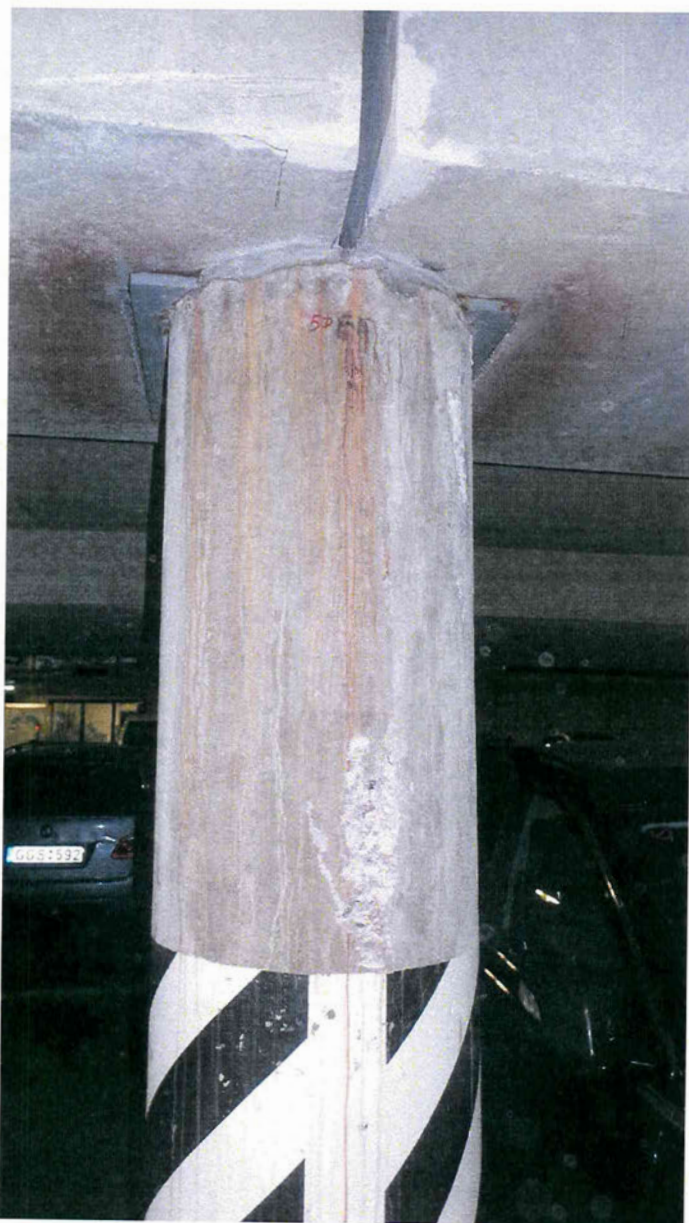
1P.5 pav. A korpuso D5 ašies kolonos viršutinės dalies vaizdas su vertikaliu plyšiu, aiškiais buvusių atmosferinių kritulių prabėgimų požymiais
