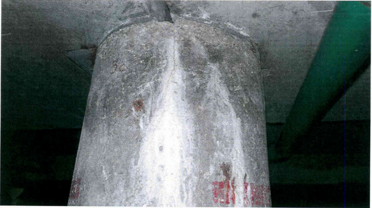
1P.1 pav. A korpuso C3 ašies kolonos viršutinės dalies vaizdas su vertikaliu plyšiu
