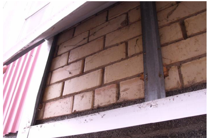
18 pav. Atidengta metalinė fasado kasetė. Matomas mūras iš keraminių plytų.
