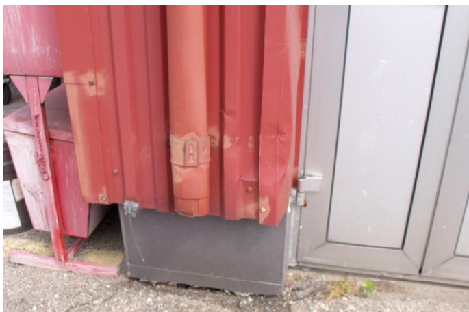
31. Pastato fasado profiliuotas lakštas mechaniškai pažeistas. Surinktas vanduo nuo stogo nuvedamas ties pamatais.
