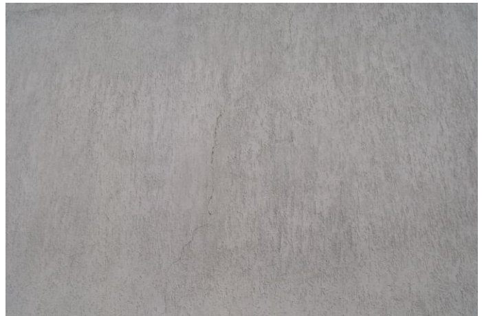
28. Pastato pietų pusėje užfiksuotas įtrūkimas fasado tinke.
