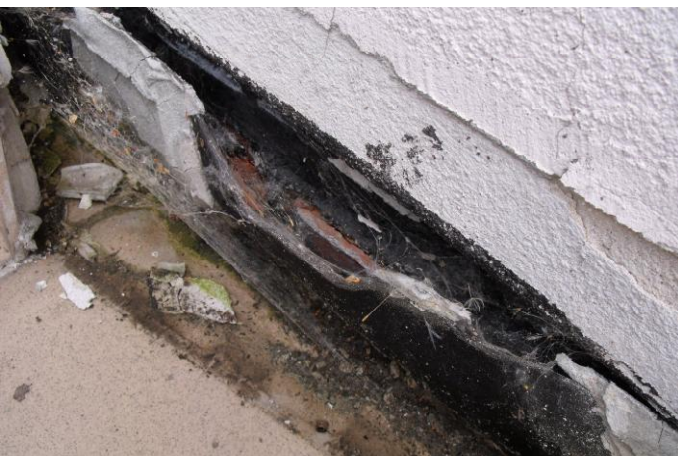
53. Balkono grindjuostė iš plytelių nukritusi.
