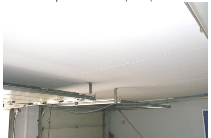
54. Matomos perdangos plokštės perdengiančios garažo patalpą.
