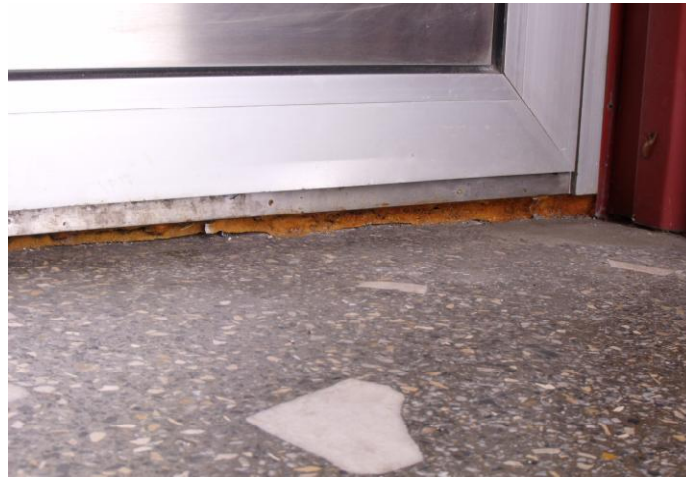
23 pav. Montažinės putos ties durų anga apačia praradusios savo savybes – lengvai subyra į dulkes.
