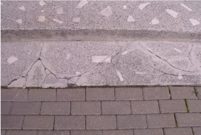
19. Rytinėje pusėje esančiuose laiptuose atsiradę plyšiai.
