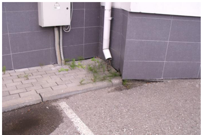
42. Vanduo nuo stogo nuvedamas ties pamatais ir šalia elektros įvado. Nuogrinda nusėdusi.
