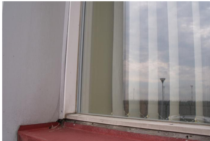
28 pav. Langų angokraščiai mediniai, nesandarūs, blogai izoliuojantys šilumą.
