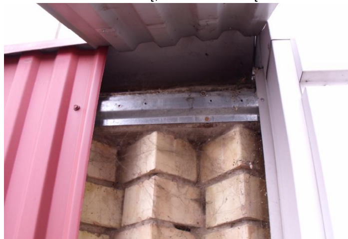
22. Atidengtas fasado profiliuotas skardos lakštas. Matomas mūras iš keraminių plytų.
