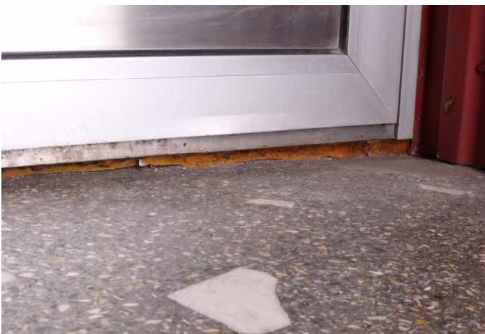
17. Montажinės putos ties durų angos apačia praradusios savo savybes – lengvai subyra į dulkes.
