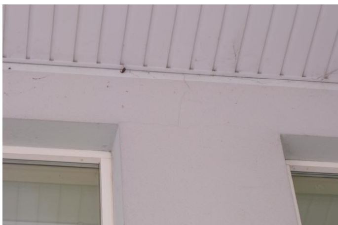
33. Vakarinėje pastato dalyje užfiksuoti mikro įtrūkimai sienoje ties langų angomis.
