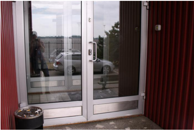
22 pav. Prastai šilumą izoliuojančios aliuminio rėmo durys.
