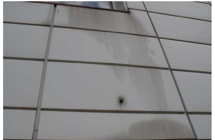
52. Fasadinės metalinės plokštės pajuodavusios, praradusios estetinį vaizdą.
