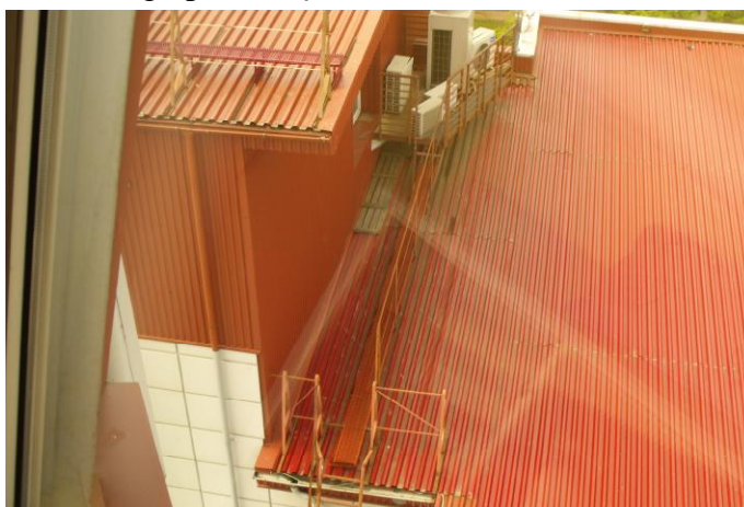
30 pav. Nėra įrengta lipynė patekimui ant stogo.
