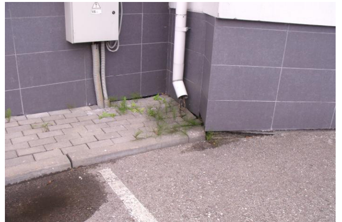
6 pav. Vanduo nuo stogo nuvedamas ties pamatais ir šalia elektros įvado. Nuogrinda nusėdusi.
