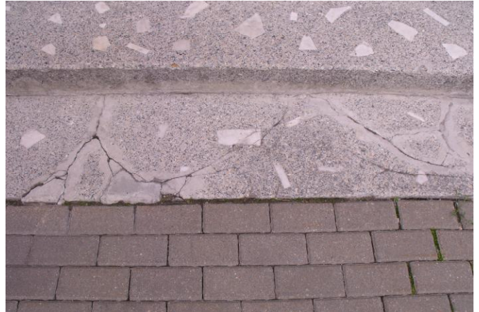
14 pav. Rytinėje pusėje esančiuose laiptuose atsiradę plyšiai.
