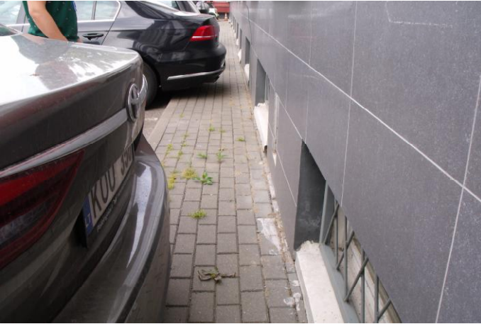
49. Nuogrinda nelygi, susidėvėjusi, per atsiradusius plyšius dangoje pradėjusi augti augmenija.
