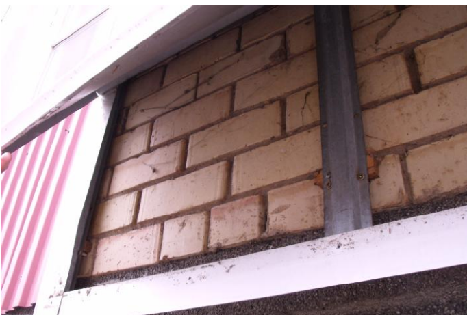
23. Atidengta metalinė fasado kasetė. Matomas mūras iš keraminių plytų.
