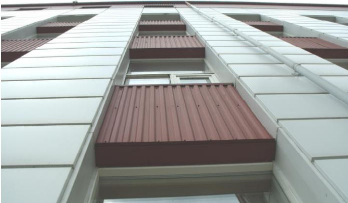
5. Pastato fasadas apdailintas profiliuotais skardos lakštais bei metalinėmis kasetėmis.
