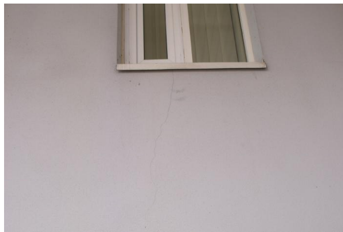
32. Vakarinėje pastato dalyje užfiksuoti mikro įtrūkimai sienoje ties langų angomis.
