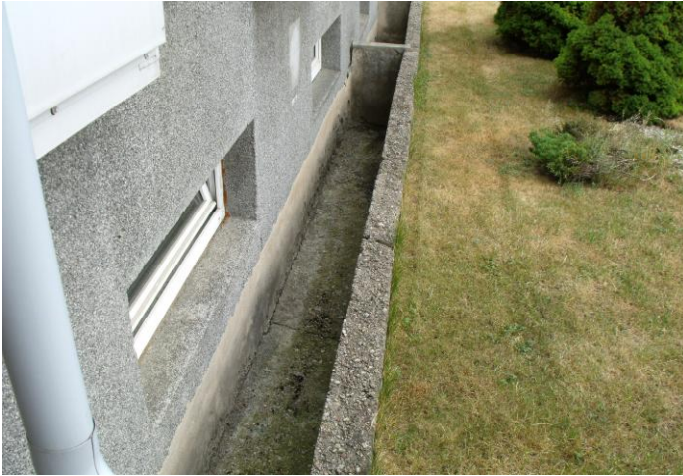
3 pav. Įrengtos šviesduobės rytinėje pastato dalyje.
