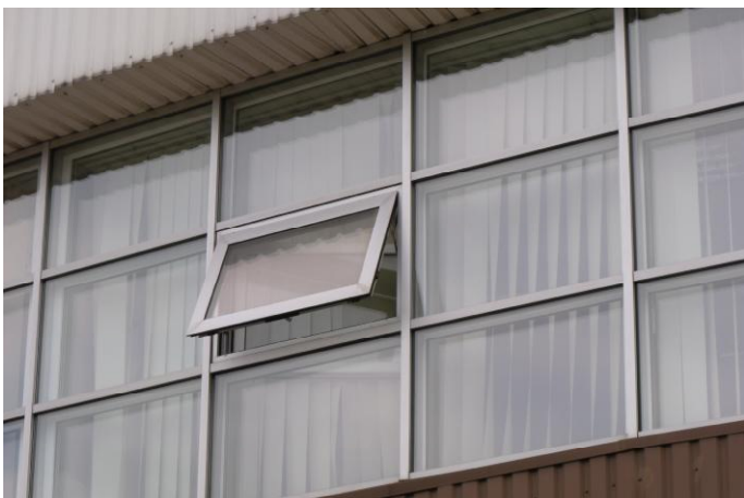
41. Dalis pastato aptaisyta stikliniu fasadu, kurio rėmas aliuminis.
