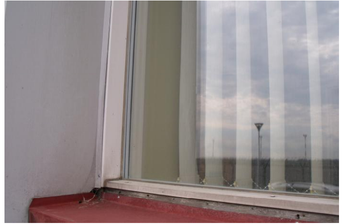
8. Langų angokraščiai mediniai, nesandarūs, blogai izoliuojantys šilumą.
