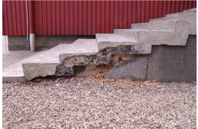
20. Rytinėje pastato pusėje esantys laiptai susidėvėję, tinkas atšokę, vietomis nukritęs.
