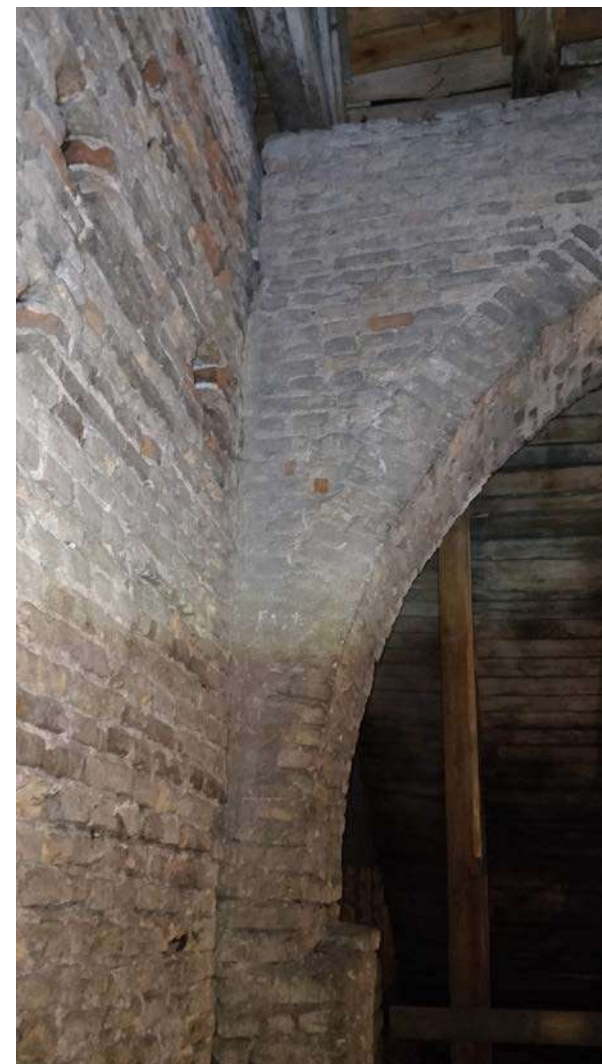
Nuotrauka Nr. 30. Sienų mūro ašių „E“ ir „1“ sankirtoje. Šioje vietoje gotikinis frontono mūras neturi sąryšio su barokine arkada matosi plyšys.
