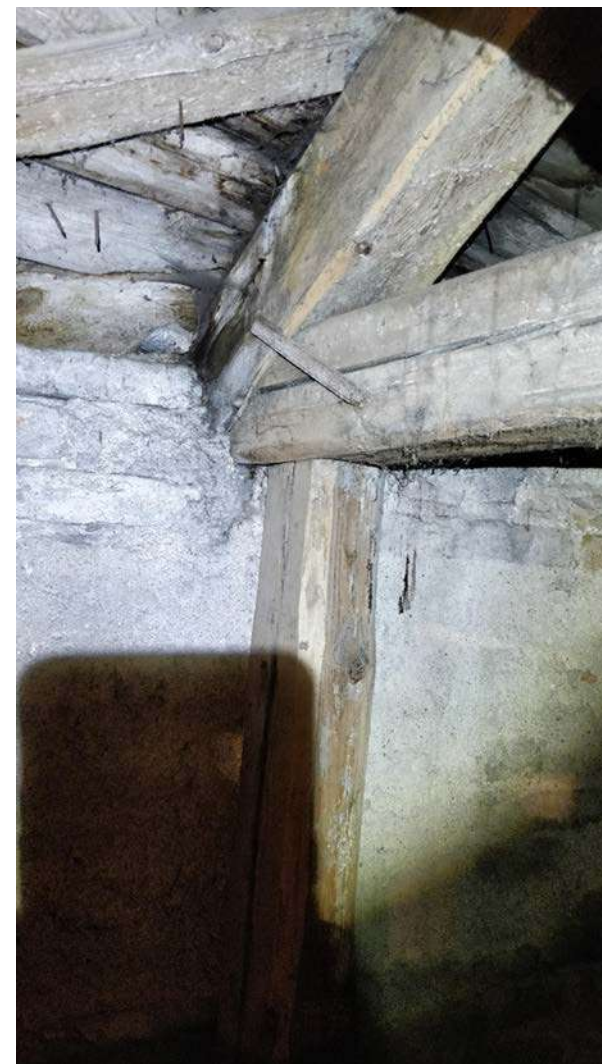
Nuotrauka Nr. 22. Apatinio stogo fragmentas dalyje tarp ašyje „9“, ties mūrų matosi drėgmės pažeistos vietos, mediena veikiama drėgmės, turi puvinio požymių. Atrama stiprinta statramsčiu.
