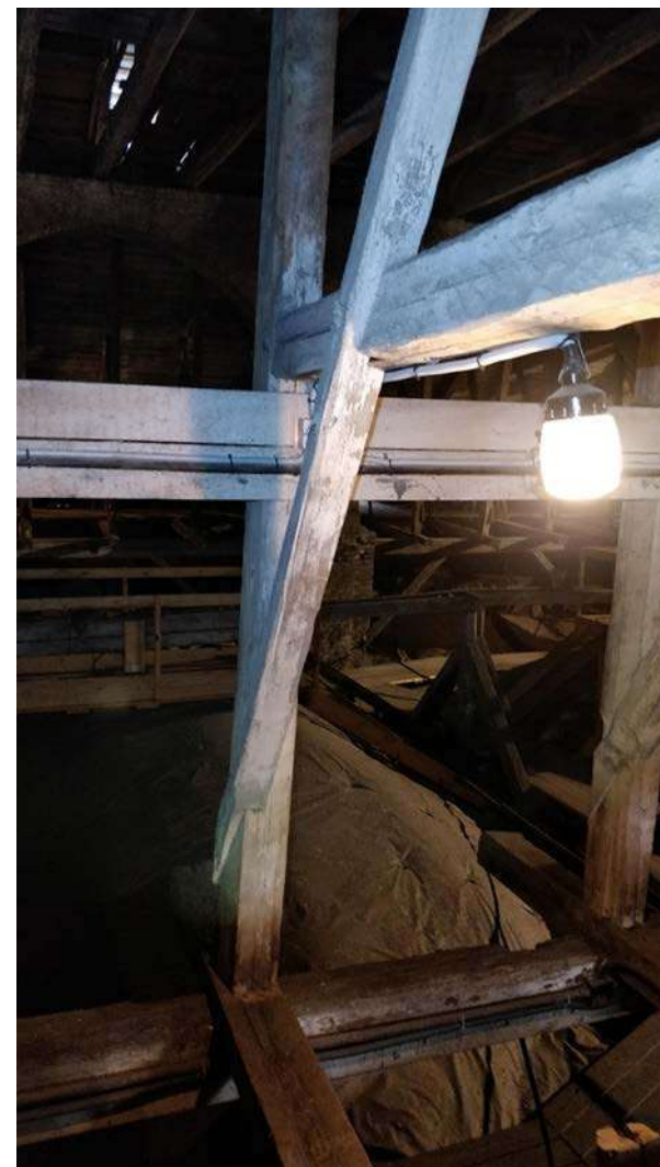
Nuotrauka Nr. 24. Apatinio stogo konstrukcijų fragmentas. Matosi statramsčiai atremti į apatinių sijų galus, kurie remiasi ant išilginio. Į statramstį remiasi spyris su rygelio ir gegne.
