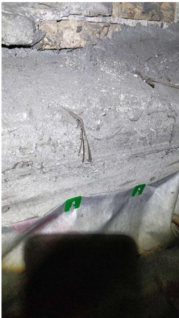
Nuotrauka Nr. 62. Monolitinis žiedas įrengtas sovietmečiu. Prie jo pritvirtinta smeigėmis skliautų difuzinė plėvelė
