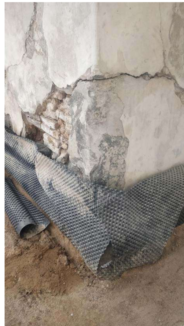
Nuotrauka Nr. 8. K. Sridvydo kiemo fragmentas. Šiuo metu vyksta kiemo tvarkymo darbai, kurių metu koplyčių (tarp ašių „E-F“) cokolis tvarkomas, įrengiama alsuojanti nuogrinda su hidroizoliaciniu sluoksniu ir drenuojanti membrana. Šioje vietoje esantis įtrūkimas tvarkomas pagal K. Sirvydo kiemo tvarkymo projektą.
