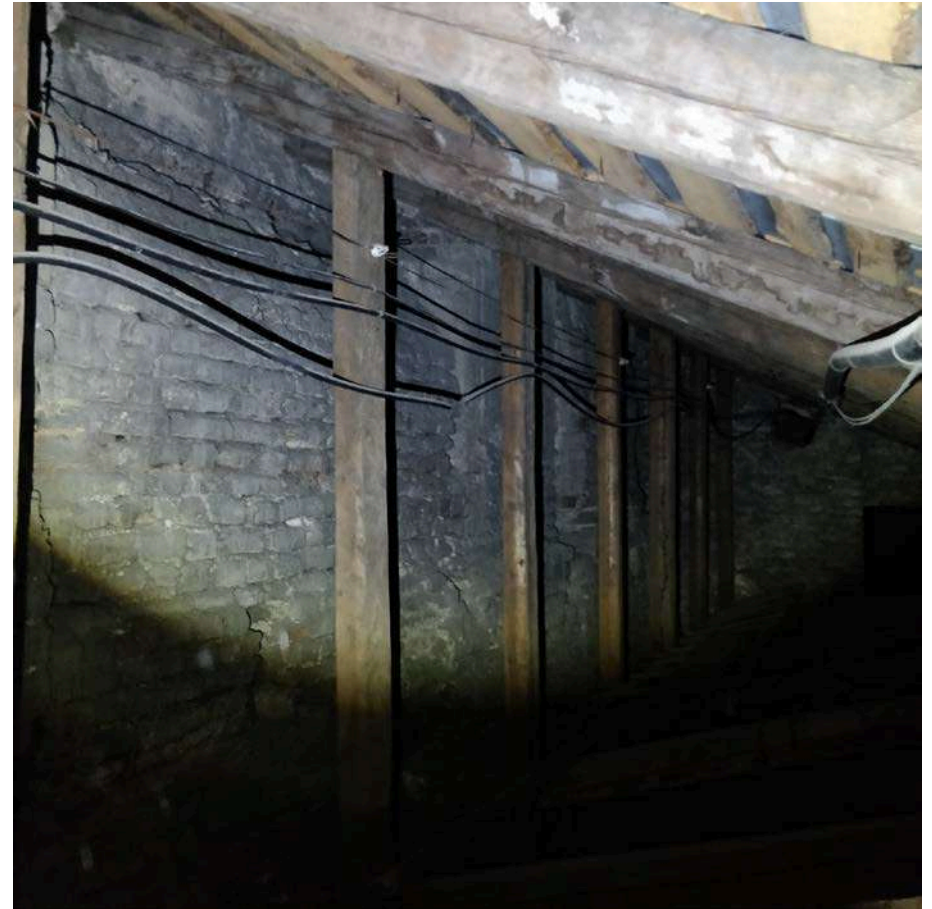
Nuotrauka Nr. 49. Koplyčių tarp ašių „E-F“ vidaus fragmentas. Stogo konstrukcijos remontuotos, stogo danga naujai klota. Būklė gera
