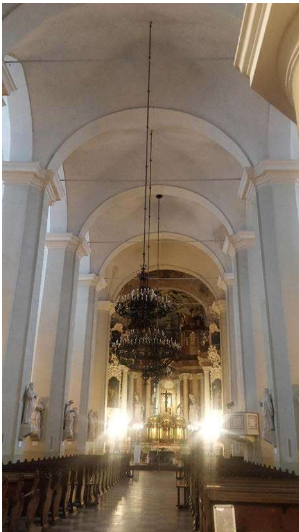
Nuotrauka Nr. 54. Šv. Jonų bažnyčios vidaus fragmentas tarp ašių „C-D“. Matosi vidaus templės tarp kolonų. Sietynai su pakėlimo mechanizmais įrengtais pastogėje. Bažnyčios perdangos kryžminiais skliautais. Grindys šildomos.
