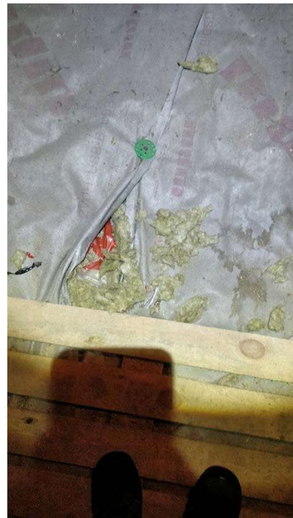
Nuotrauka Nr. 12. Skliautai apdengti 10 cm akmens vata, uždengta difuzine plėvele su smeigėmis. Būklė gera, išskyrus dalyje „9-11“.
