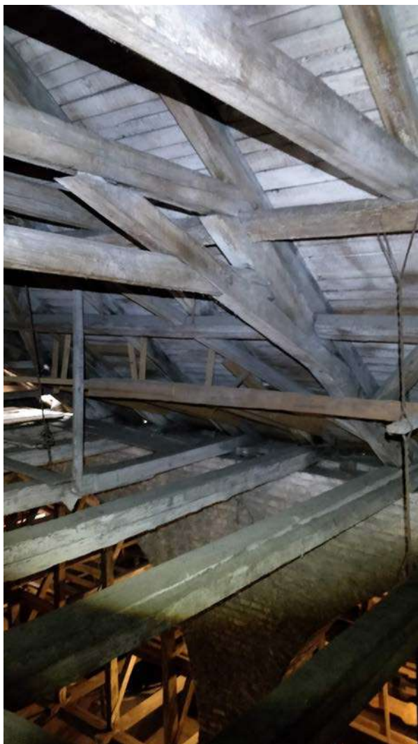
Nuotrauka Nr. 44. Viršutinio stogo pagrindinis rėmas su dvigubu rygeliu, konstrukciją spyriais ir gegnėmis. Stogo konstrukcija remiasi ant barokinio mūro arkados. Būklė gera, vietomis išjudėję mazgai, trūksta elementų. Stogo danga vienuolio tipo čerpių ant ištisinio medinio pakloto. Rėmų apatinės sijos geros būklės, yra įlinkių.
