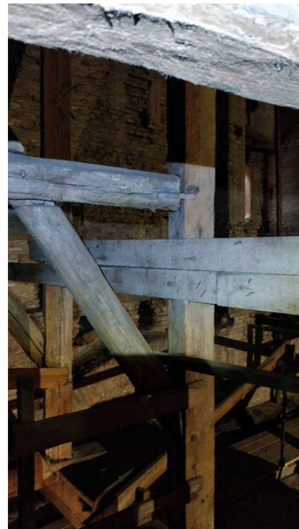
Nuotrauka Nr. 18. Apatinio vienšlaitės dalies stogo konstrukcijos rėmas. Matosi statramsčiai į juos atremti spyriai (aukščiau) ir atremti rygeliai. Lentos sukaltos elektros laidams.
