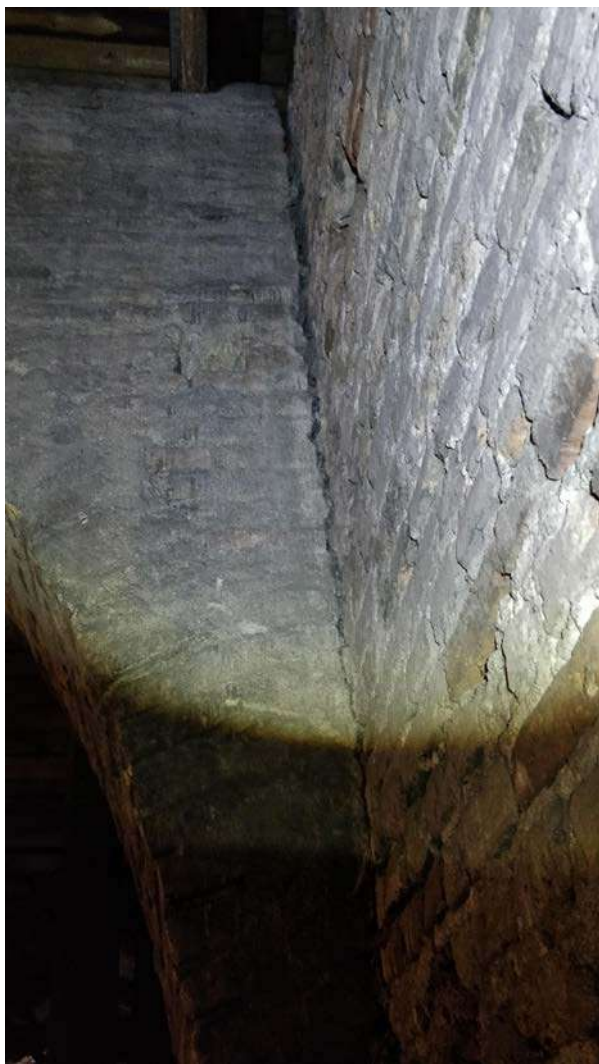
Nuotrauka Nr. 29. Sienų mūro ašių „B“ ir „1“ sankirtoje. Šioje vietoje gotikinis frontono mūras neturi sąryšio su barokine arkada matosi plyšys.
