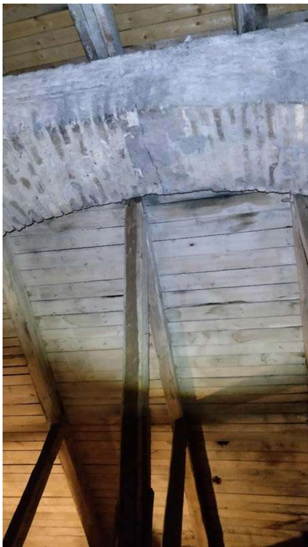
Nuotrauka Nr. 27. Matosi barokinė arkada. Arkoje užfiksuotas plyšys. Apatinio stogo gegnė atremta į arką.
