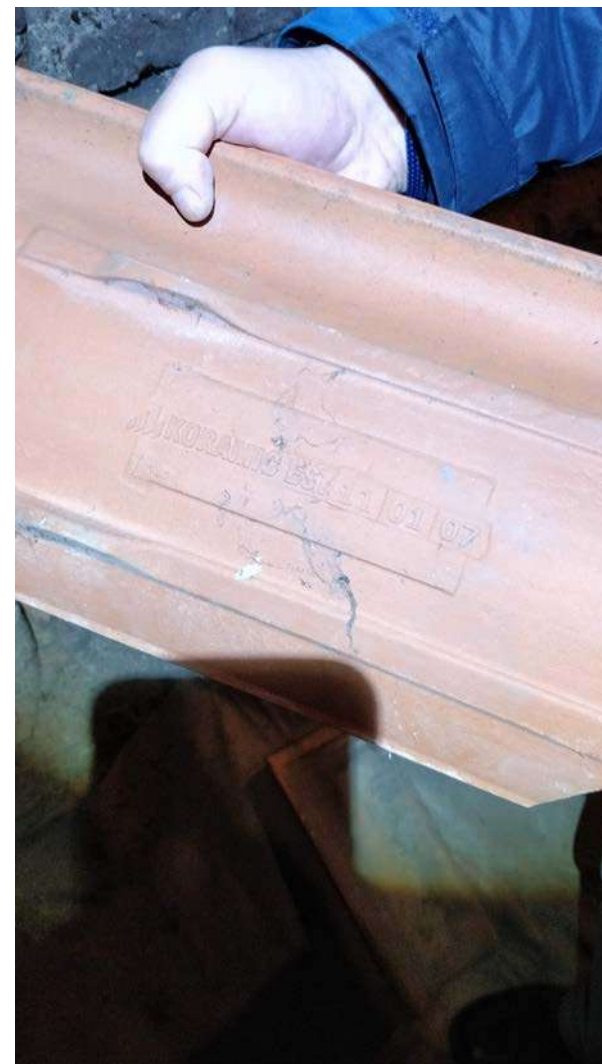
Nuotrauka Nr. 61. S pavidalo čerpės. Ant jų pažymėta: KORAMIC EST 11/01/07. Jomis dengti koplyčios stogai tarp ašių „A-B“
