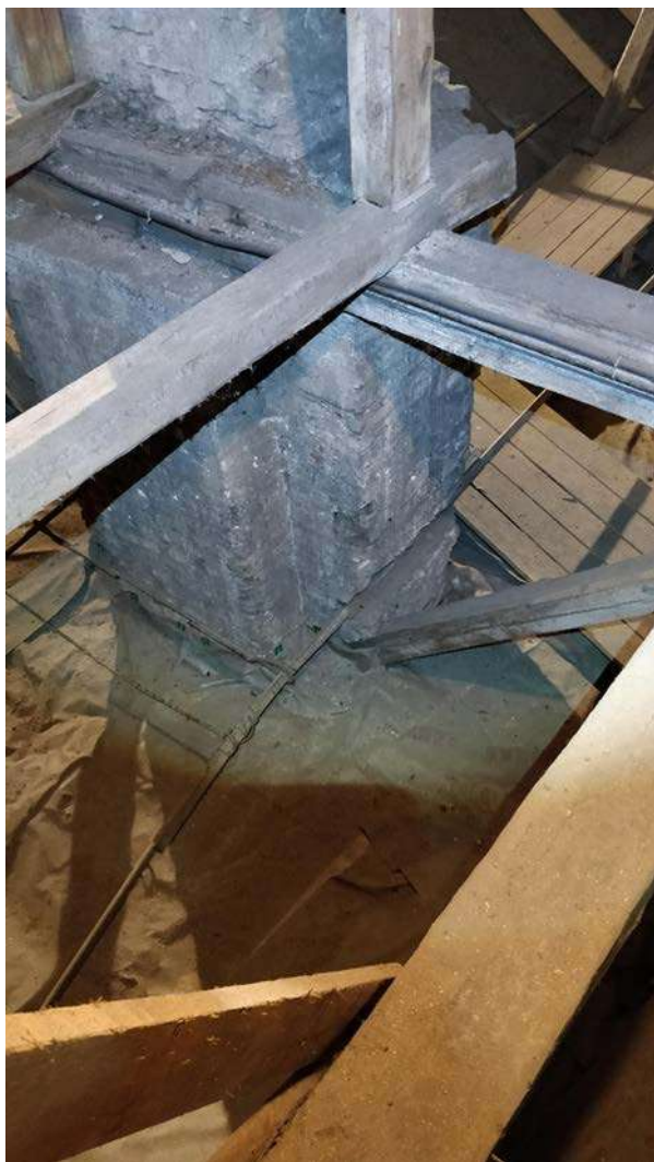
Nuotrauka Nr. 19. Pastogės barokinės arkados arkų padai. Ant arkados remiasi stogo konstrukcijų rėmai. Matosi templės ties arkų padų apačia.
