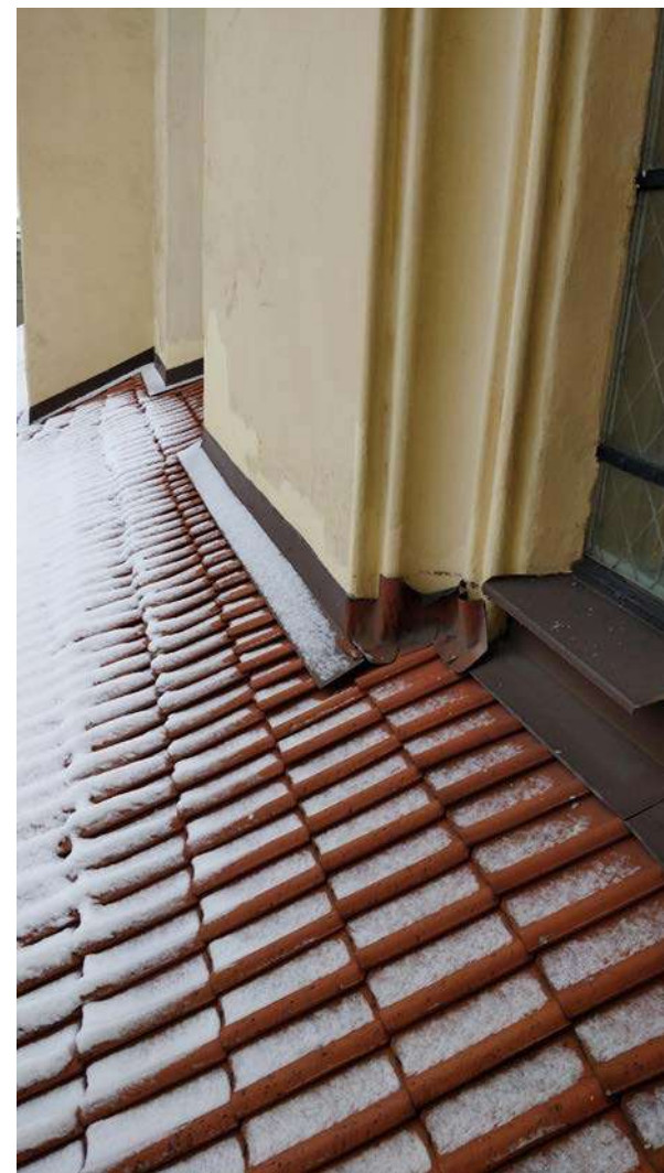
Nuotrauka Nr. 51. Koplyčių stogų (tarp ašių „A-B“) S pavidalo stogo danga su apskardinimu. Stogas danga geros būklės.
