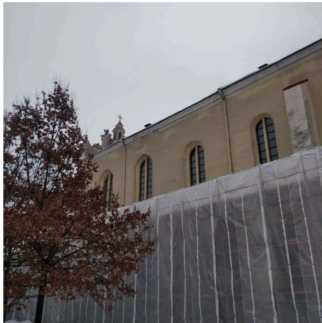
Nuotrauka Nr. 10. K. Sridvydo kiemo fragmentas. Šiuo metu vyksta kiemo tvarkymo darbai, kurių metu koplyčių (tarp ašių „E-F“) cokolis tvarkomas. Virš koplyčių matosi bažnyčios fasadas su esamais lietaus nuvedimo lietvamzdžiais ir lieltoviais, vietomis karnizai pažeisti drėgmės. Karnize yra atskiri įtrūkimai.
