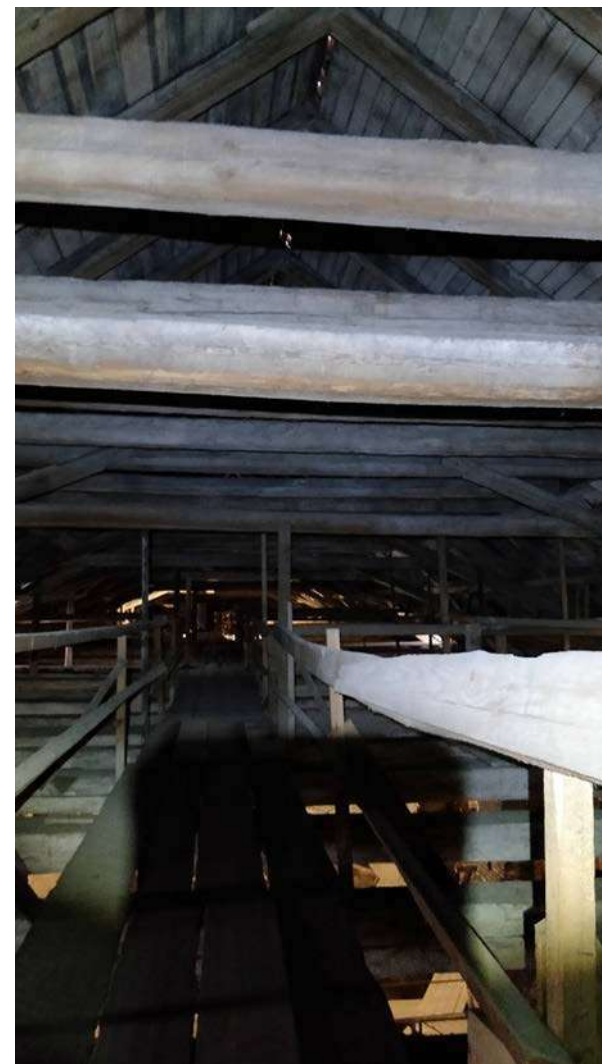
Nuotrauka Nr. 41. Viršutinio stogo fragmentas. Matosi pagrindiniai ir antraeiliai paladijaus rėmai. Viršutinio stogo pastogėje įrengti aptarnavimo takas (medinių konstrukcij), remontuotas.
