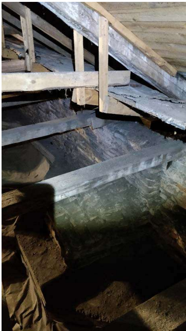
Nuotrauka Nr. 15. Apatinio stogo karnizo dubliuojanti medinė konstrukcija nukreipianti kritulius karnizo zonoje. Įrengta folgoizolo danga ant medinių lentų.
