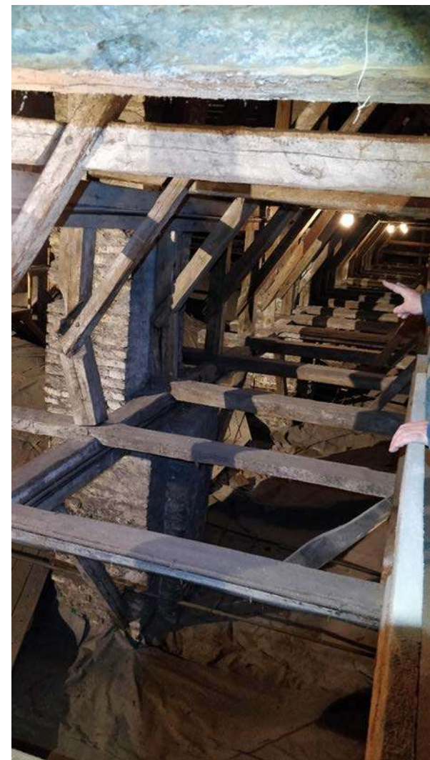
Nuotrauka Nr. 14. Apatinio stogo remstinė konstrukcija, vietomis stratomščiai išlūžę dėl neteisingai įrengtų spyrių.
