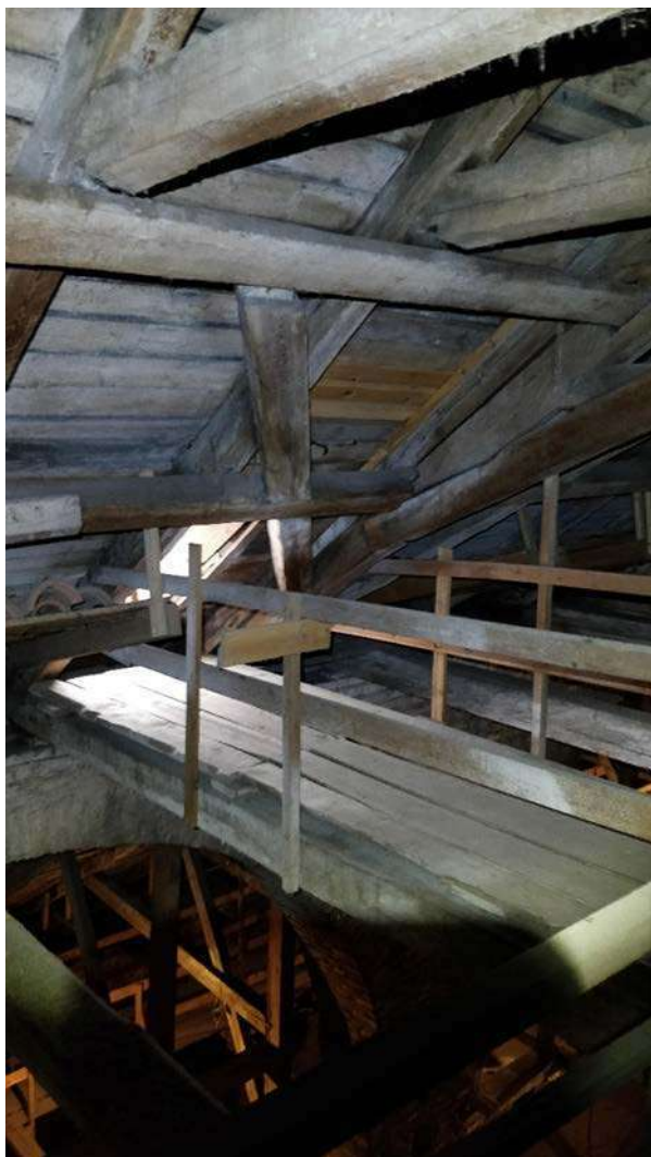
Nuotrauka Nr. 42. Viršutinio stogo tūriniai stoglangiai ir patekimas prie jų iš vidaus pusės. Matosi viršutinio stogo vėjo ryšiai. Pro neuždengtus langus patenka sniegas ir kiti krituliai. Stogo aptarnavimo takas remontuotas. Dalis langų yra įstiklinta.
