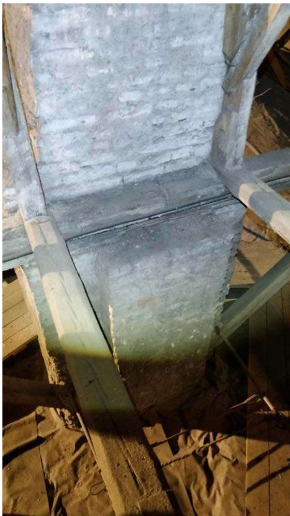
Nuotrauka Nr. 17. Pastogės barokinės arkados arkų padai. Ant arkados remiasi kurių stogo konstrukcijų rėmai. Matosi templės ties arkų padų apačia.
