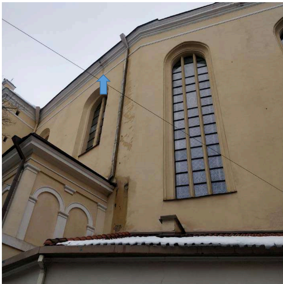
Nuotrauka Nr. 3. Bažnyčios fragmentas iš Šv. Jonų g. pusės. Ties lietvamzdžiais sienos dalis veikiama drėgmės, dėl nesandarių lietvamzdžių ir kritulių taškymosi. Lietvamzdžiai kvadratinės formos. Karnize užfiksuotas sgraminis įtrūkimas.
