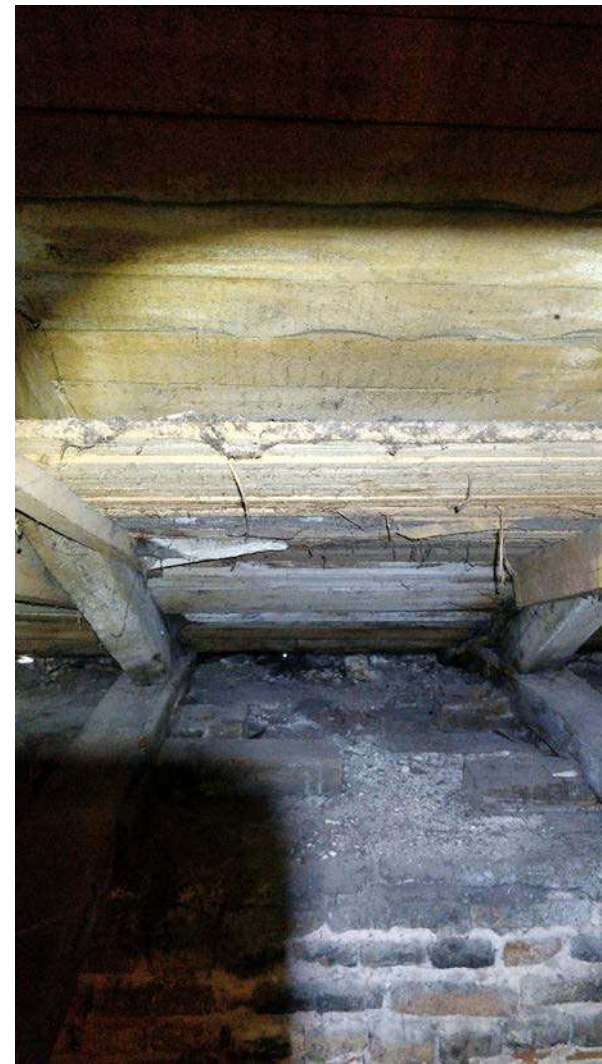
Nuotrauka Nr. 16. Matosi stogo dangos konstrukcija iš vientiso lentų pakloto. Stogo konstrukcija santvarinė atremta ant mūro be izoliacijos. Šioje vietoje mūrtašio nėra.
