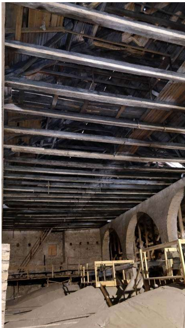
Nuotrauka Nr. 40. Vaizdas į viršutinio stogo konstrukcijų rėmus. Tolumoje matosi kopėčios įrengtos patekti į viršutinį stogą. Viršutinio stogo rėmų apatinės sijos remiasi ant arkados mūro, ties gegnių galais įrengti neištisiniai mūrtašiai tiesiai ant mūro. Sijos įlinkusios.
