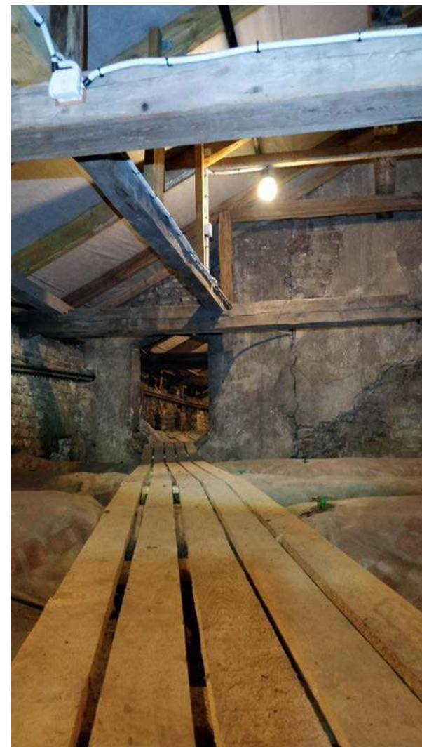
Nuotrauka Nr. 47. Koplyčių stogų fragmentas tarp ašių „A-B“. Stogo konstrukcijos ir danga keista nepriklausomybės laikais. Stogo danga S pavidalo čerpių su antrine difuzinės plėvelės danga. Medinės laikančios konstrukcijos, rygeliai, gegnės ir statramsčiai keisti remonto metu fragmentiškai pagal poreikį. Įrengti aptarnavimo takai ir apšvietimas.
