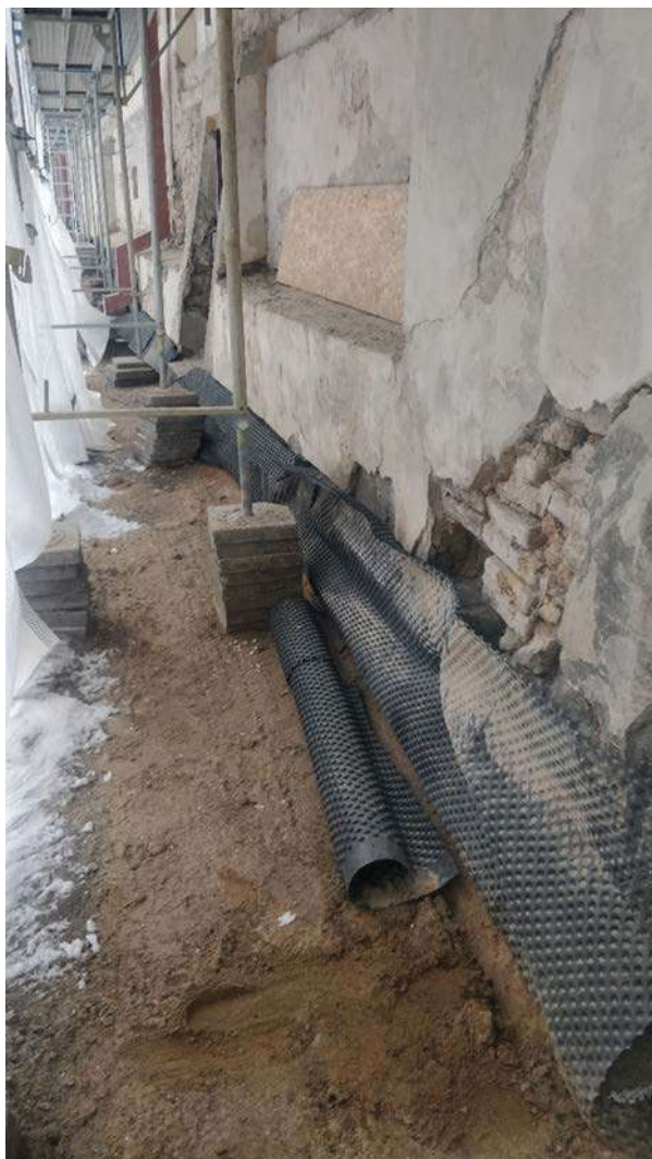
Nuotrauka Nr. 7. K. Sridvydo kiemo fragmentas. Šiuo metu vyksta kiemo tvarkymo darbai, kurių metu koplyčių (tarp ašių „E-F“) cokolis tvarkomas, įrengiama alsuojanti nuogrinda su hidroizoliaciniu sluoksniu ir drenuojanti membrana.
