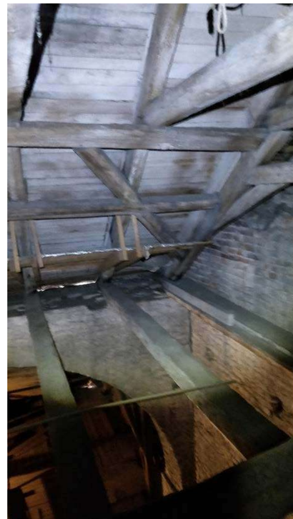
Nuotrauka Nr. 43. Viršutinio stogo fragmentas prie ašies „11“ šioje vietoje yra pastebimas didesnis drėgmės patekimas į vidų, kampai smarkiai įmirkę.
