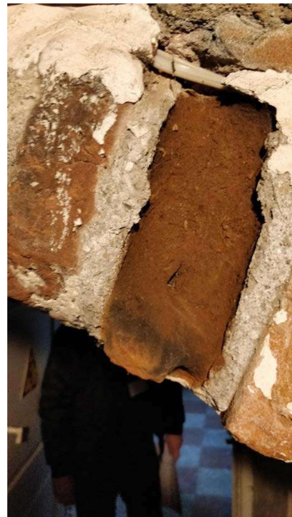
Nuotrauka Nr. 53. Pietinio bokšto vidaus gotikinio mūro fragmentas. Šioje nuotraukoje matosi blogai išdegtos dalis plytų, eroduotos.
