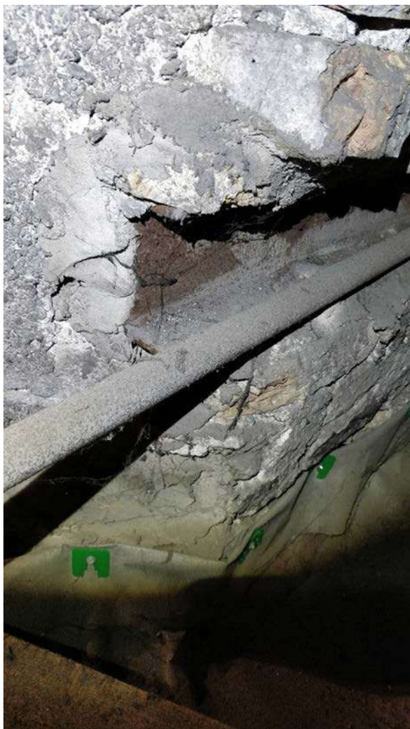
Nuotrauka Nr. 39. Templės kreipiamasis lovys, įrengtas arkos pado mūre, h \approx 14\text{cm} , templė \varnothing 3\text{cm}
