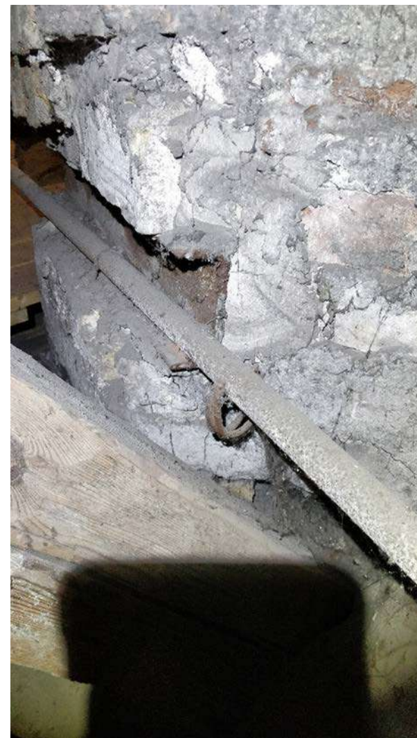
Nuotrauka Nr. 39. Templės kreipiamasis lovys, įrengtas arkos pado mūre, h \approx 14\text{cm} , templė \varnothing 3\text{cm}
