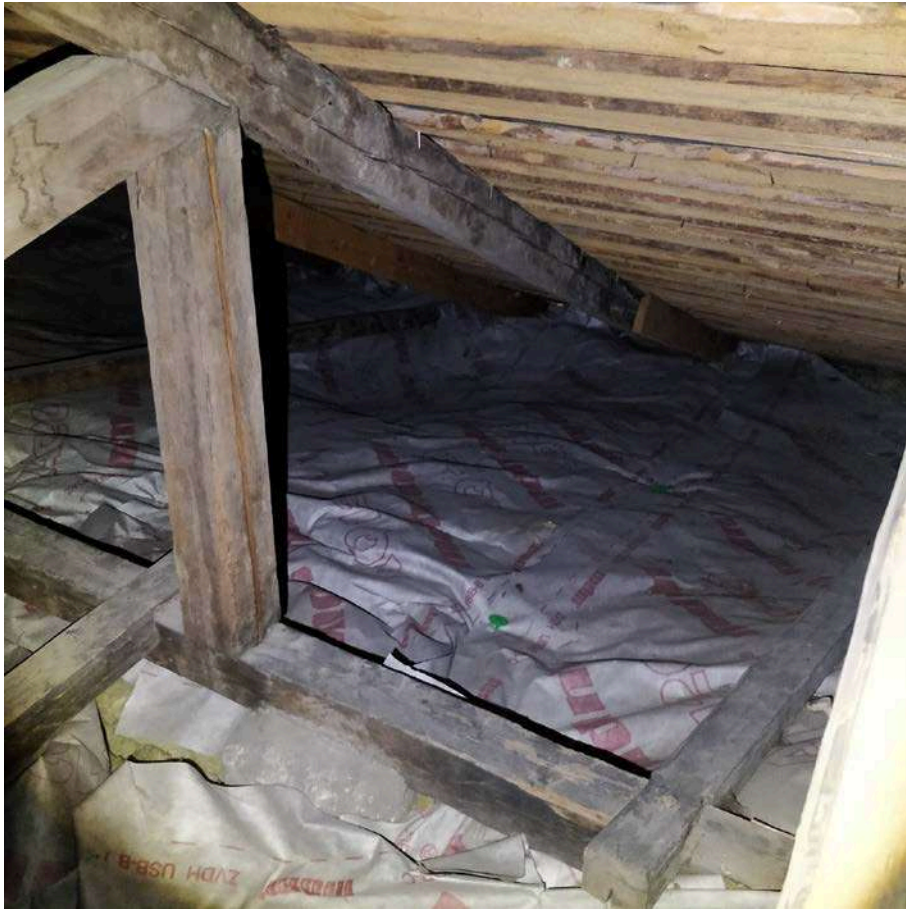
Nuotrauka Nr. 48. Koplyčių tarp ašių „E-F“ vidaus fragmentas. Stogo konstrukcijos remontuotos, stogo danga naujai klota. Būklė gera. Apranavimo takai neįrengti. Perdanga apšiltinta akmenų vatos plokštemis ir difuzine plėvele su smeigėmis. Stogo danga: puralu dengta skarda ant išretinto neobliuotų lentų pakloto.
