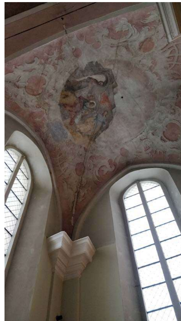
Nuotrauka Nr. 57. Skliautas virš chorų, tarp ašių „D-E“ ir „1-3“. Šioje vietoje yra matomas įtrūkimas. Matosi masverkai su vitražais ir įstiklinimu stiklo paketais. Šioje vietoje skliaute yra pratekėjimų
