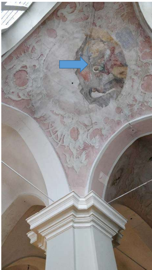
Nuotrauka Nr. 56. Kryžminis skliautas virš chorų, tarp ašių „D-E“ ir „1-3“. Šioje vietoje yra matomas įtrūkimas.
