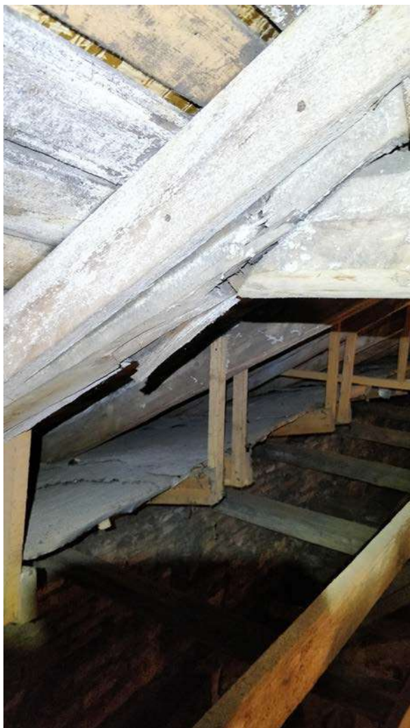
Nuotrauka Nr. 21. Apatinio stogo konstrukcijos fragmentas su dubliuojančiu karnizu. Gegnės ir rygelio sujungimo vieta išjudėjusi, gegnė suplyšusi, gegnė stiprinta antdėklu.
