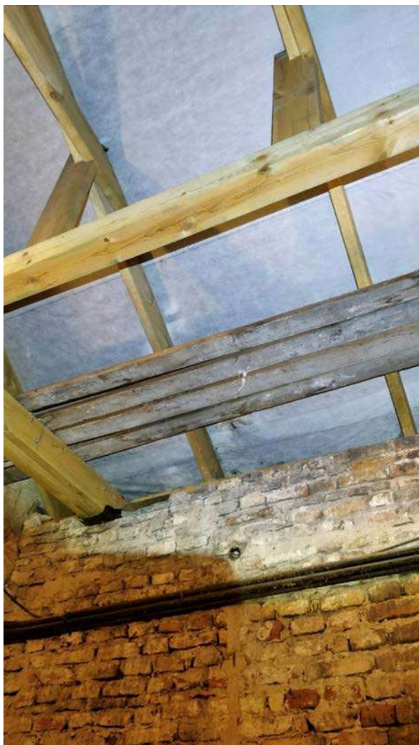
Nuotrauka Nr. 46. Koplyčių stogų fragmentas tarp ašių „A-B“. Stogo konstrukcijos ir danga keista nepriklausomybės laikais. Stogo danga S pavidalo čerpių su antrine difuzinės plėvelės danga. Medinės laikančios konstrukcijos, rygeliai, gegnės ir statramsčiai keisti remonto metu fragmentiškai pagal poreikį.
