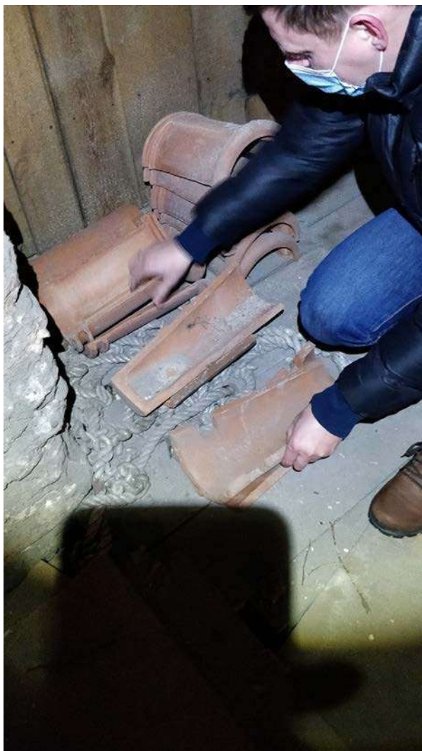
Nuotrauka Nr. 60. Jašiūno fabriko gamybos čerpės „vienuolis-vienuolė“. Uždėtas ant pagrindinio bažnyčios stogo.
