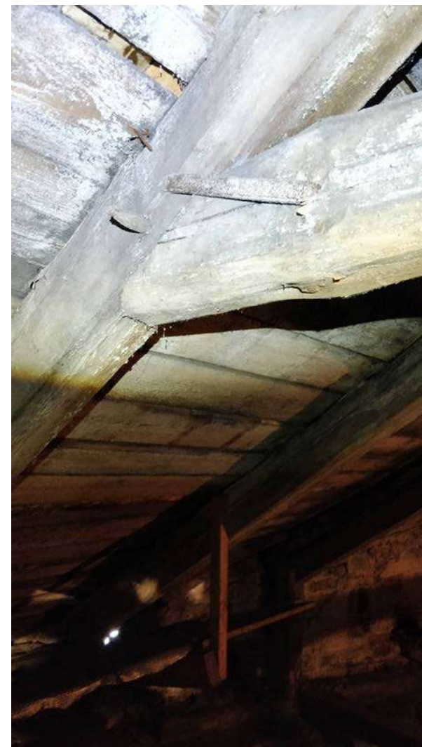
Nuotrauka Nr. 26. Apatinio stogo rėmų jungimo mazgas, su mediniu kaiščiu ir metaline kabe.
