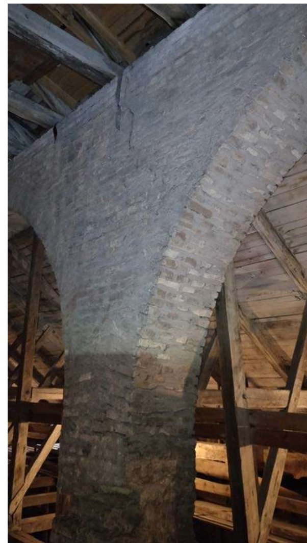
Nuotrauka Nr. 28. Matosi barokinė arkada ant kurios remiasi viršutinio stogo konstrukcija. Arkoje užfiksuotas plyšys. Dalis arkų kolonų turi mūro netekčių.
