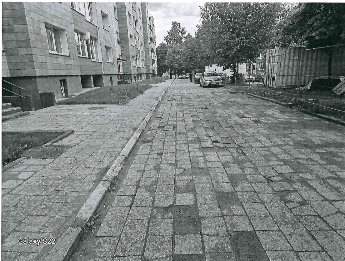
2 pav. Esama šaligatvių būklė
