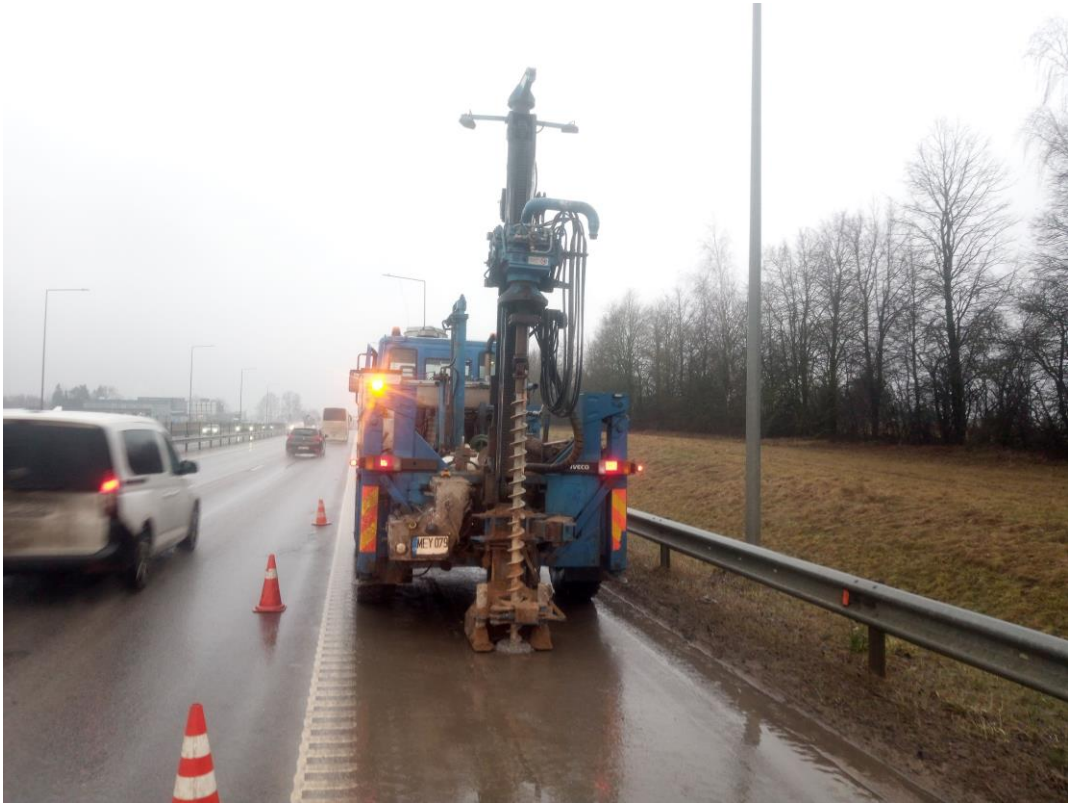
1 pav. Lauko darbai ties gręžiniu Gr.5
