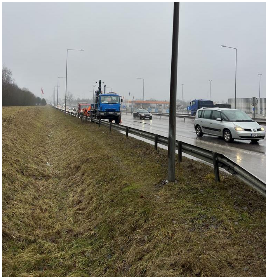
2 pav. Lauko darbai ties gręžiniu Gr.8
