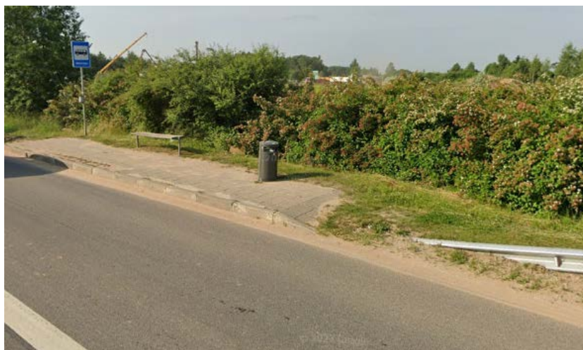
pav. 2. Esama autobusų sustojimo vieta greitėjimo juostoje.
