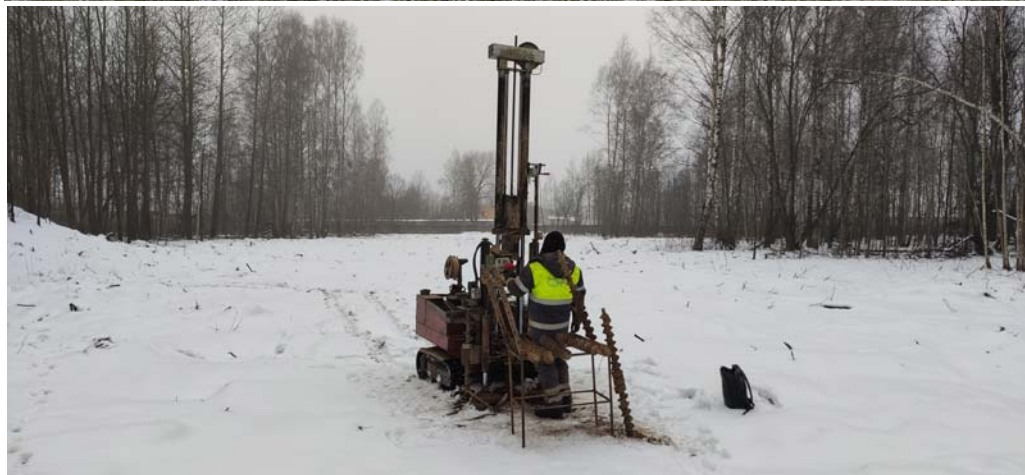
3 pav. Inžinerinių geologinių ir geotechninių tyrimų vietos.
