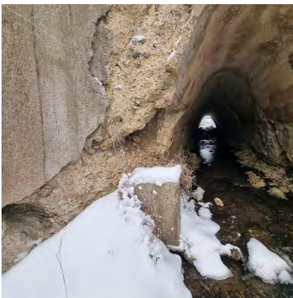
F7 Paviršinio betono paviršiaus pertrynimo netektys žemupio fasade.
