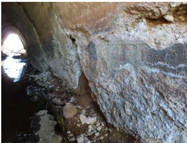
3 pav. Dešinė pusė, gilūs ištrupėjimai
