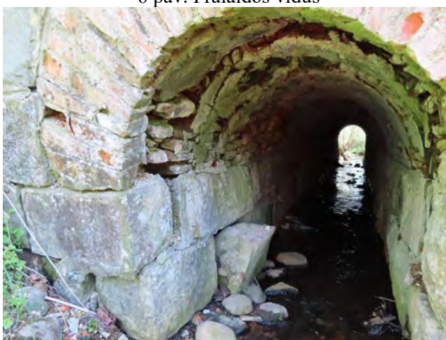
8 pav. Iškritęs/išstumtas akmuo kairėje pusėje
