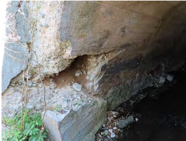
3 pav. Dešinė pusė, gilūs ištrupėjimai
