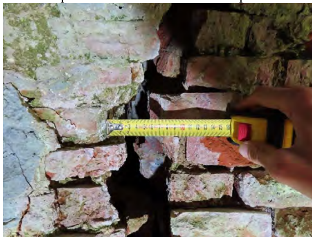
5 pav. Plyšys dešinėje pusėje
