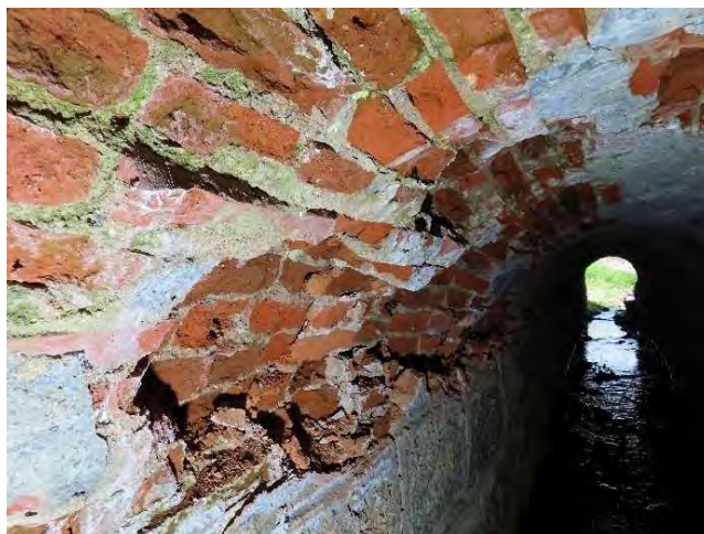
5 pav. Plyšys dešinėje pusėje
